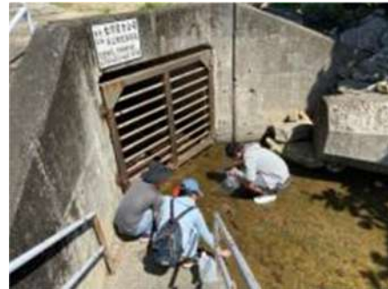
圖 2 核三廠逕流廢水放流口
