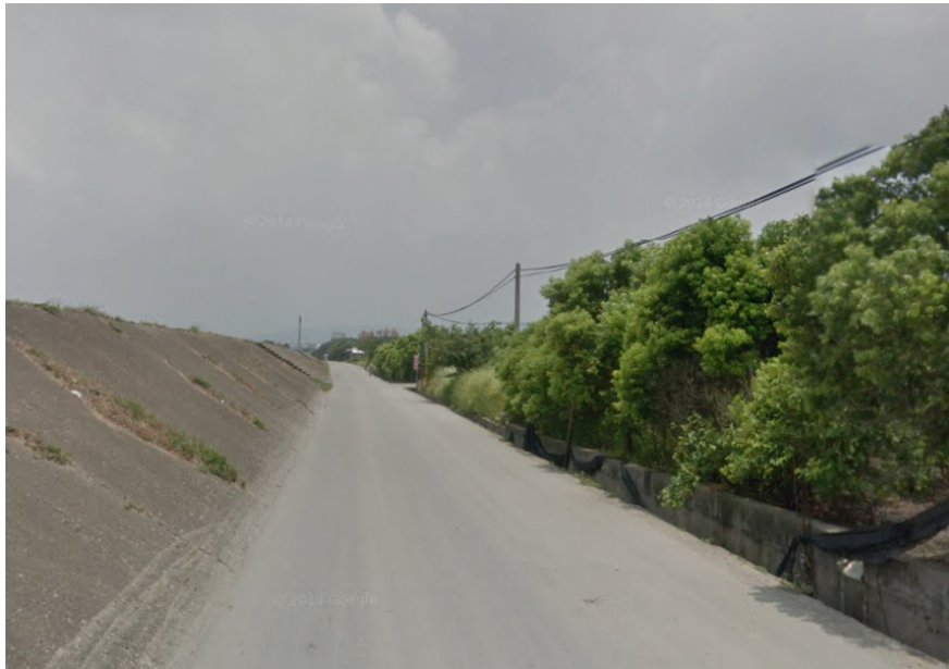
圖 3-19 臺中市后里區起降場地(11/28)作業情形
