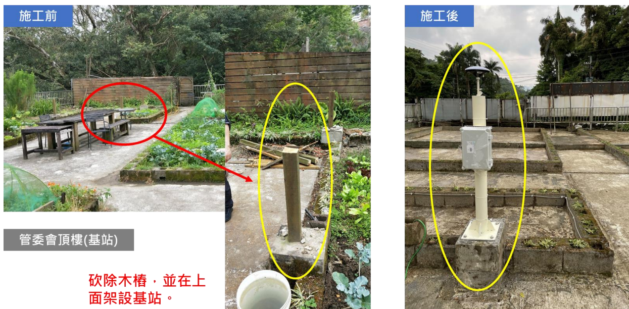
圖3-10 GNSS 測站設備安裝前、後現場照片(TTL201 基站)
