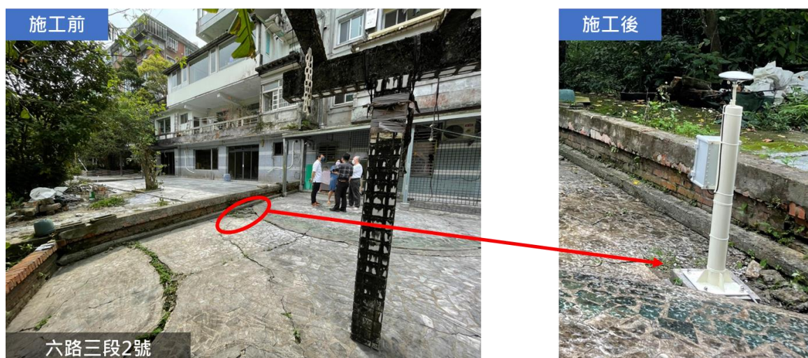
圖3-12 GNSS 測站設備安裝前、後現場照片(TTL203 固定站)
