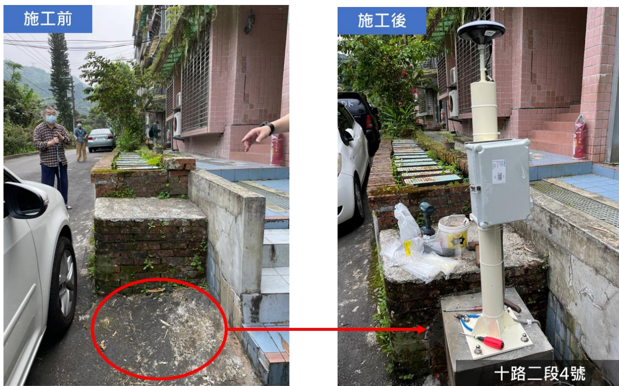
圖3-11 GNSS 測站設備安裝前、後現場照片(TTL202 固定站)
