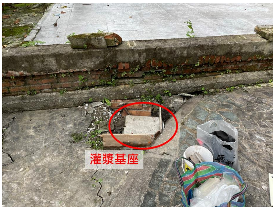
圖3-9 以灌漿方式製作穩固基座
