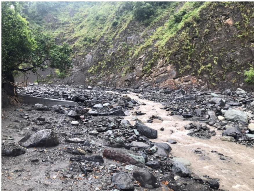
圖 2.11 距離河口約 800 公尺的第一個攔沙壩
