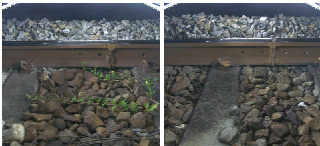
圖 4.14 合成鉚接處裂縫示意圖
