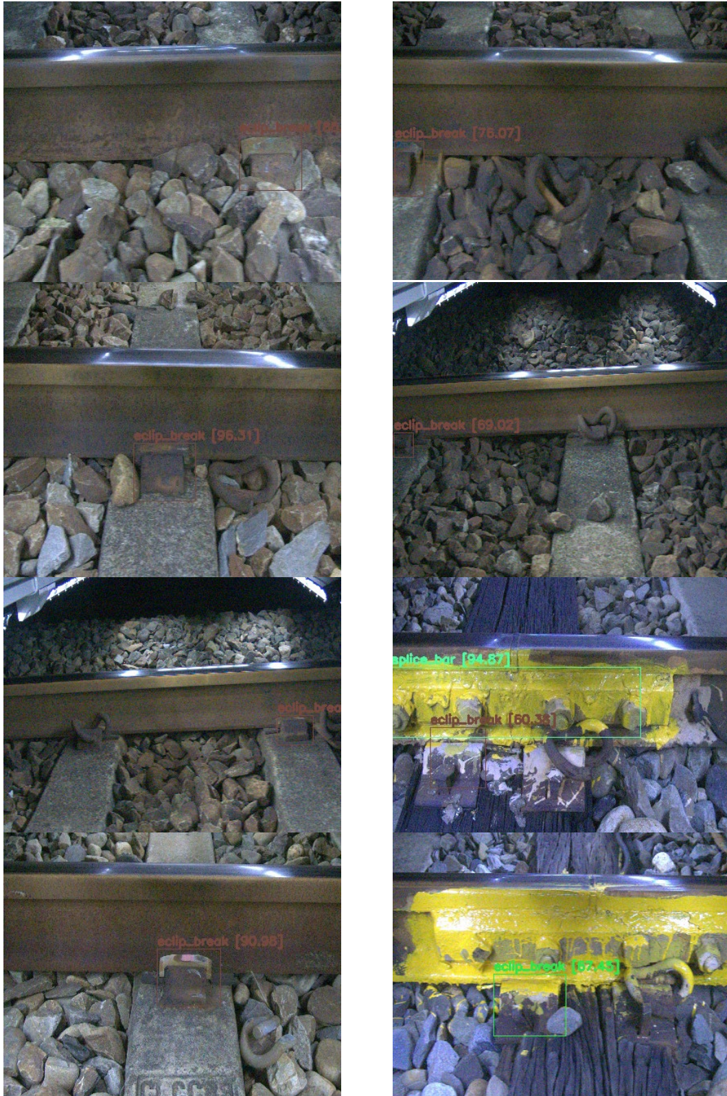
圖 4.38 第三階段臺中現地驗證檢出紀錄—e 扣夾缺失
