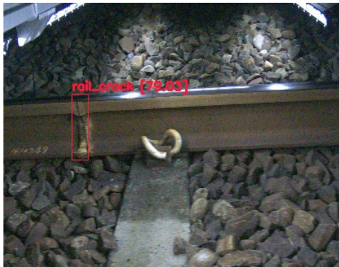
圖 4.40 第三階段臺中現地驗證檢出紀錄—魚尾鉸缺失
