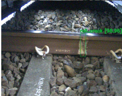
圖 4.41 第三階段臺中現地驗證檢出紀錄—鋼軌裂縫(模擬)
