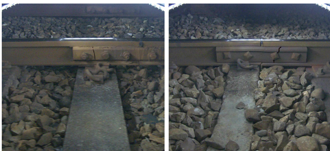
圖 4.15 合成魚尾鉸裂縫示意圖
