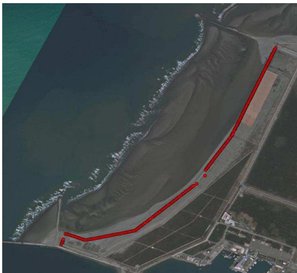
圖 1 北防砂堤構造物多點巡航 POI 圖
