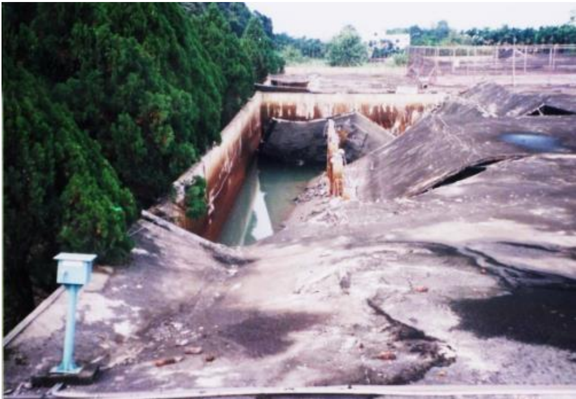
圖 2-3 九二一地震豐原第一淨水場沉澱池損害(台灣自來水公司，2000)
