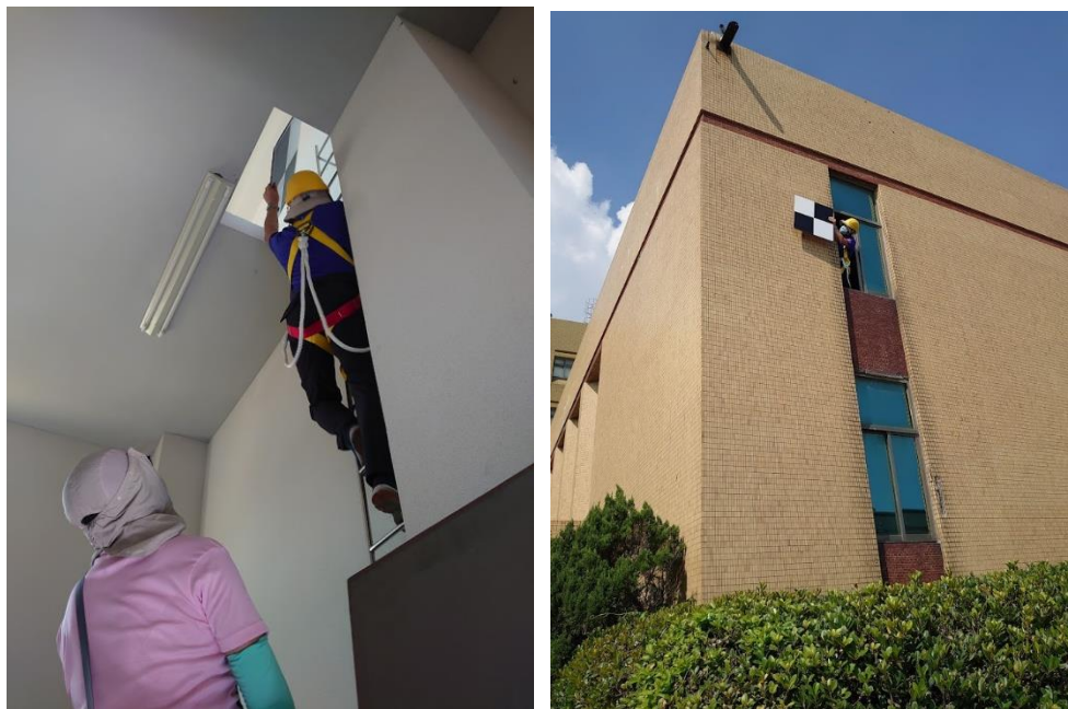
圖 6-5 安裝牆上的磁吸式校正標
