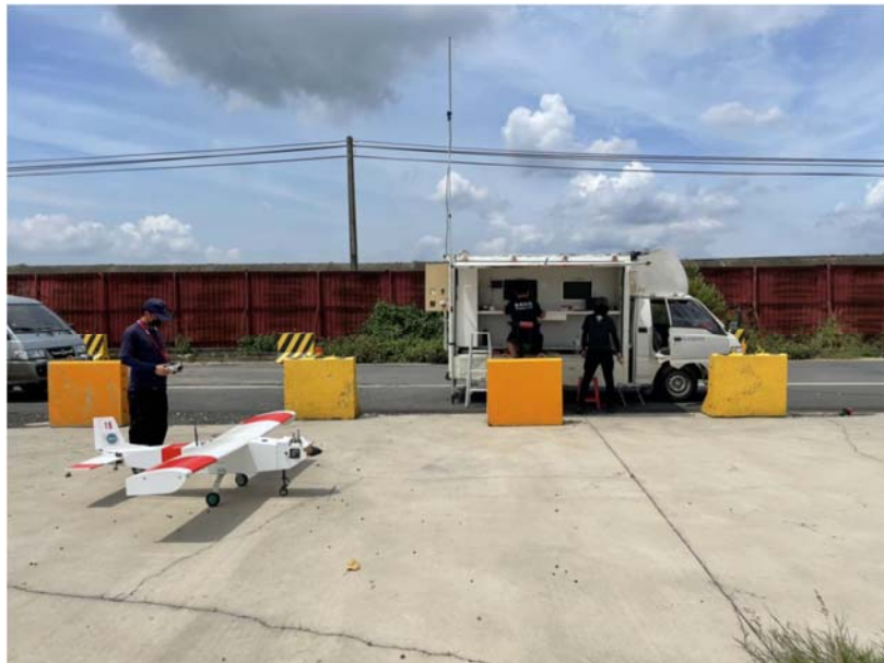
圖 3-7 臺中市豐原區起降場地作業情形
