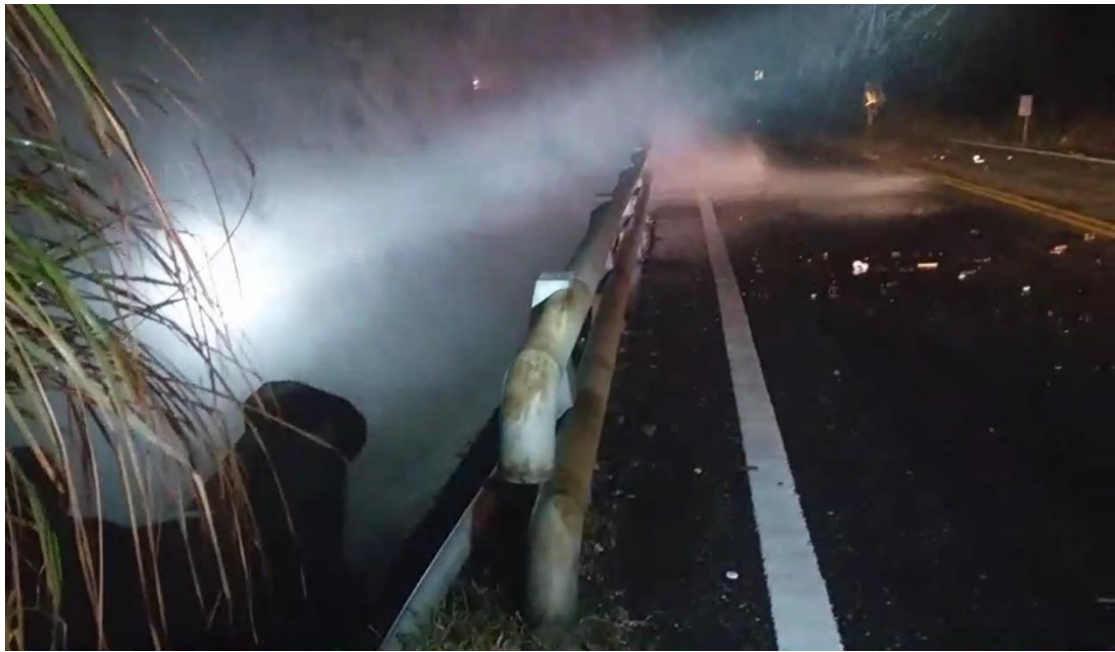
圖 2.61 61K+400 附近的浪襲影像(公路總局第四區養護工程處提供)
