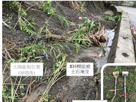
ID2&3崩塌後 模組外構狀況
