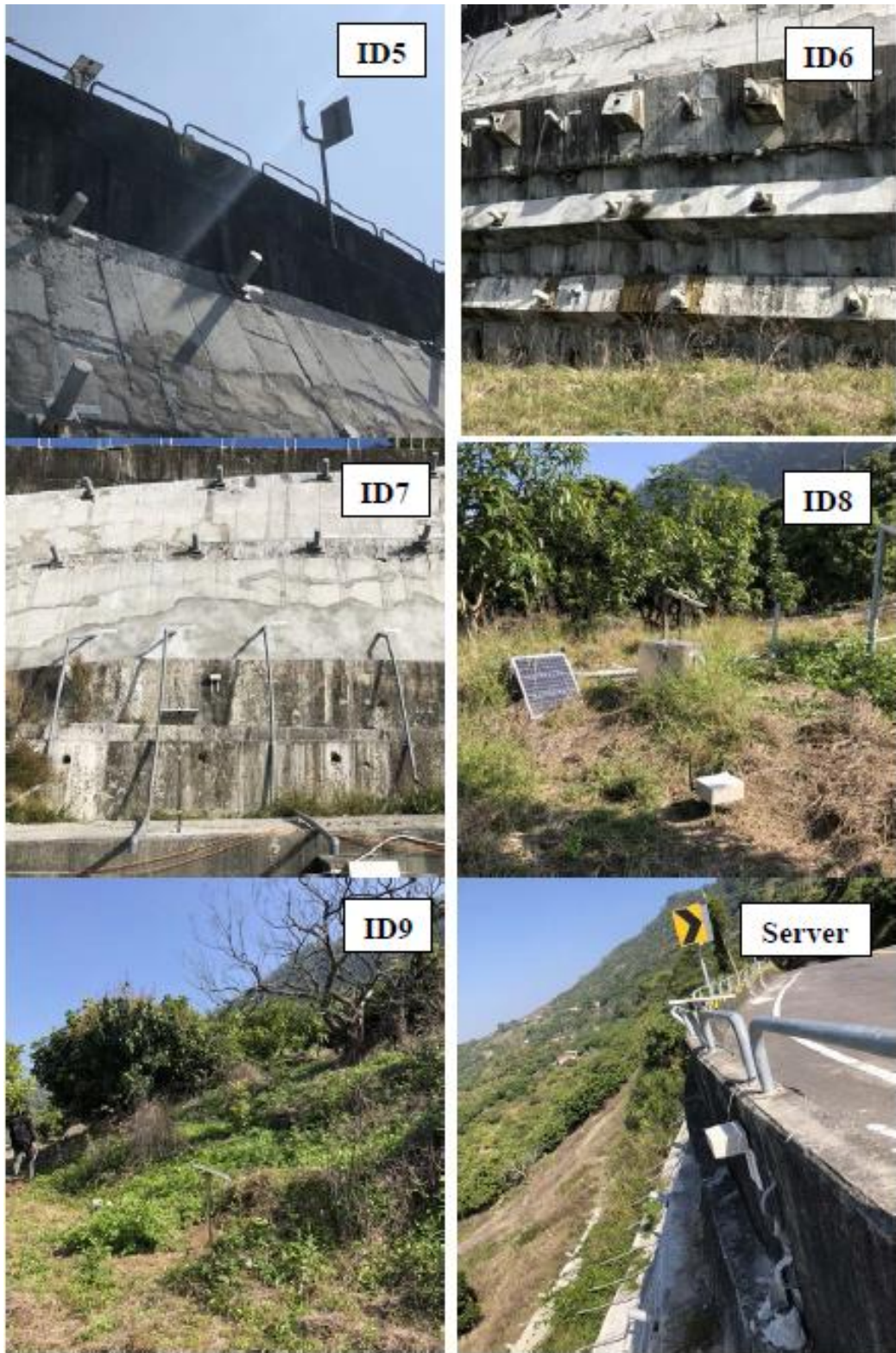
圖 5.14 南市道 175 線 25.5k 場址監測模組現場架設圖(2/2)
