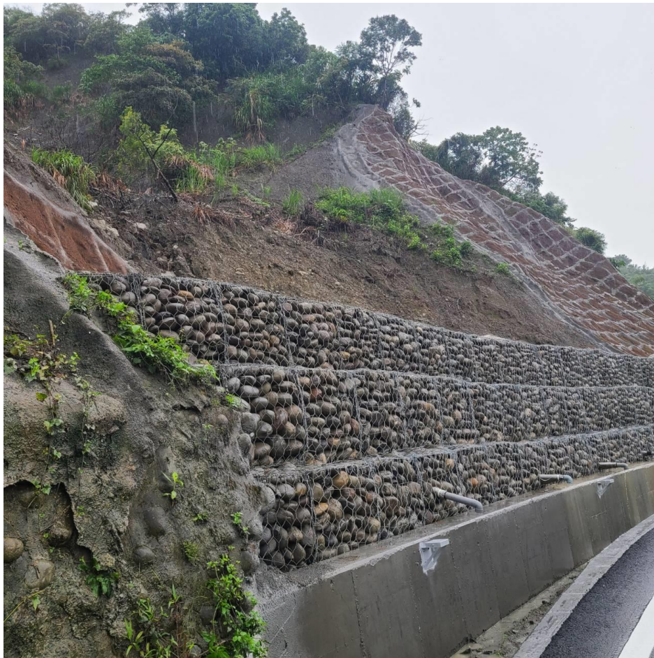
圖 4.31 台 20 線 50.7k 2021/10/15 邊坡整治現況
