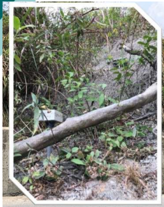
50K+740 原始坡面坡角45°
