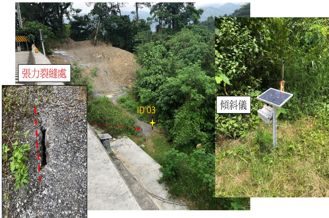
圖 1.2 增設台 20 線道路下邊坡土壤表層傾斜儀一組
