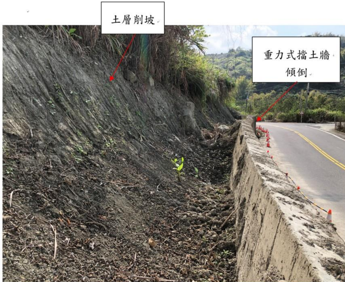
圖 4.21 台 20 線 50.7k 邊坡 4/14 邊坡現況
