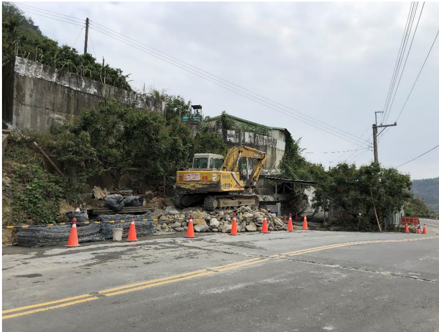
圖 6.44 110 年南市道 175 線 25.5k 現場進行災害復建工程施工照
