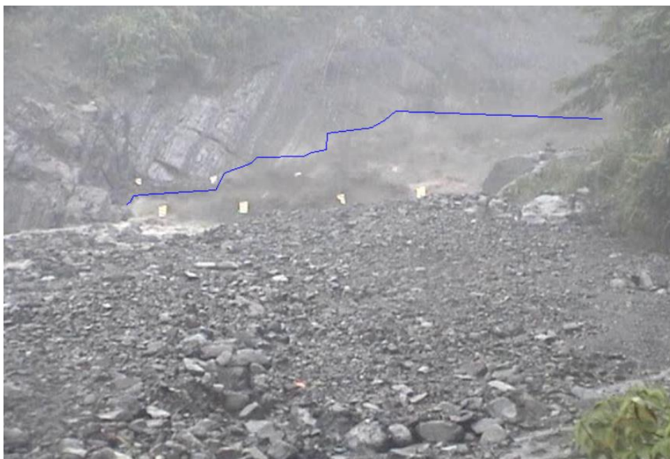
圖 3.11 土石流右岸之泥位線
