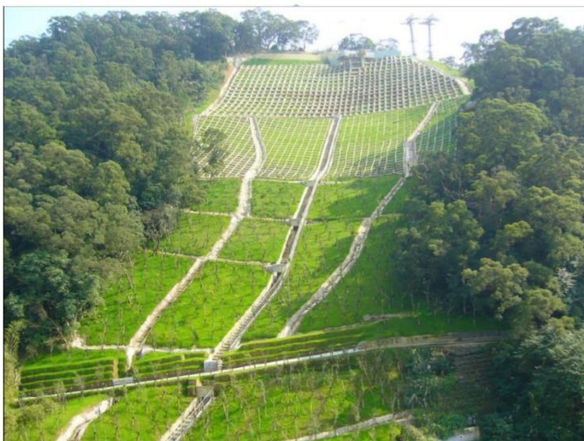
圖 4-1 空纜車 T16 塔柱邊坡整治工程(林冠良 2015)
