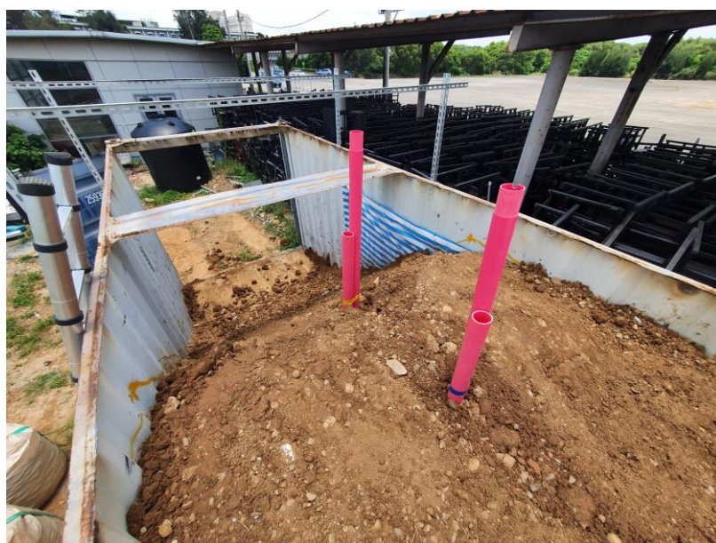
圖 3-5 大尺寸試驗模型傾斜管埋設完成
