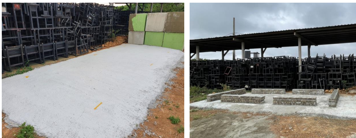
圖 3-2 貨櫃下方基礎與支撐
