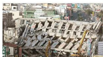
105年2月6日美濃大地震，造成台南市永康區維冠大樓倒塌，共115人罹難
