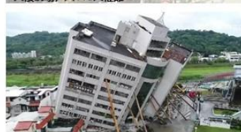
107年2月6日花蓮地震造成雲門翠堤大樓倒塌造成大樓內14人死亡，花蓮地檢署認為設計不良與偷工減料是倒塌主因。
