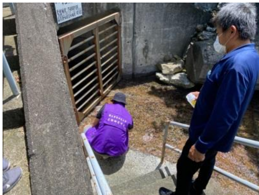
(i)雨水渠道口-排放水
