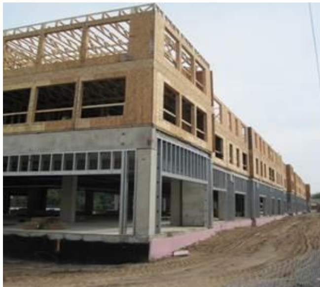
圖 3.1 建築物上層為木構造、下層為鋼筋混凝土結構
