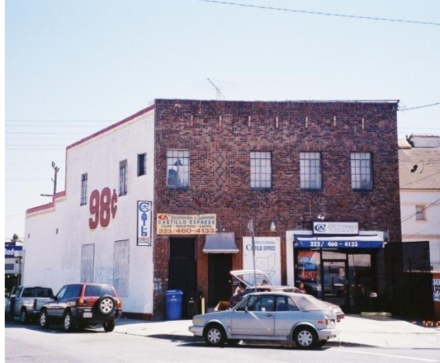
圖 3.2 建築物內部結構(承重牆及樓板)為木構造、外牆為磚構造
