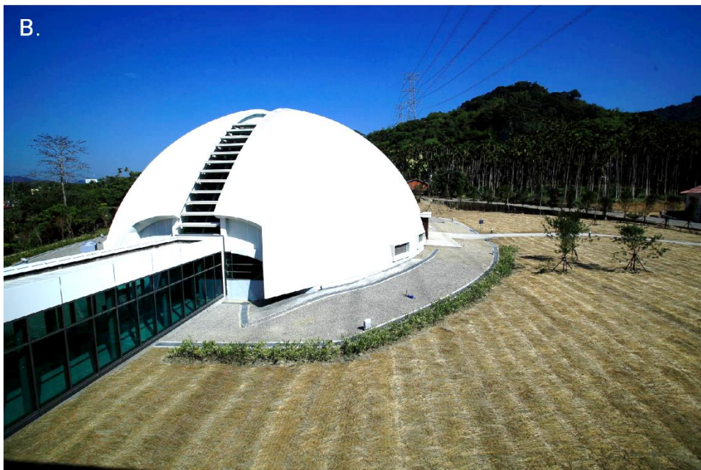
圖 2.4.1 車籠埔斷層保存園區中重開挖的竹山槽溝及其保護結構。A.竹山槽溝於保護結構中的場景。B.保護竹山槽溝的人造結構外觀。
