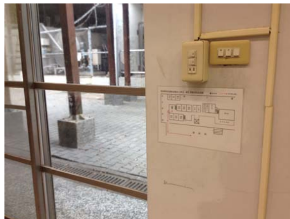
圖 26、南投縣埔里鎮桃源國小於各樓層張貼避難疏散圖
