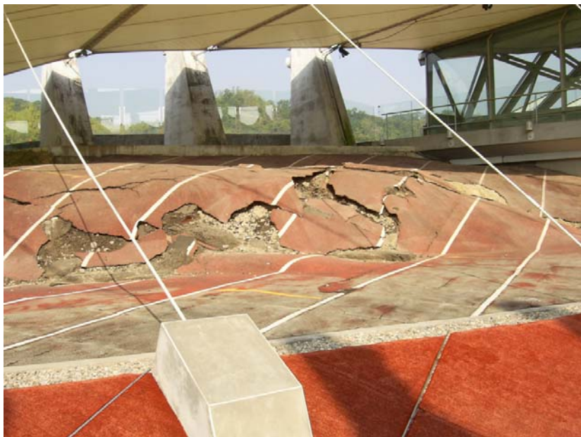
圖 2.10 921 大地震造成地表斷層上下錯動
