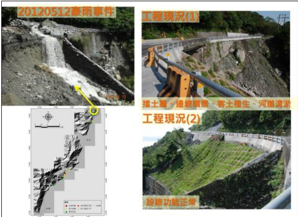
圖 4.37 台 9 線蘇花公路樁號 144K+750 土石流災害狀況與復建工程現況圖
