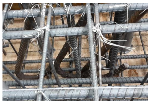
圖 3-48 對角向鋼筋埋入基礎
