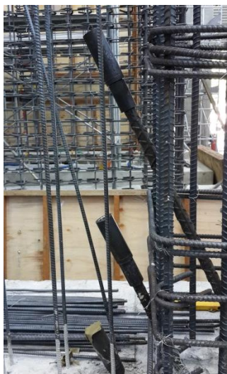
(a) 埋入基礎部分等待續接
