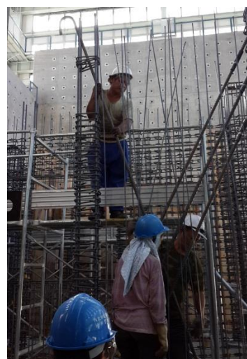
(d) 對角向鋼筋搭配邊界構材組裝
