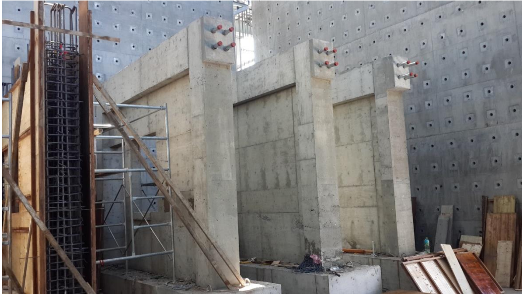
圖 3-59 試體拆除模板
