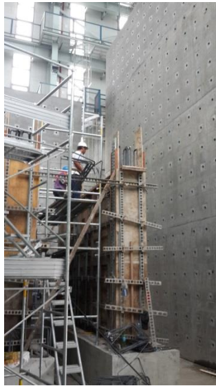
圖 3- 57 試體牆、柱封完模後，綁紮試體加載頂梁鋼筋
