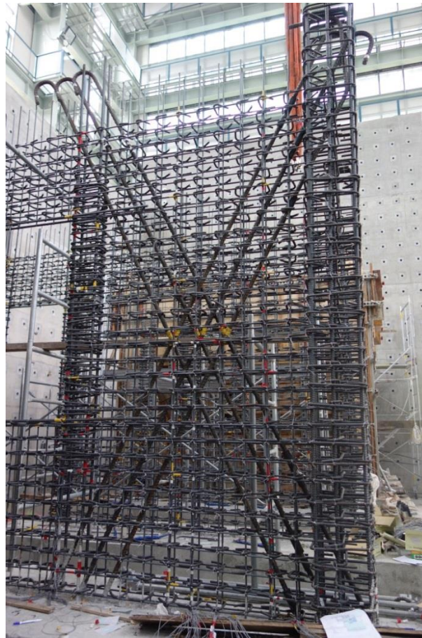
圖 3- 11 對角向壓力鋼筋
