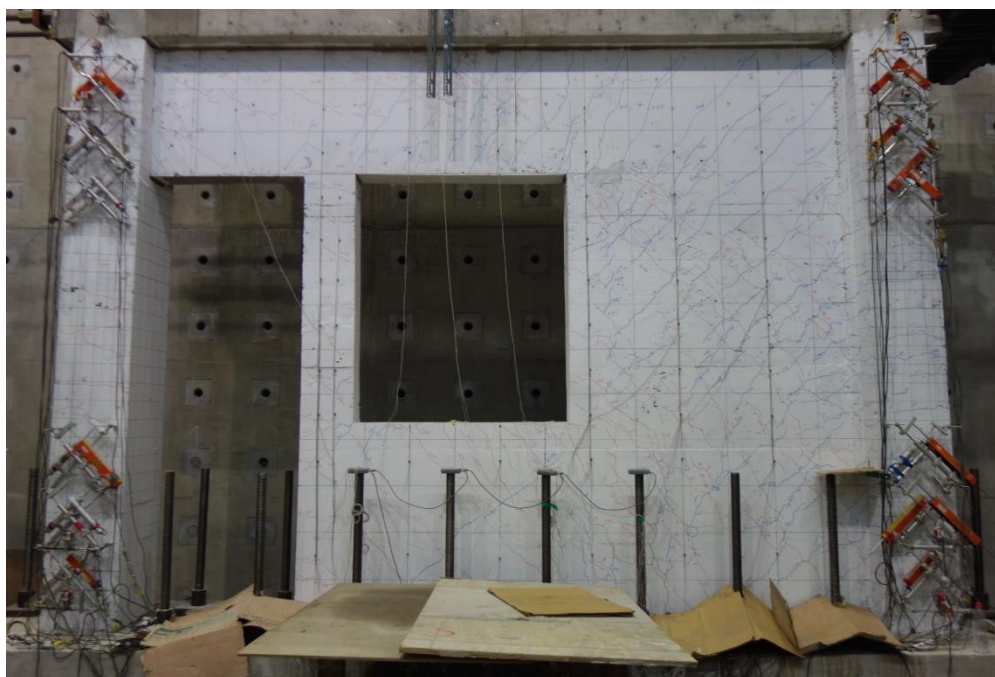
圖 4-77 試體二在+0.5% drift 下裂縫情況
