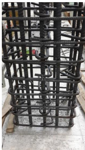
(d)柱鋼筋籠
