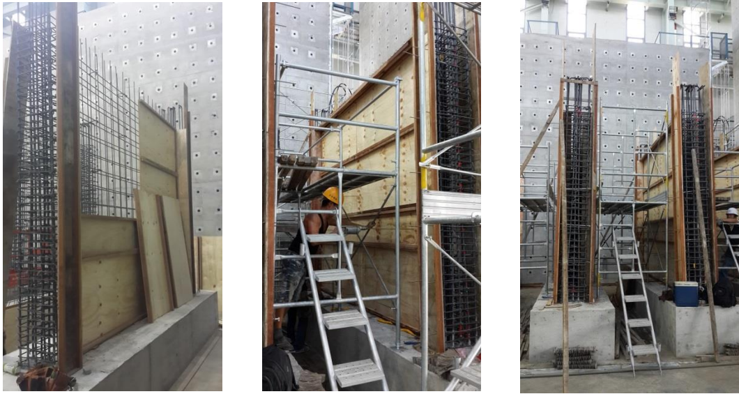
圖 3- 56 試體牆、柱封模
