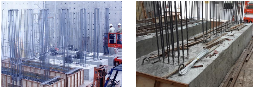
圖 3- 51 試體一至三基礎拆模
