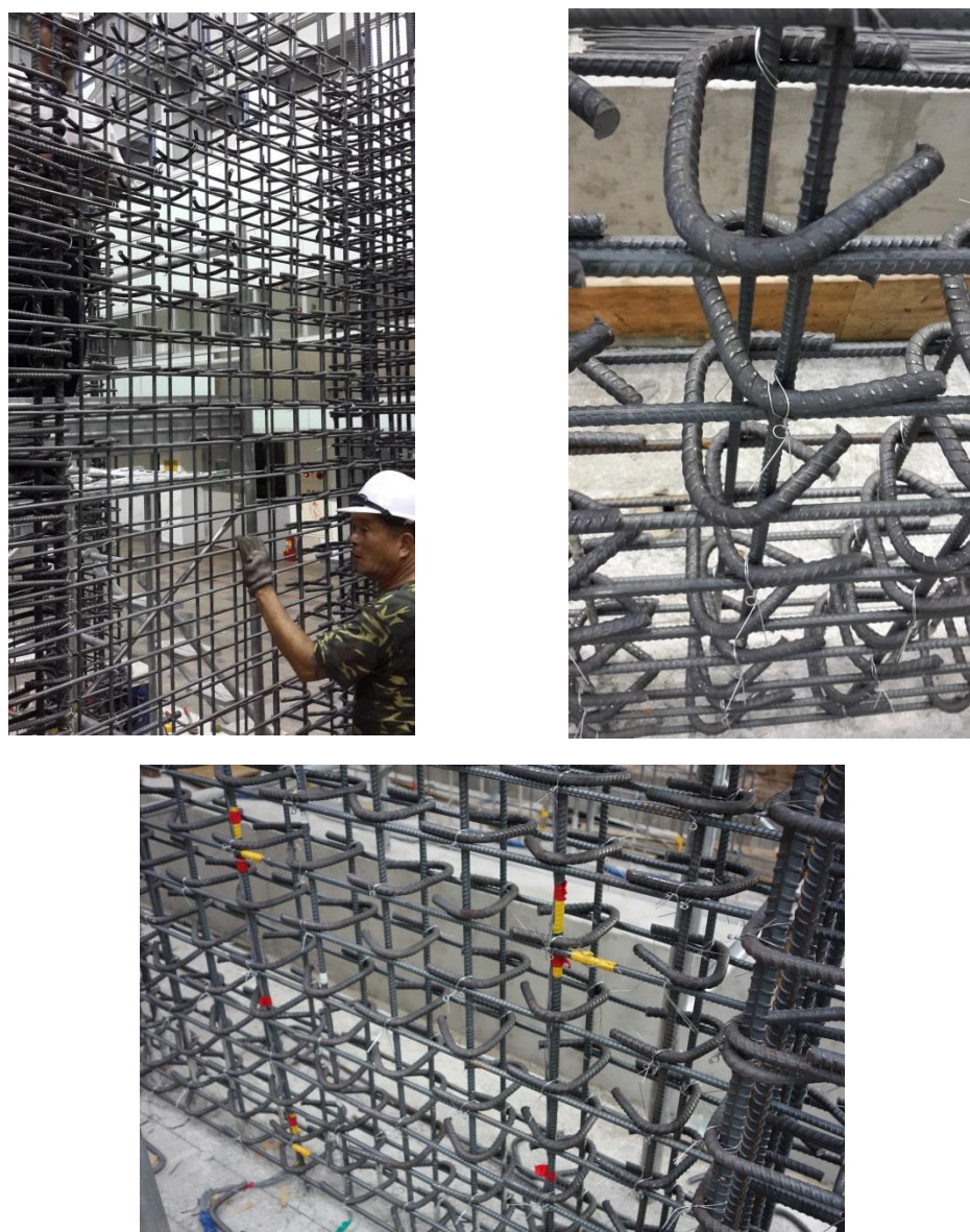
圖 3-9 密集配置鋼筋及每交點彎鈎繫筋
