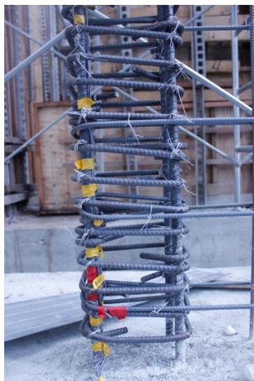
圖 3-26 邊界構材底部應變計黏貼並由底部順線接附接收器 資料來源:本研究拍攝
