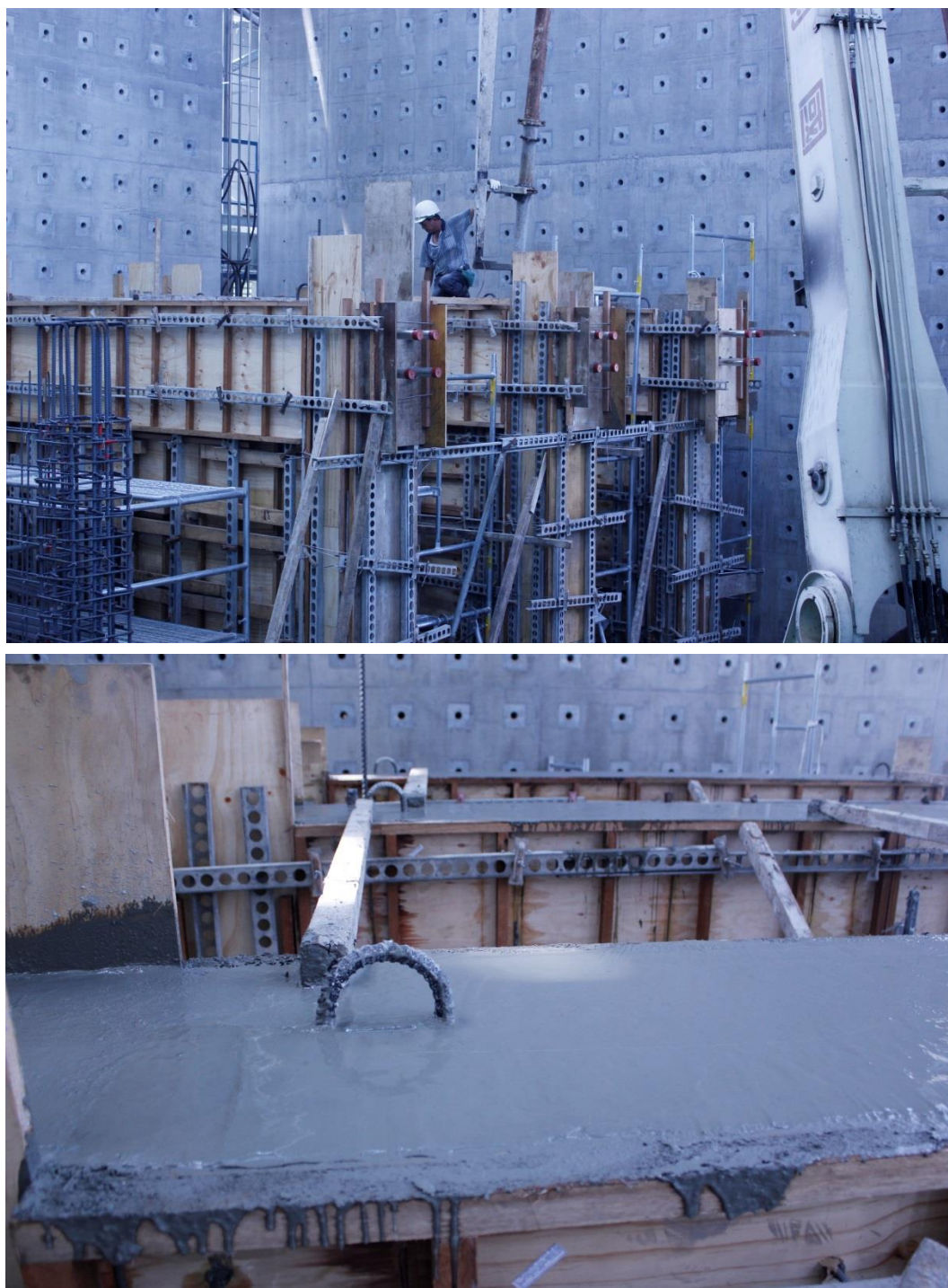
圖 3-58 試體澆置牆、柱及加載頂梁
