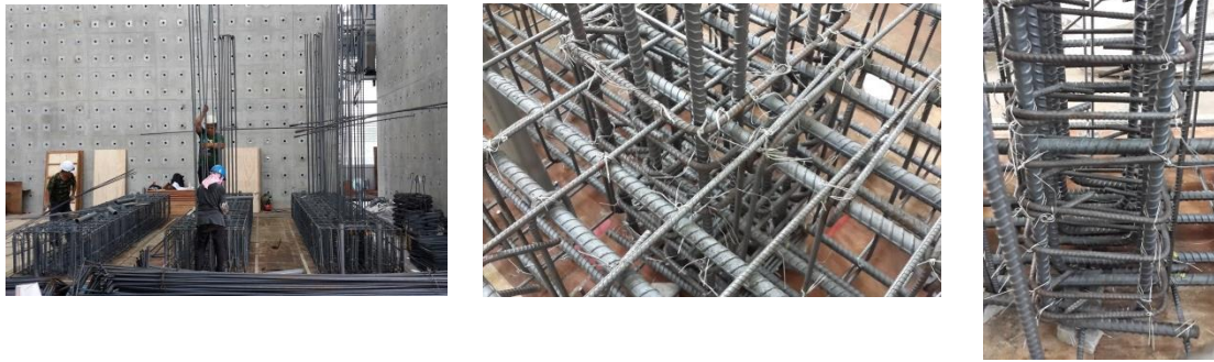
圖 3- 46 柱主筋及閉合箍筋埋入基礎
