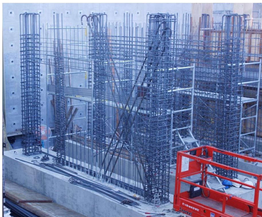
(g)對角向鋼筋組裝完成
