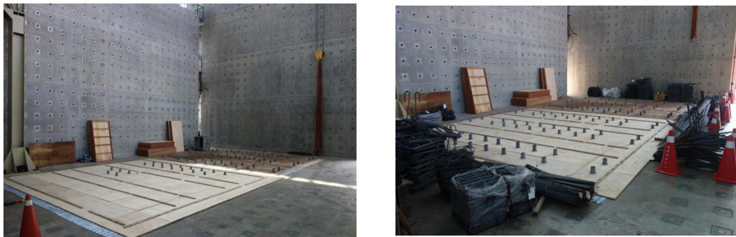
圖 3-44 試體放樣及鋼筋進場
