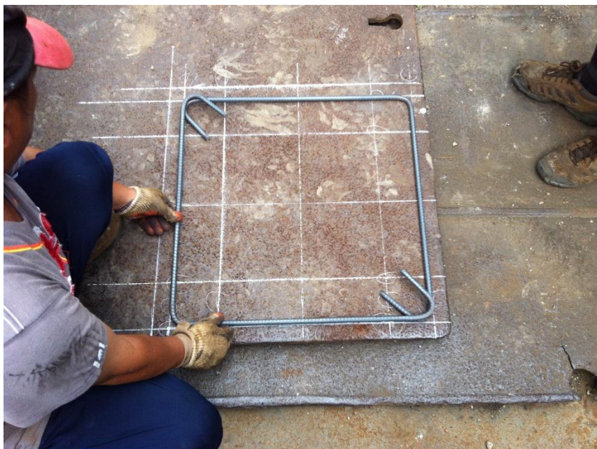
照片 3.2 雙 L 型箍筋於鋼筋加工廠放樣
