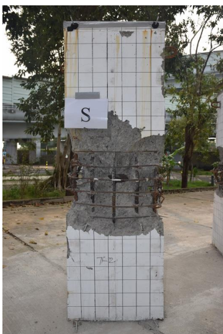
照片 4. 23 T1-2 試體破壞後-S 面
