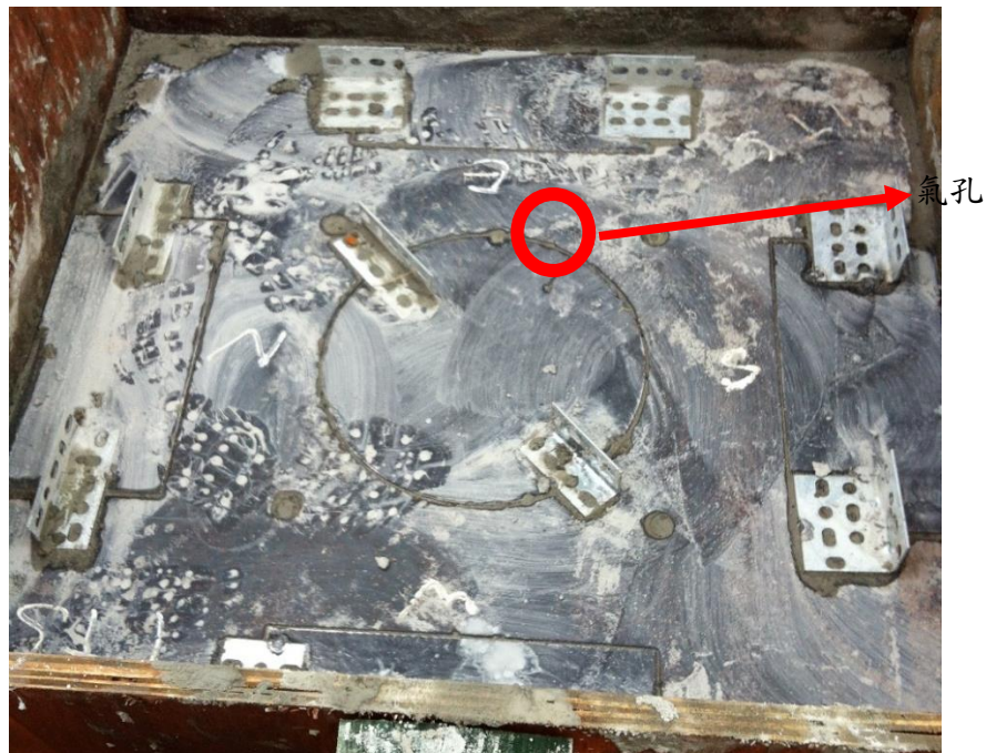
照片 3.6 填補無收縮水泥完成照
