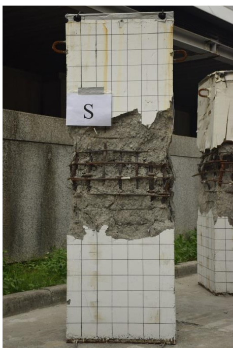
照片 4. 55 T5-2 試體破壞後-S 面
