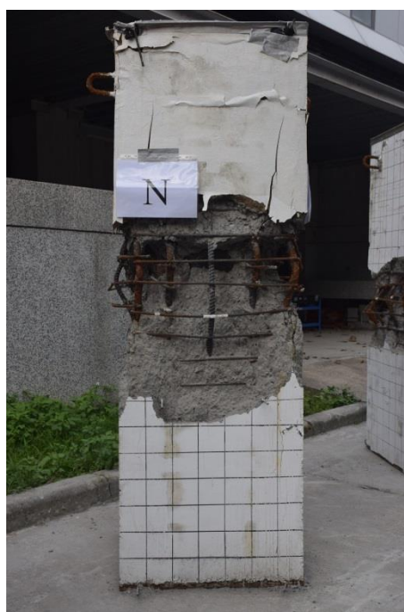
照片 4. 20 T1-1 試體破壞後-N 面
