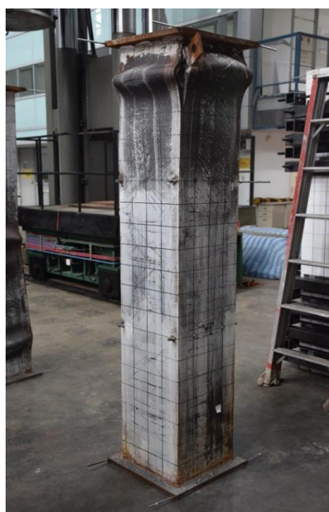
照片 4.6 CR-2 破壞後外觀之 2
