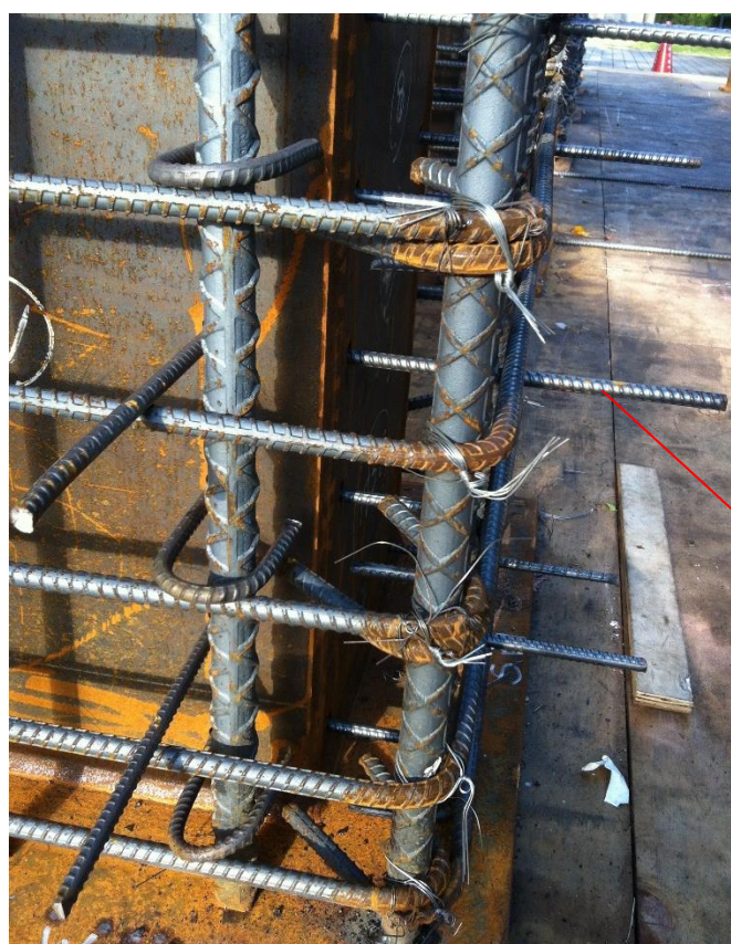
照片 C.4 T1 試體貫穿繫筋 135 度彎鉤採人工加工
