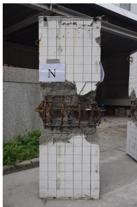
照片 4.48 T4-2 試體破壞後-N 面
