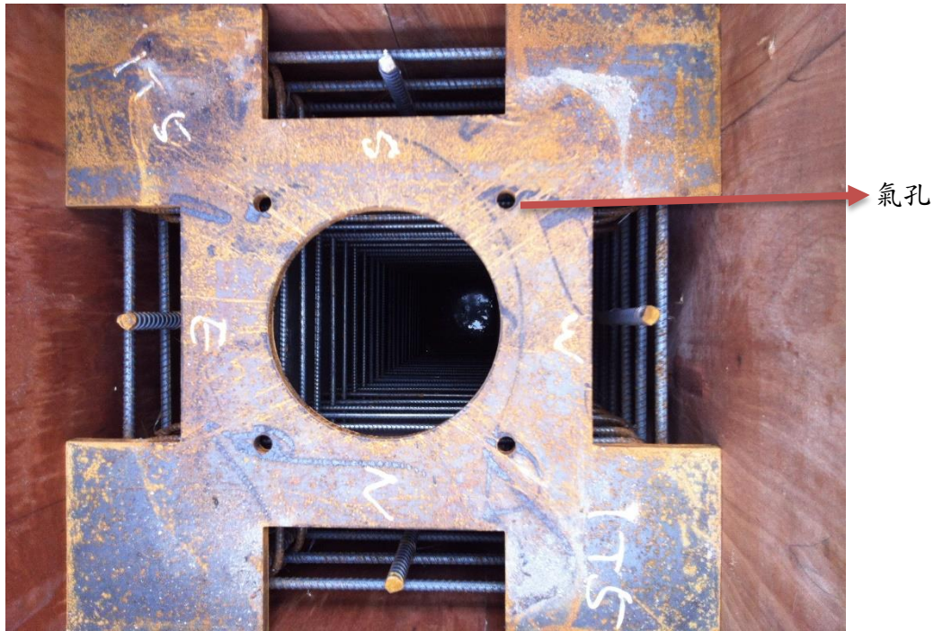
照片 3.1 箱型柱上端板完成近照
