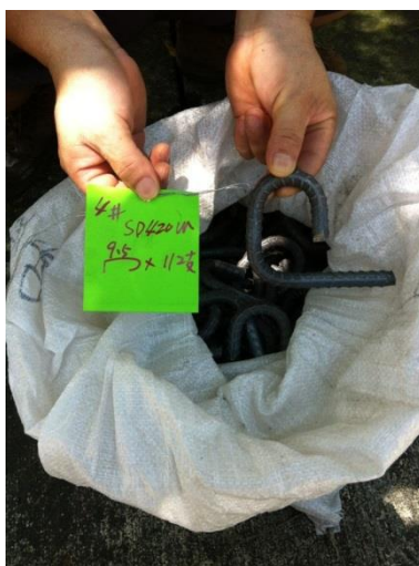
照片 4. 60 T3 短繫筋製作完成之形狀
