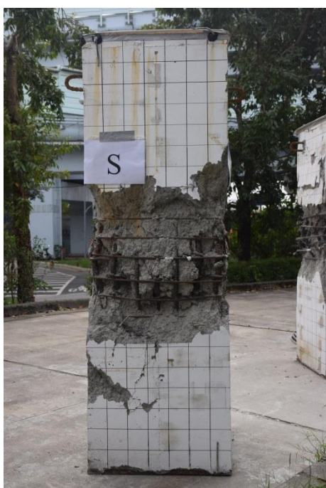
照片 4. 51 T5-1 試體破壞後-S 面
