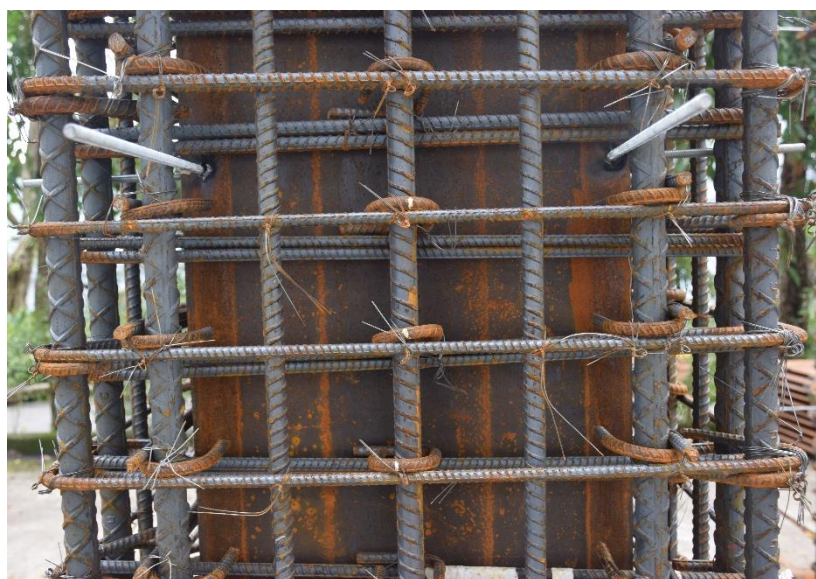
照片 3.5 T5 搭接式繫筋於現場施工完成照
