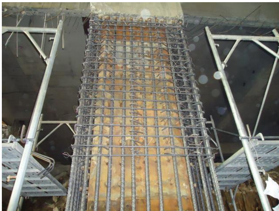
照片 1.1 北部建築工程逆打鋼柱採用包覆填充型箱型柱
