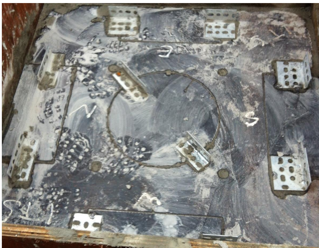
照片 C.12 試體上端板之切割鋼板填補完成照
