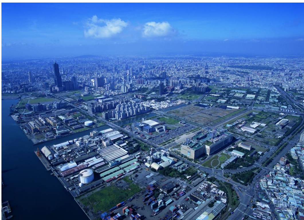
圖 3-13 高雄多功能經貿園區鳥瞰空照照片
