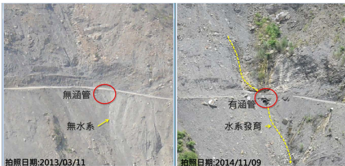
圖 4.58 坡面人工構造物改變導致水系變化實況照片
