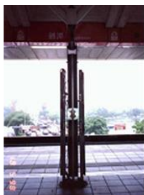
圖 1-10 捷運站黏彈性阻尼器
