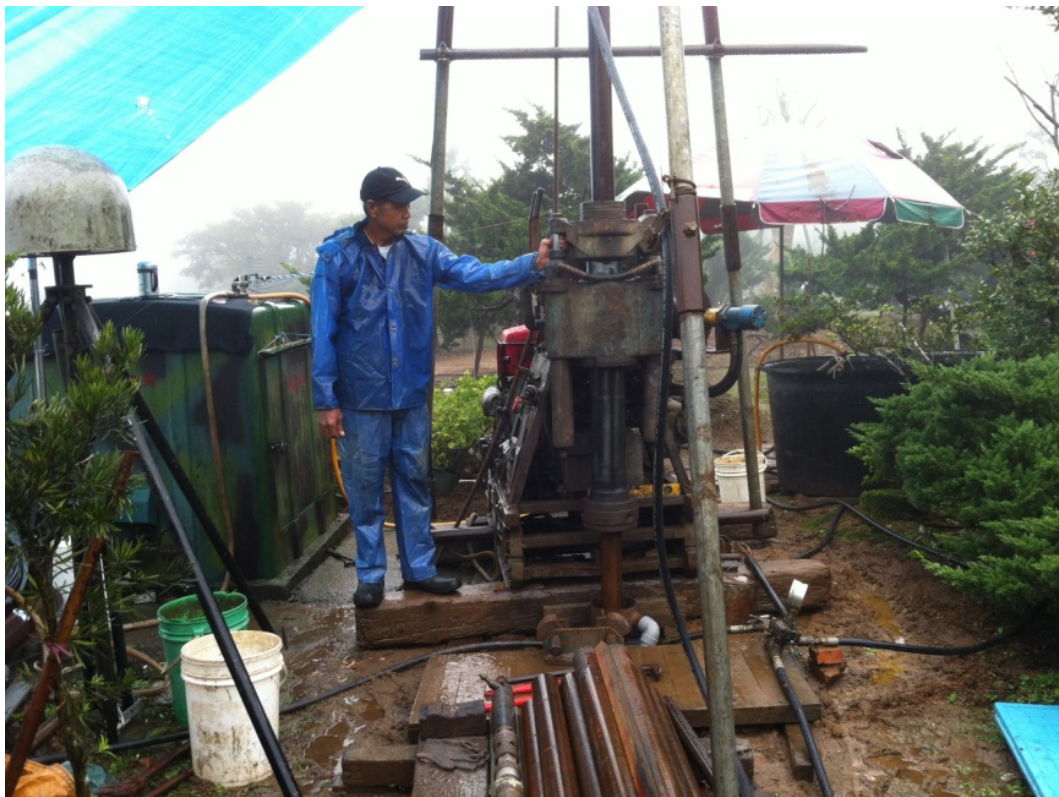
圖 27 淺井地震站現場施工情況。
