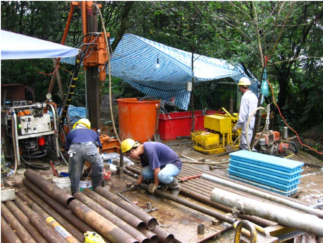
圖 25 深井地震站現場施工情況。
