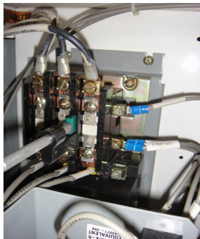
圖 2.5 櫃內設備物鎖固情況
