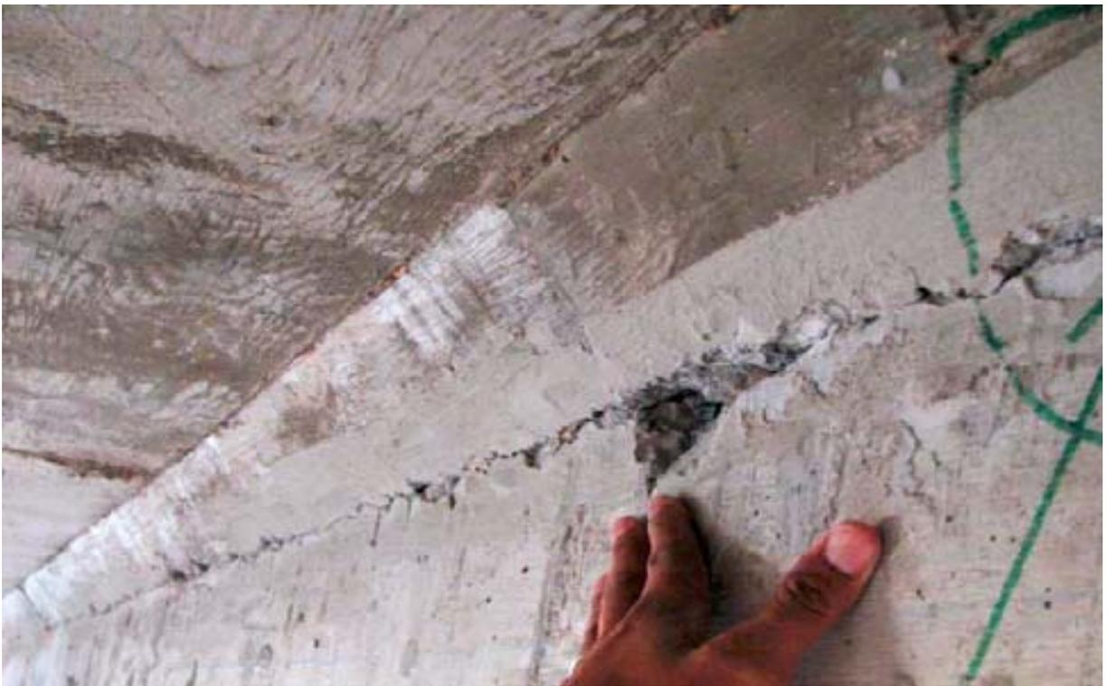
圖 2-4 橋樑施工縫損害實例[13]
