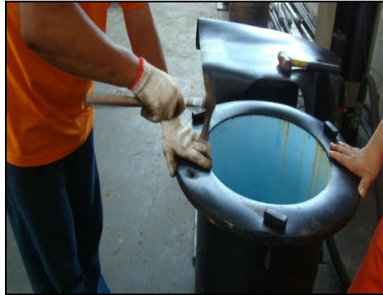
(b) 敲擊成橡膠墊圈
