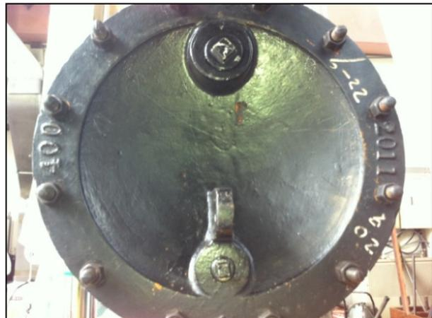
圖 2.12 A 型接頭延性螺壓式管塞
