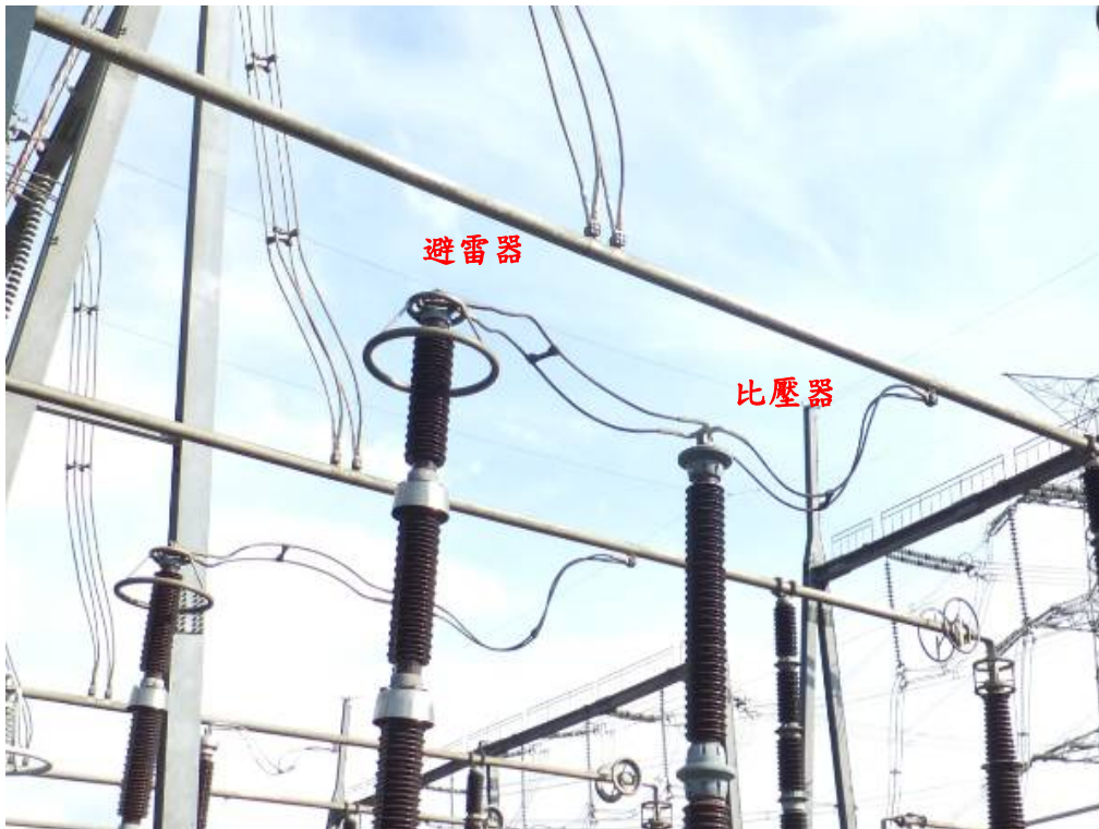
圖7.18 原配置：避雷器與比壓器相連
