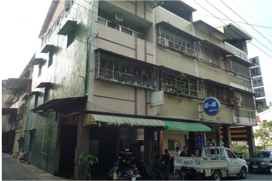
照片5.17 竹山連棟民宅2正面外觀實際情況
