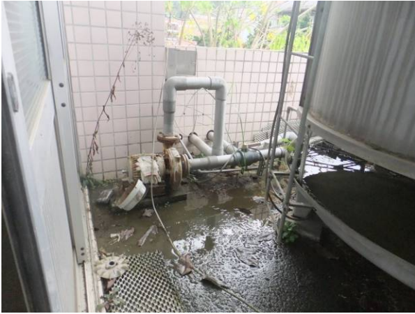
(c) 抽水馬達受損無法運作 圖7.39 水里國小體育館設備管線損壞情況
