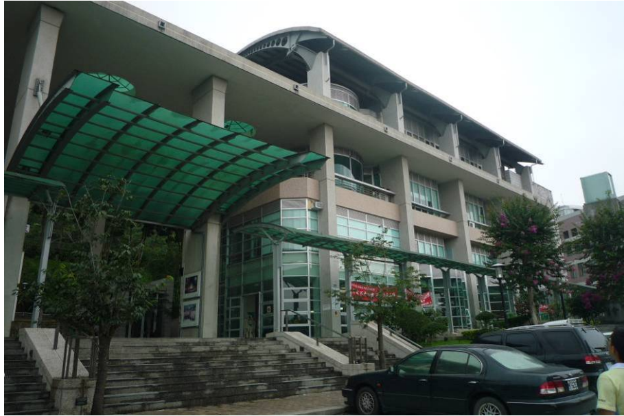
照片5.50 魚池鄉公所大樓正面外觀實際情況
