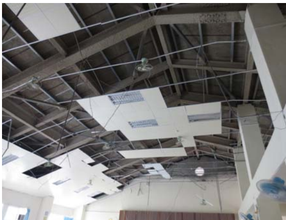
圖 6.67 輕鋼架天花板擠壓掉落
