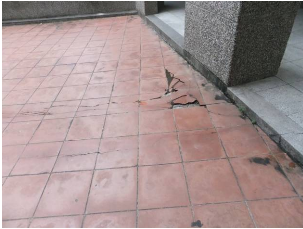
圖7.85 C棟與D棟間地面磁磚擠壓破裂
