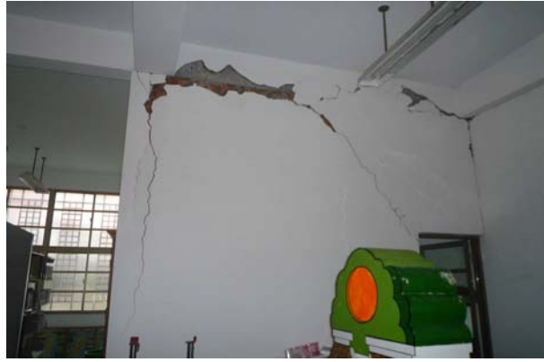
圖 6.31 圖書館右側的隔間磚牆產生明顯剪力裂縫及局部擠碎破壞
