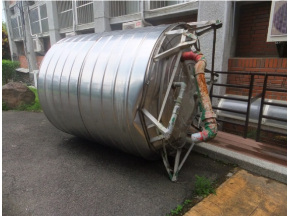
(a)教學大樓受損而拆卸的水塔
