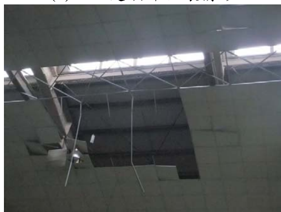
(d)鄰近館場中央天窗破壞照片 2
