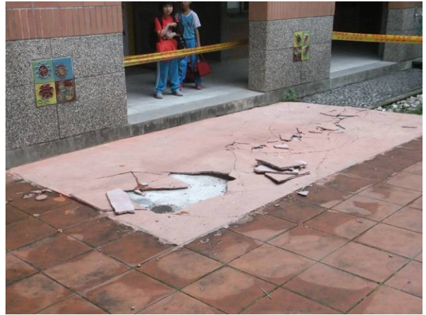
圖7.85 C棟與D棟間地面磁磚擠壓破裂
