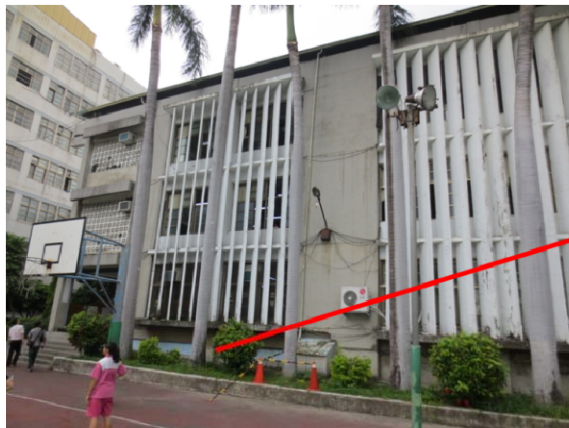
圖 6.73 志學樓背面側高窗短柱出現輕微剪力裂縫
