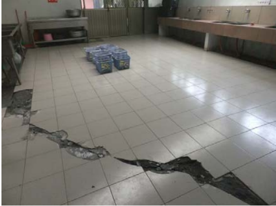
圖 6.45 廚房地板磁磚破裂
