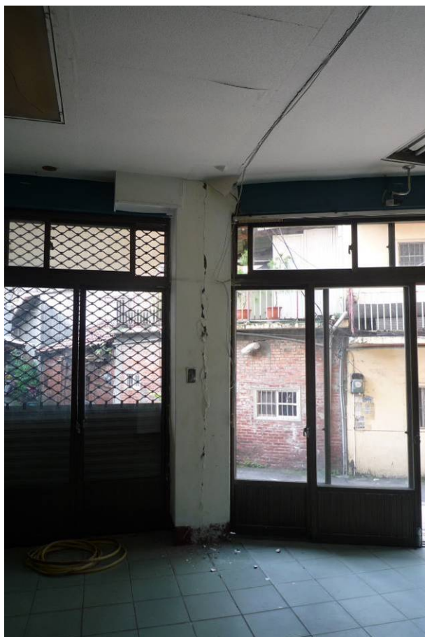
照片5.26 竹山民宅1產生明顯的兩柱界面裂縫（兩棟相鄰的牆面已拆除）
