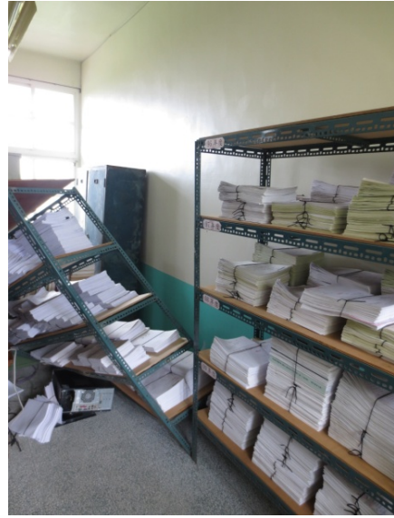
圖 6.77 鐵架櫥櫃傾倒、文件散落
