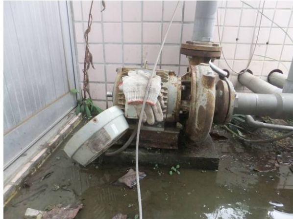
(c) 抽水馬達受損無法運作 圖7.39 水里國小體育館設備管線損壞情況
