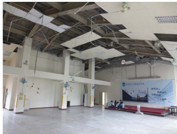
圖 6.67 輕鋼架天花板擠壓掉落
