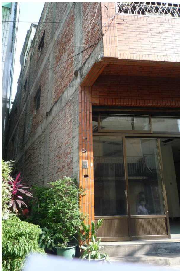
照片5.24 竹山民宅1正面及側面外觀實際情況
