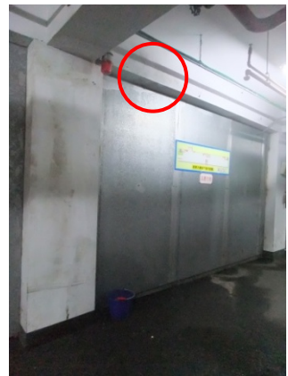
圖 6.52 教學大樓地下室消防水管破損(紅圈為滲水處)
