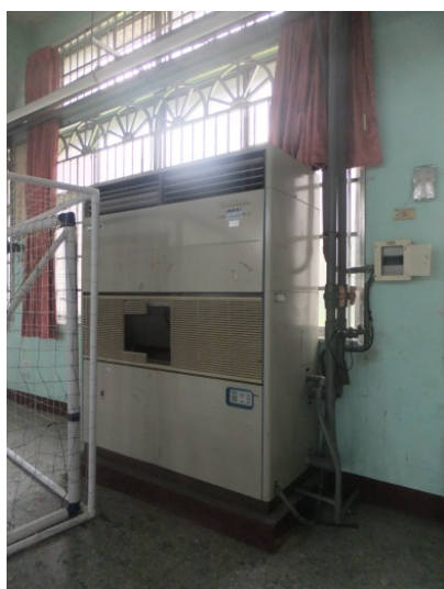
(a) 水冷式空調系統
