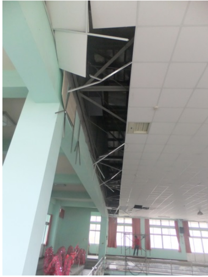
圖 6.34 體育館兩側輕鋼架天花板損壞情況
