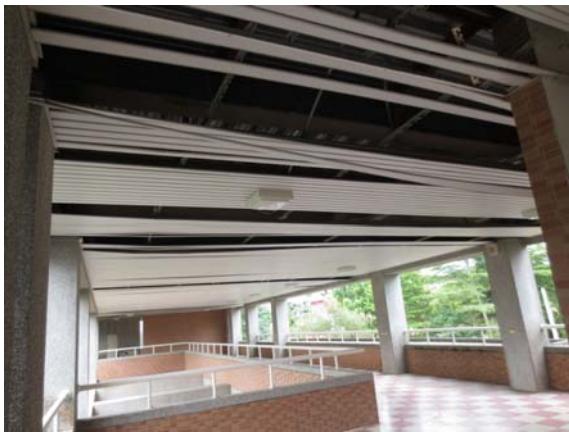
圖 6.66 輕鋼架天花板掉落、出現雨水滲漏現象
