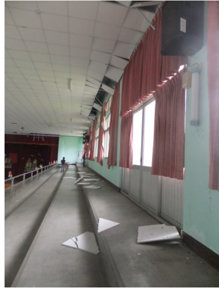
圖 6.34 體育館兩側輕鋼架天花板損壞情況
