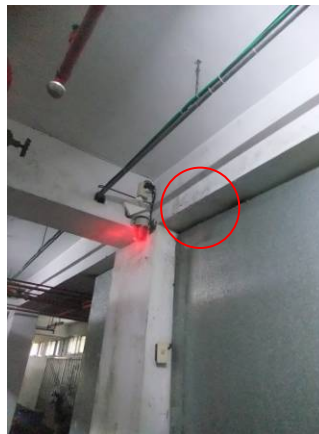
圖7.61 教學大樓地下室消防水管破損(紅圈為滲水處)
