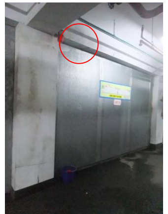
圖7.61 教學大樓地下室消防水管破損(紅圈為滲水處)
