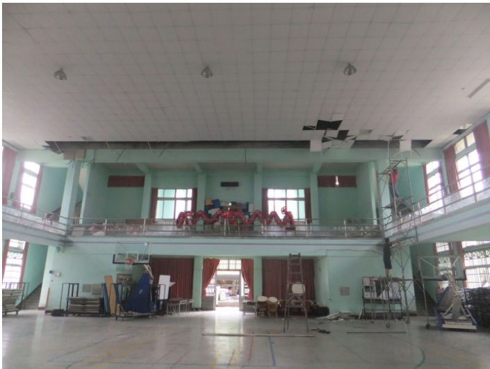
(a) 體育館入口(東側)上方
