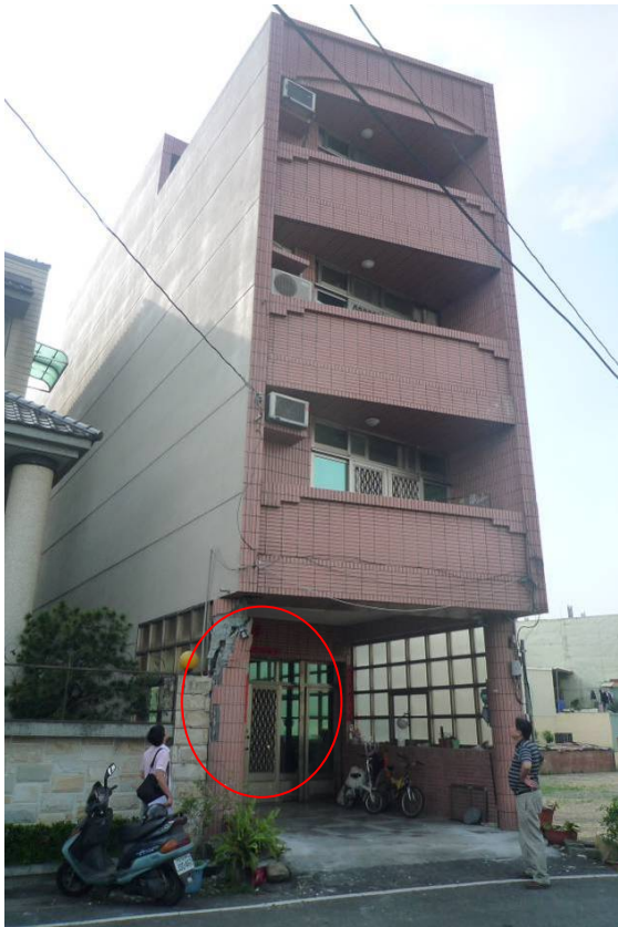
照片 5.27 竹山民宅 2 正面外觀實際情況
