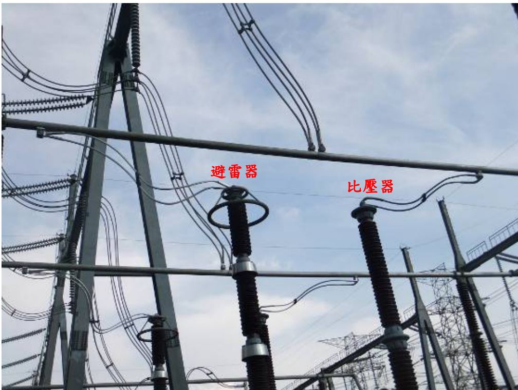
圖7.19 改良後配置：避雷器與比壓器分離
