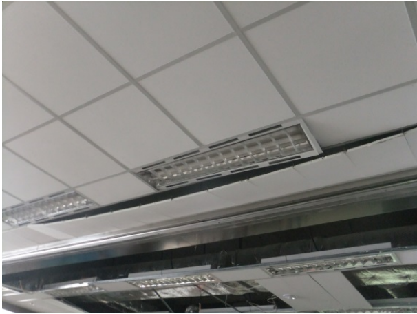
(a) 明架式天花板系統無損 (照片左上角處)
