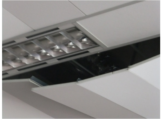
(b) 半明架式天花板材與骨架移位 (照片下半部處)
