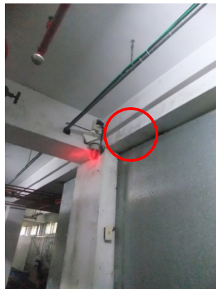
圖 6.52 教學大樓地下室消防水管破損(紅圈為滲水處)
