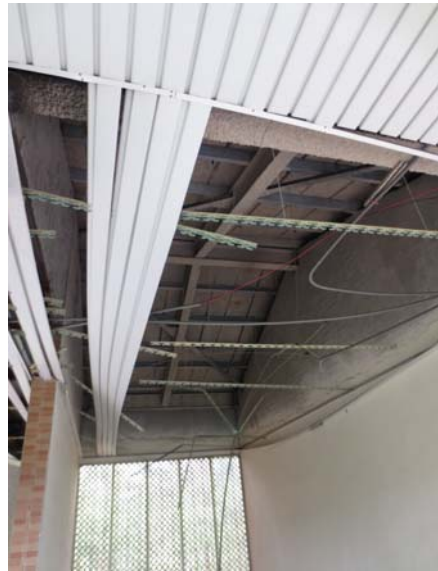
圖 6.66 輕鋼架天花板掉落、出現雨水滲漏現象
