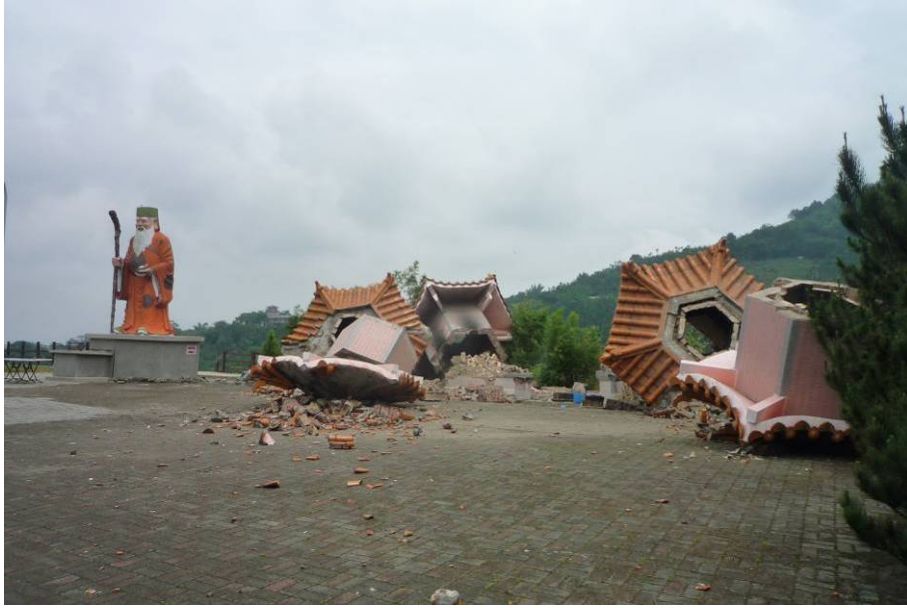
照片5.46 三座金亭倒塌破壞、土地公神像傾斜
