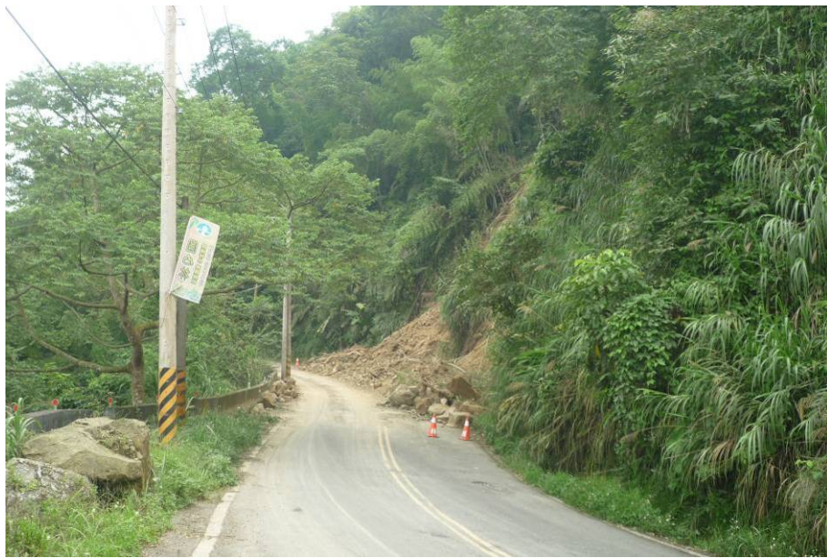
照片5.33 投49縣12K處的山崩地點（地震發生後的隔天已搶通）
