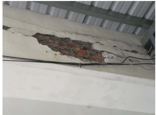
圖 6.44 廚房屋頂磚砌女兒牆外粉刷層剝落、水平裂縫
