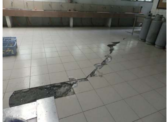
圖 6.45 廚房地板磁磚破裂
