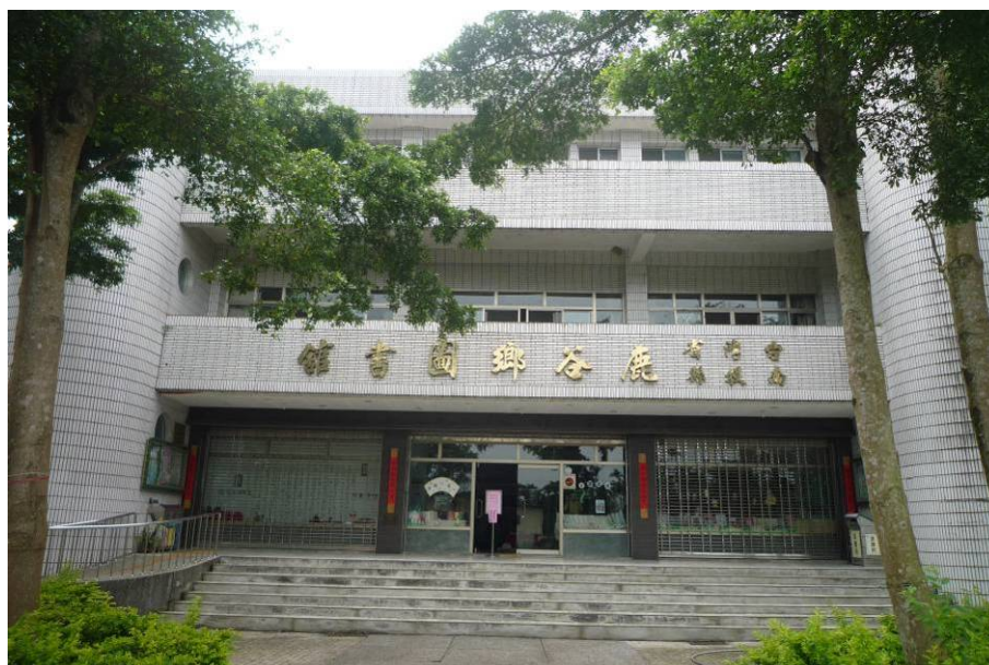
照片5.34 鹿谷鄉立圖書館正面外觀實際情況
