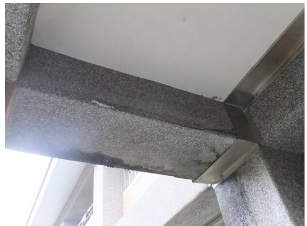
圖7.83 B棟與專科教室二樓隔離縫附近梁底鋪面材破損
