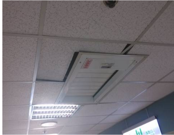
圖7.13 新醫療大樓五樓天花板與排煙閘門相接處天花板構架些微變形
