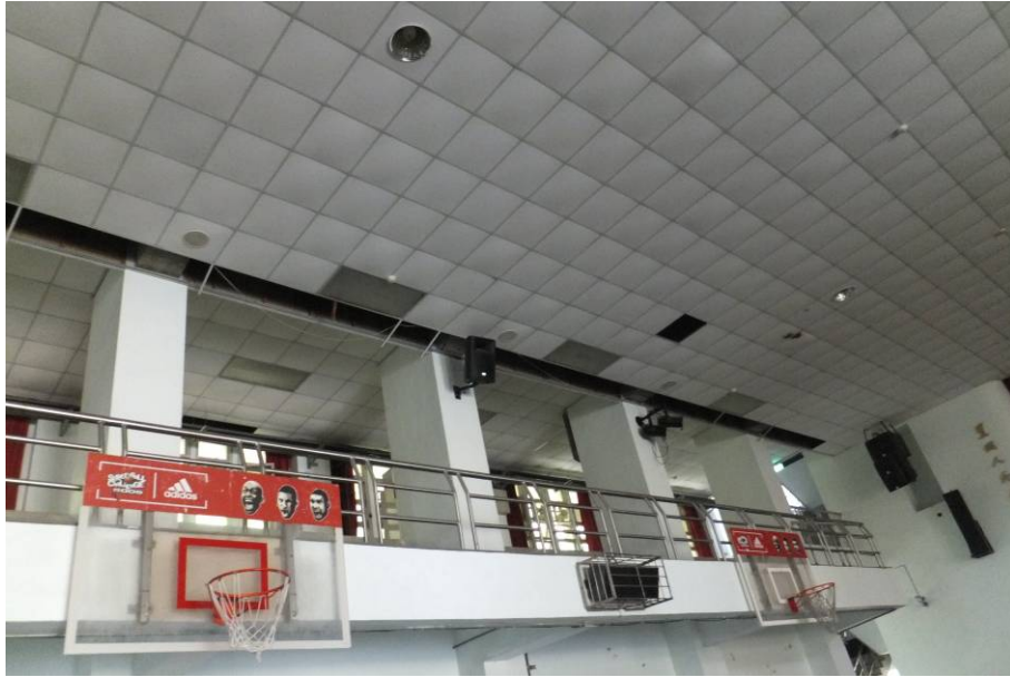
(a) 破壞照片 1
