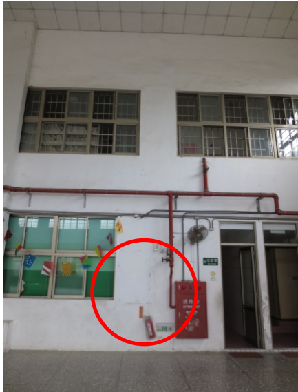
圖 6.79 扯鈴館柱體與牆體交界位置出現裂縫
