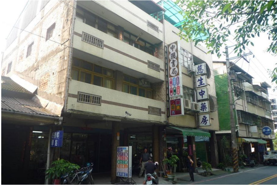
照片5.20 竹山連棟民宅3正面外觀實際情況
