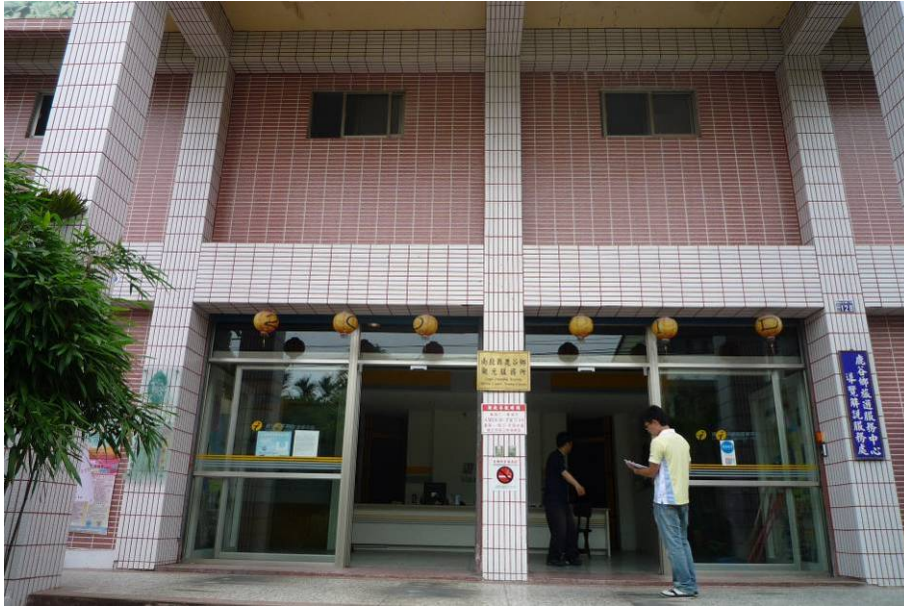
照片5.41 鹿谷鄉觀光服務所正面外觀實際情況
