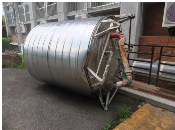
(a) 教學大樓受損而拆卸的水塔
