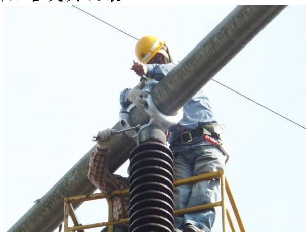
圖7.16 高空匯流排鋁管夾具破壞
