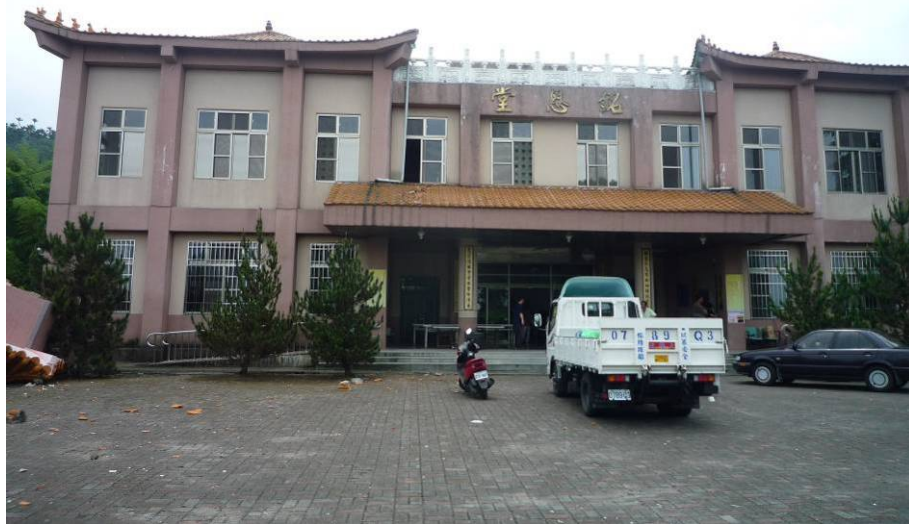
照片5.43 鹿谷鄉銘恩堂(靈骨塔) 正面外觀實際情況
