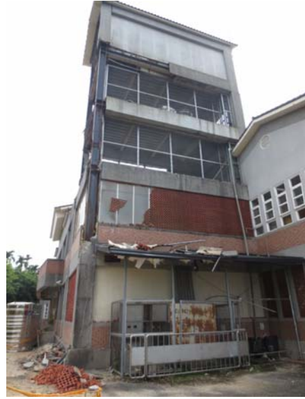
圖 6.65 梁柱包覆材、花格磚受震後掉落
