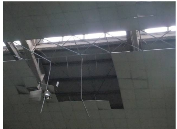
(d) 鄰近館場中央天窗破壞照片 2
