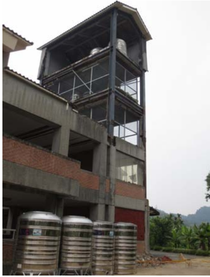
圖 6.65 梁柱包覆材、花格磚受震後掉落
