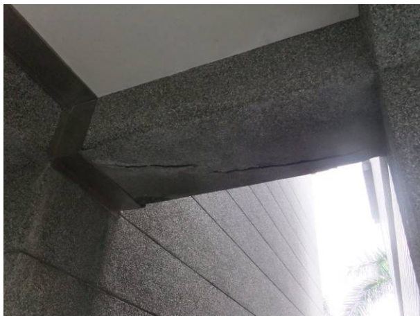
圖7.83 B棟與專科教室二樓隔離縫附近梁底鋪面材破損
