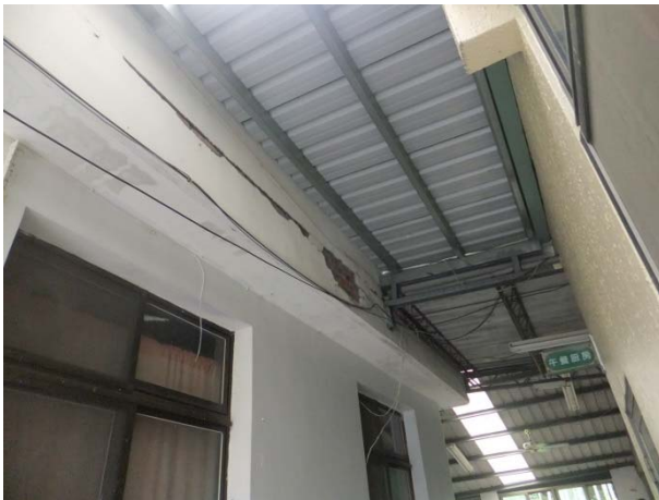
圖 6.44 廚房屋頂磚砌女兒牆外粉刷層剝落、水平裂縫
