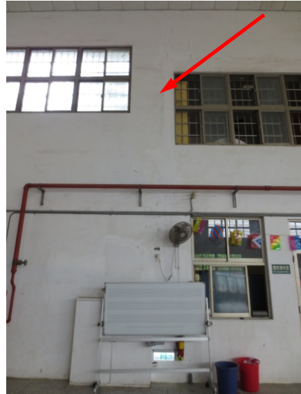
圖 6.79 扯鈴館柱體與牆體交界位置出現裂縫
