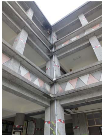
圖 6.19 鄰棟碰撞造成水管破裂漏水
