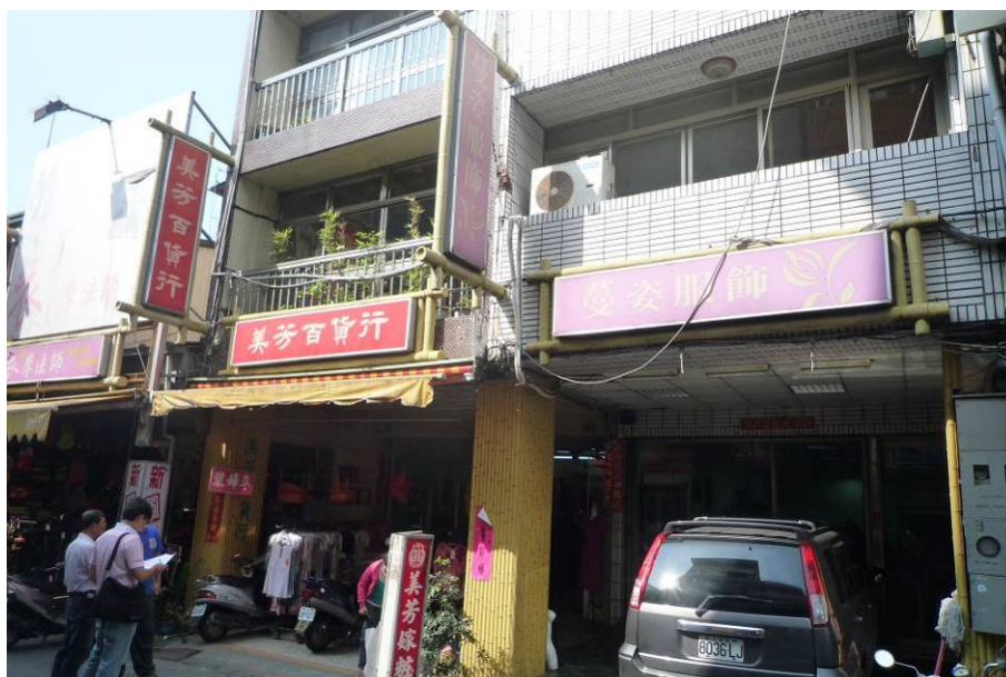
照片 5.15 竹山連棟民宅正面外觀實際情況
