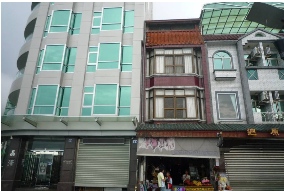
照片 5.54 日月潭邊住商樓正面外觀實際情況
