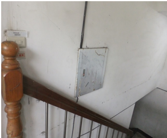
圖 6.53 教學大樓樓梯間牆體水平裂縫與樓梯間位置(紅圈標示處)
