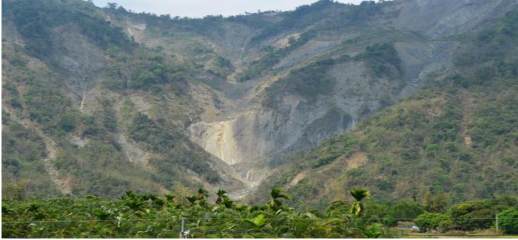
圖 21 小林國小附近山坡（崩塌地）
