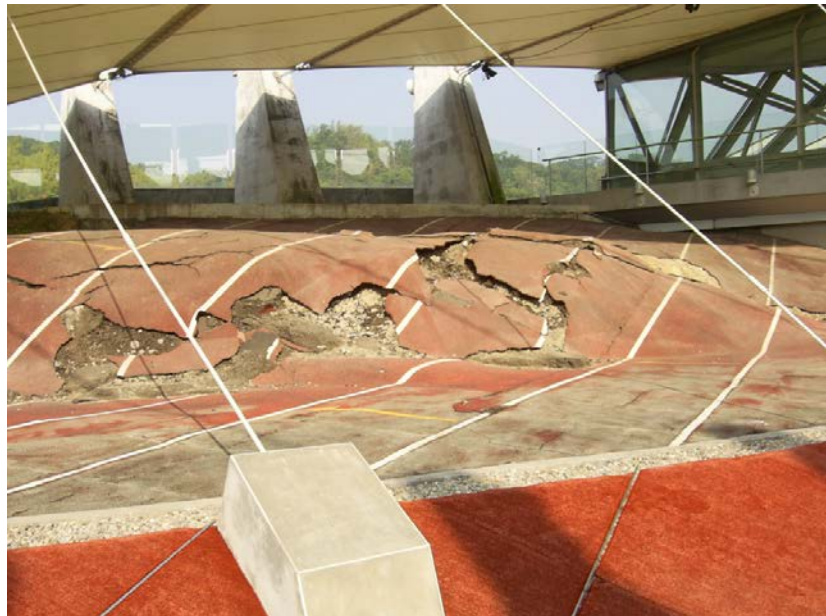
圖 2.10 921 大地震造成地表斷層上下錯動
