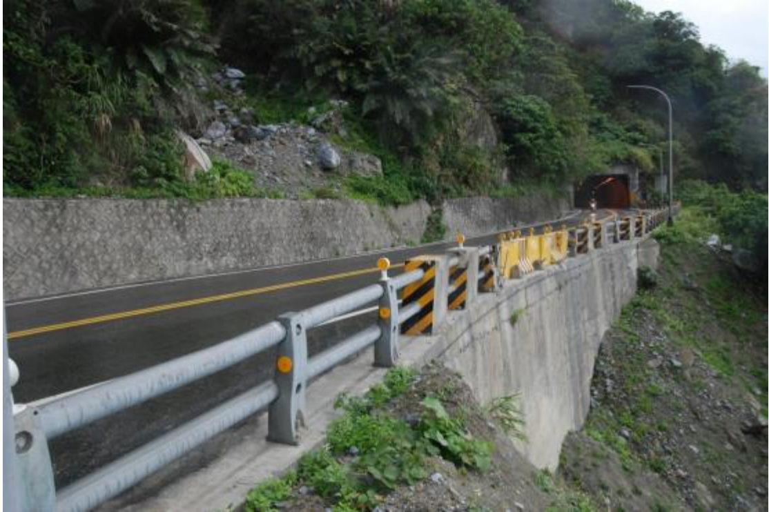
圖 3. 仁清隧道南端出口狀況照片
