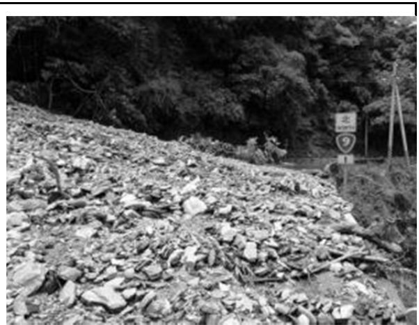
照片 14. 蘇花公路 145K+000 於 0512 豪雨事件間道路阻斷情形
