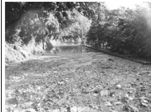
照片 21. 蘇花公路 150K+050 於 0512 豪雨事件零星坍方影響車道
