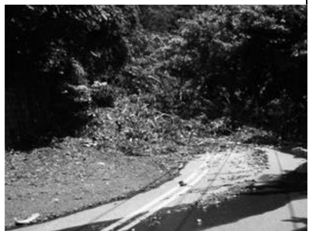
照片 16. 蘇花公路 145K+840 於 0512 豪雨事件道路阻斷情形
