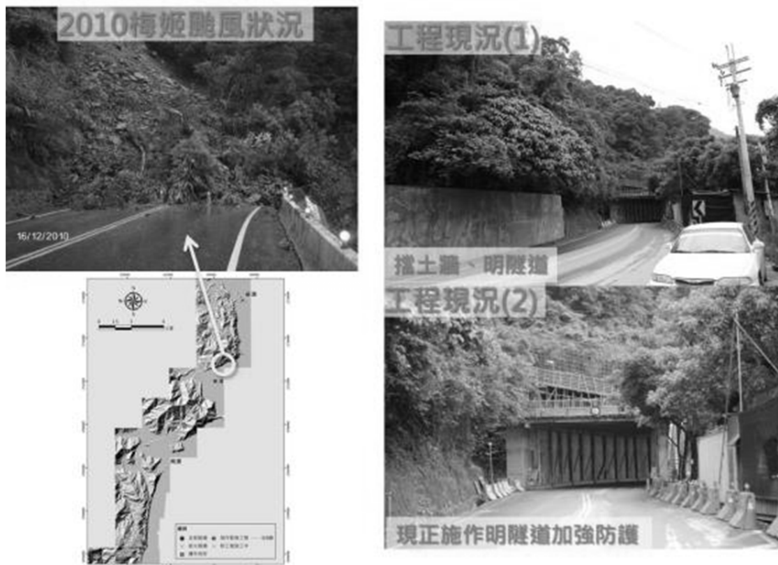
圖 4.29 蘇花公路樁號 116K+800 岩屑崩滑災害狀況與復建工程現況圖
