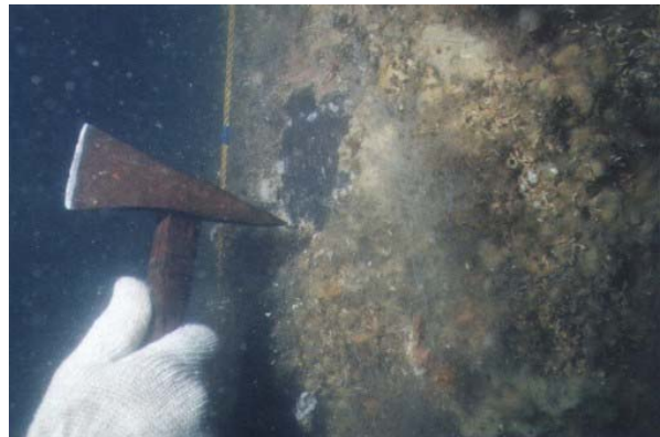
圖 3.7 清理鋼版樁表面附著海生物
