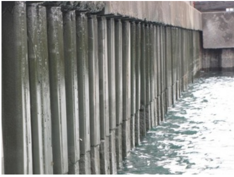
圖 3.4 典型鋼板樁碼頭構造情形
