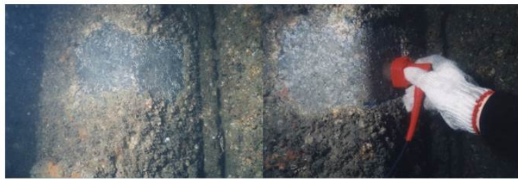
水下進行鋼板樁厚度檢測
