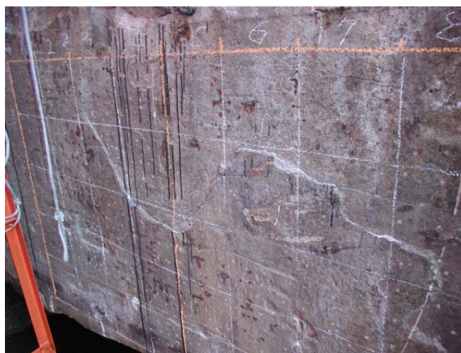
圖 4.1 碼頭岸壁面繪製方格
