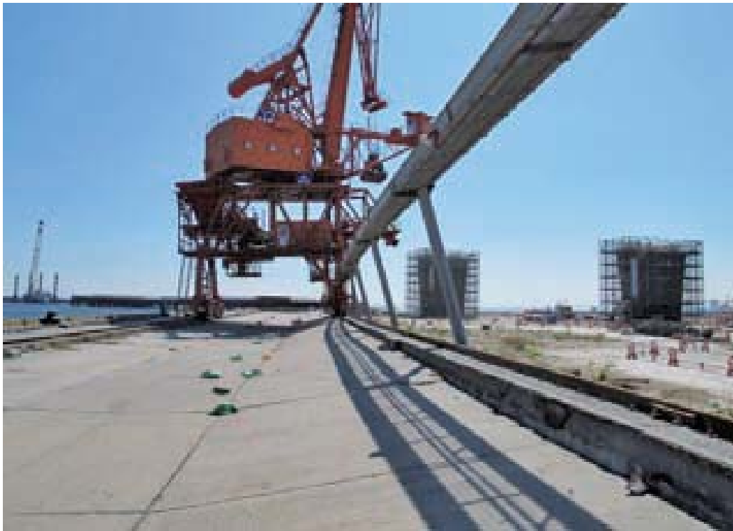
圖 1.2 東日本大地震(陸海側軌道間岸間下陷)
