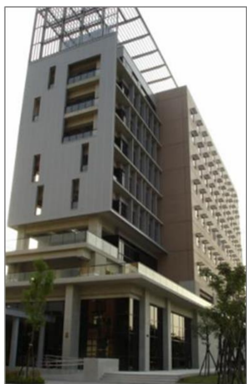
台大土木系研究大樓
