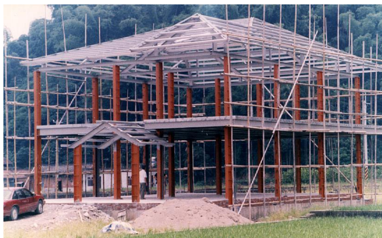
圖 3 低層鋼構建築構造 (圖片來源：戴松鄉)
