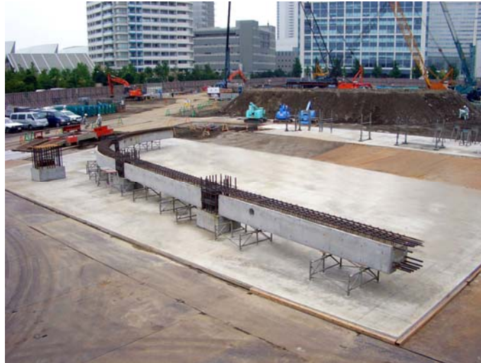
圖 6.4.4 現場預鑄橢圓形外圍梁
