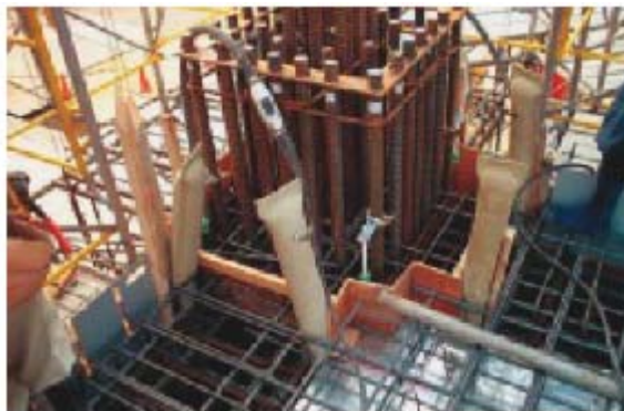
圖 6.2.3 混凝土澆置中止處理例
