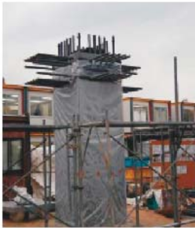
(a) 柱構材之養護例
