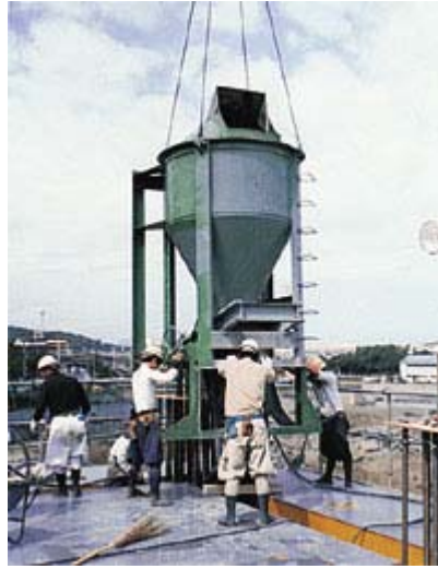
圖 6.2.2 以吊桶澆置柱構材
