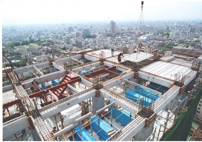
圖 6.4.1 外殼半預鑄柱安裝狀況
