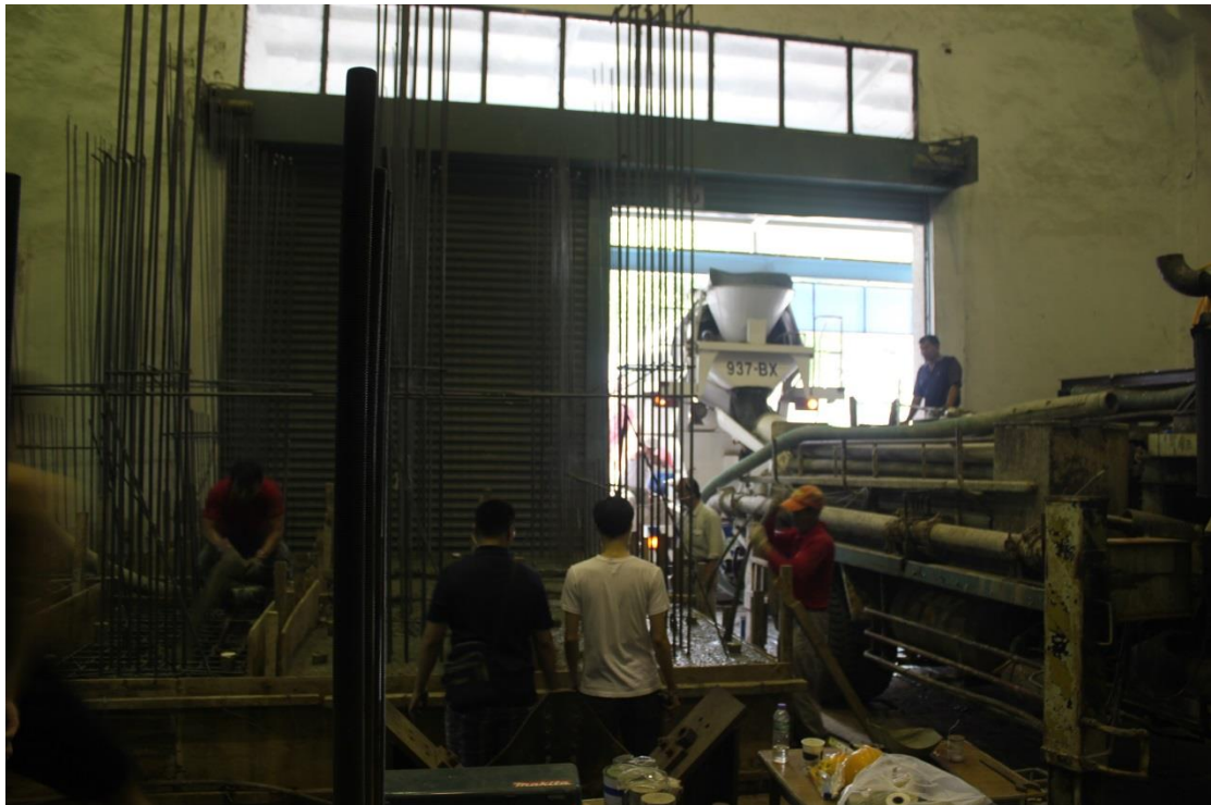
圖 B.20 進行灌漿作業震動搗實
