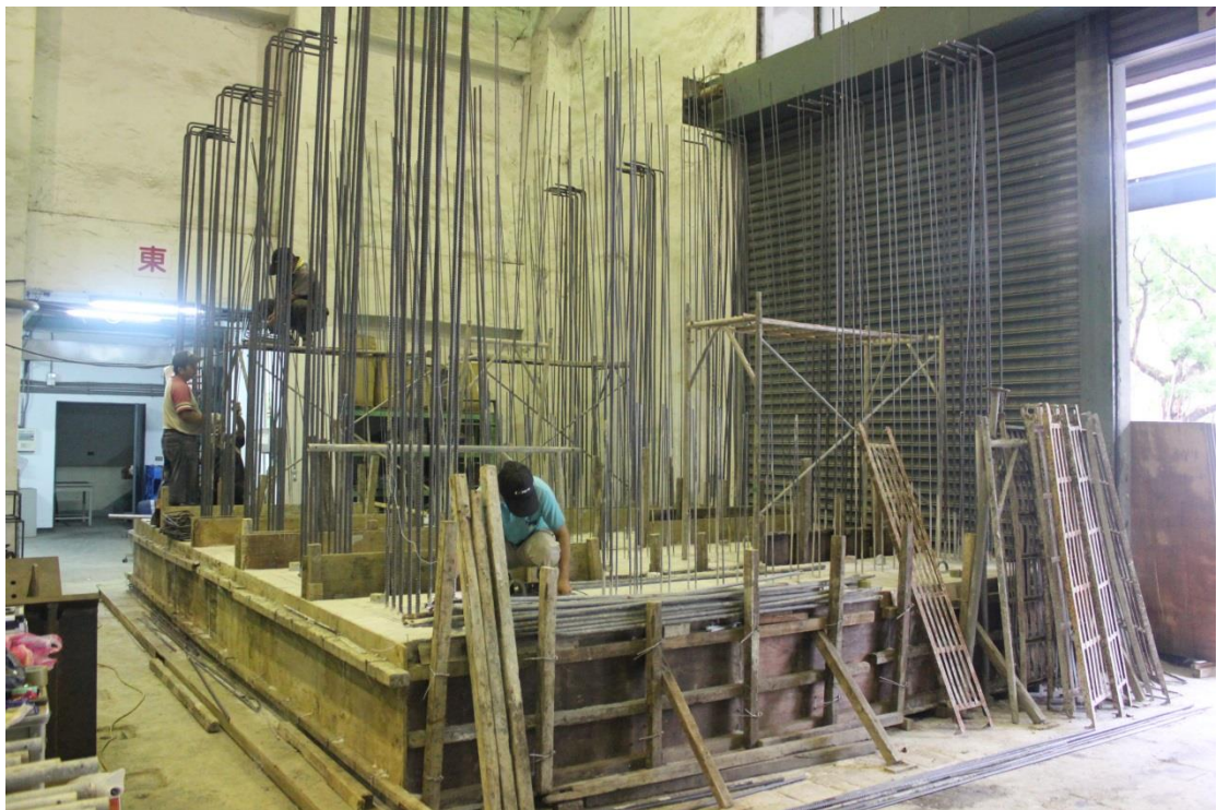
圖 B. 28 後續施工用鷹架搭設
