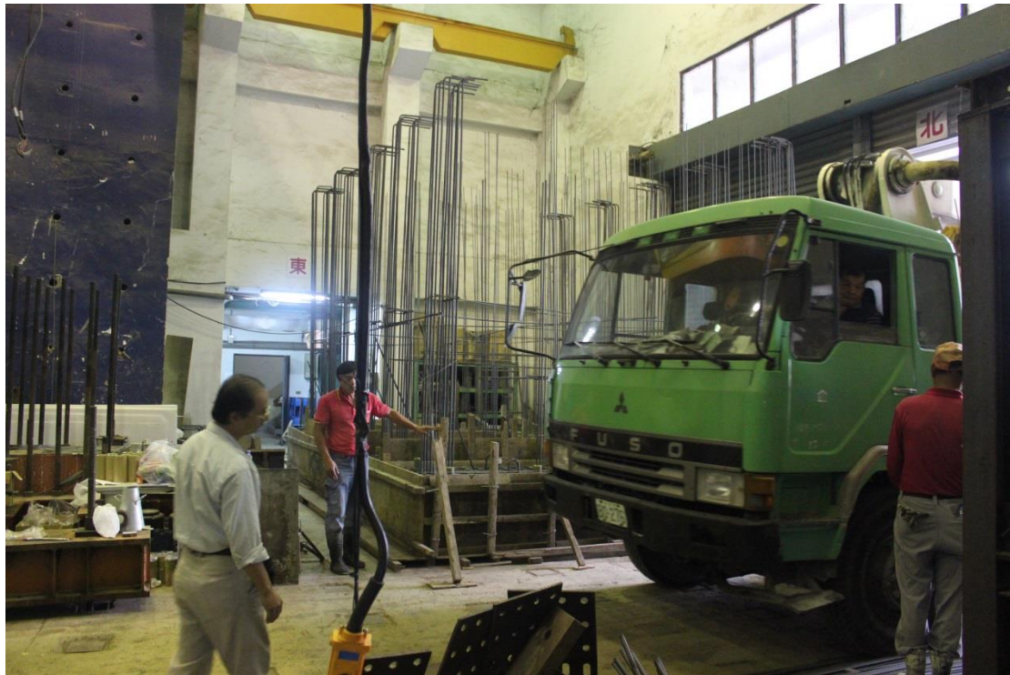
圖 B. 17 灌漿前泵送車進場準備
