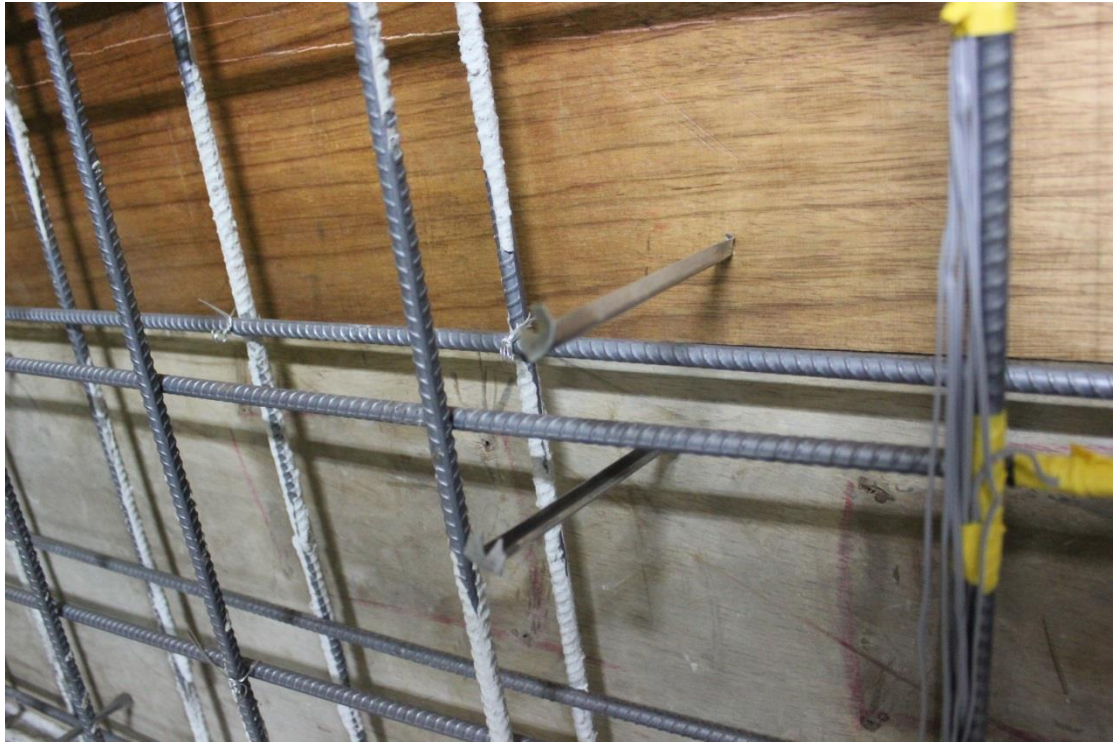
圖 B. 41 固定牆厚用鐵件
