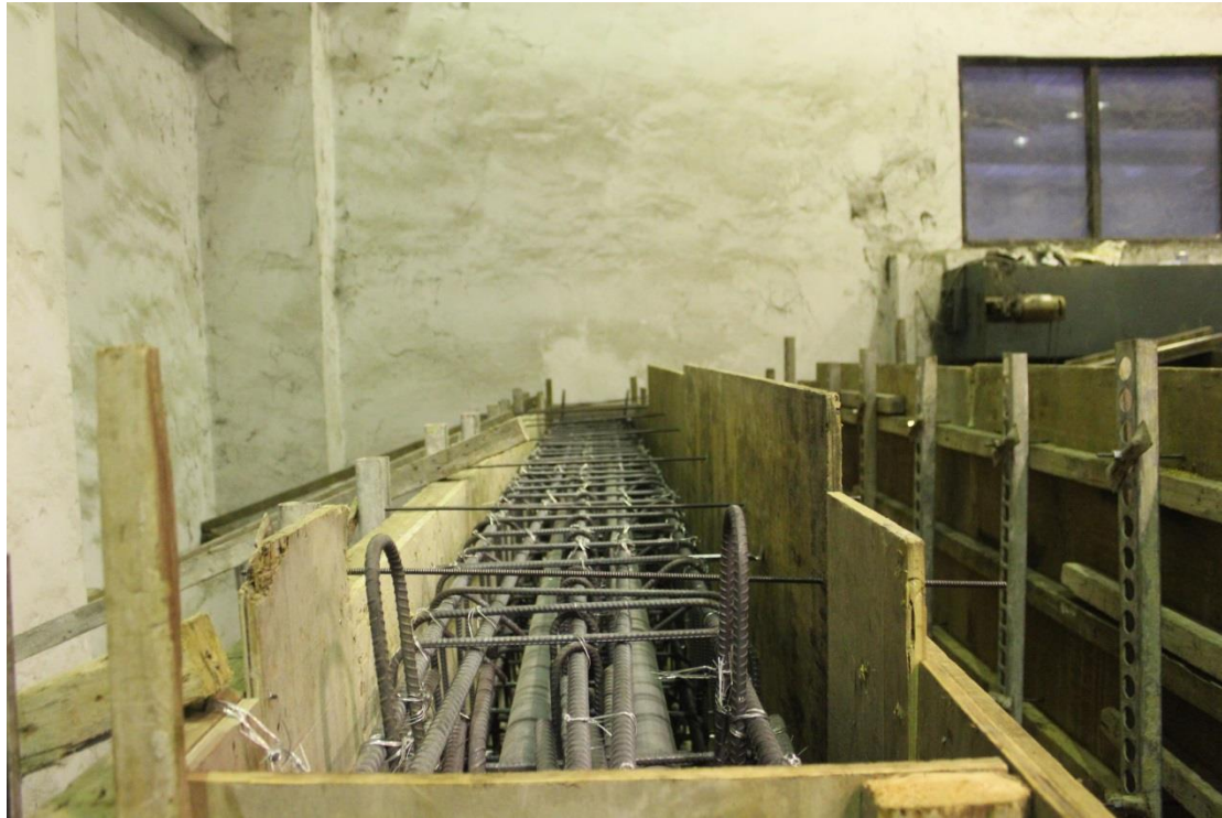
圖 B. 45 梁頂吊鈎預留
