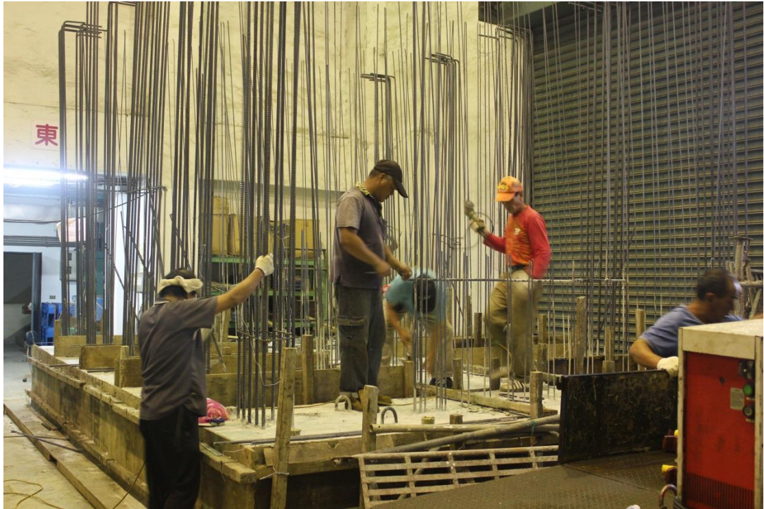
圖 B. 27 牆、柱工作輔助筋去除
