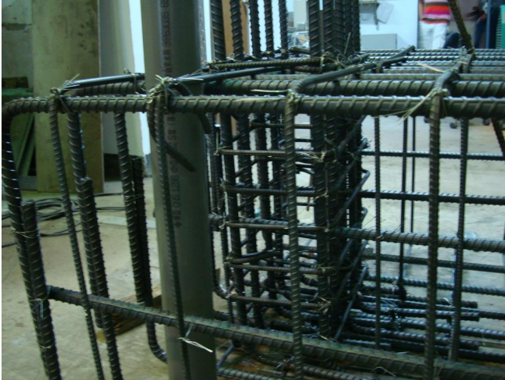
圖 B.3 柱箍筋延伸配置進基礎內
