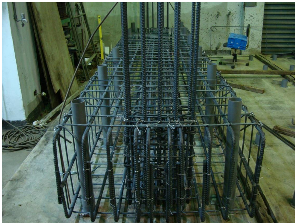
圖 B.2 基礎鋼筋及柱主筋組立
