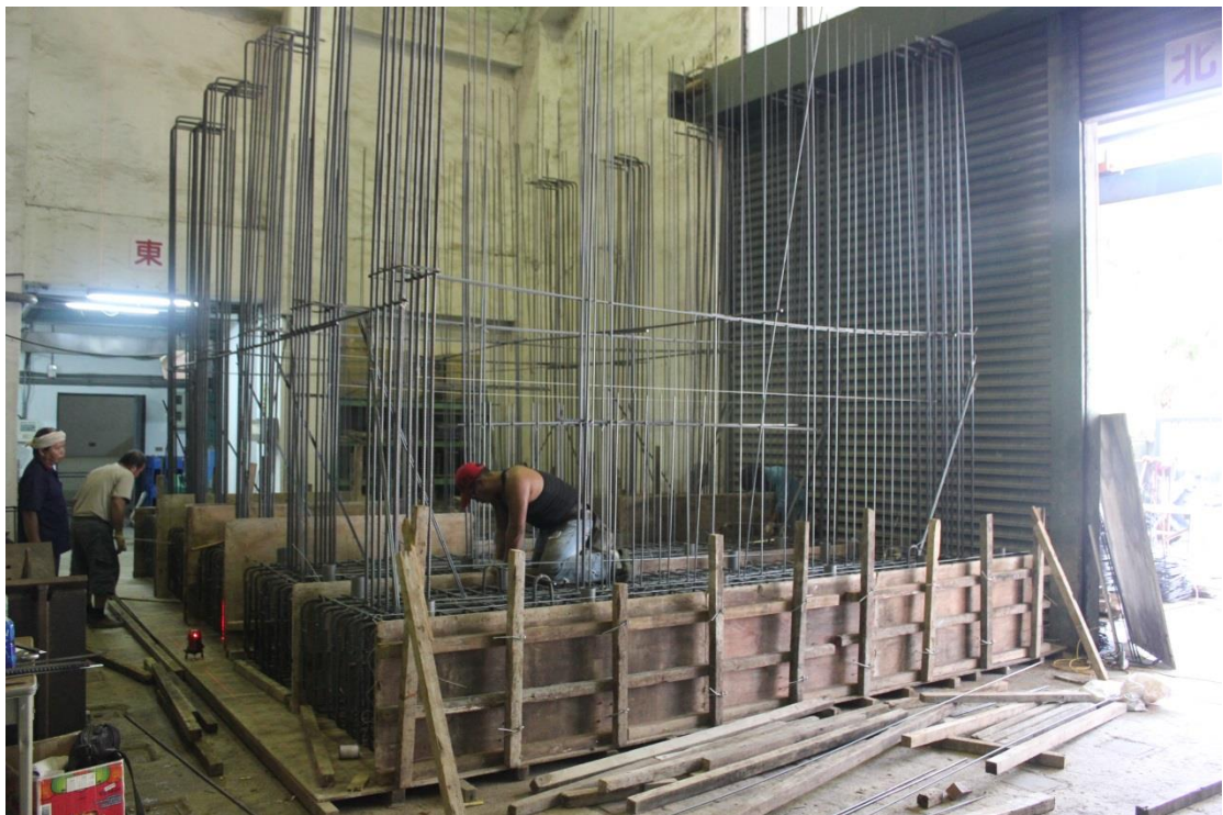
圖 B.12 以高壓空氣噴槍清潔基礎底板
