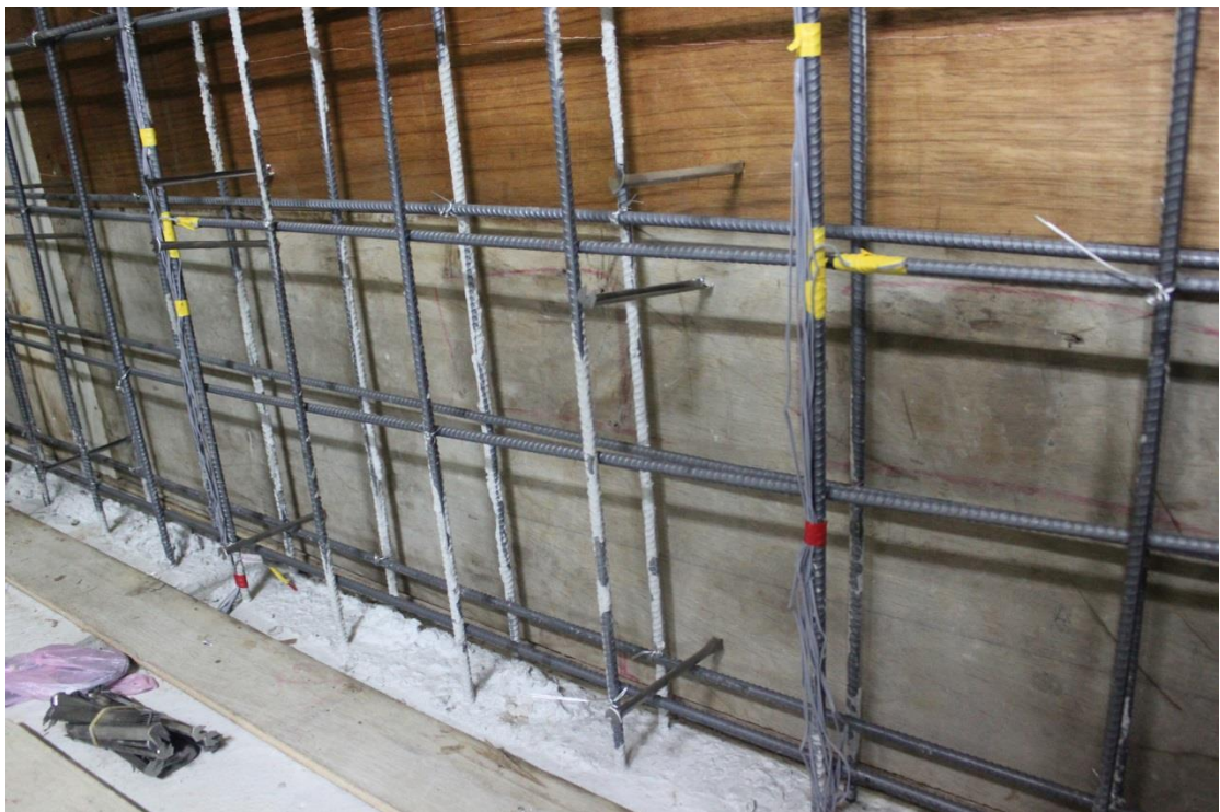
圖 B. 38 垂直牆筋及水平牆筋應變計施作
