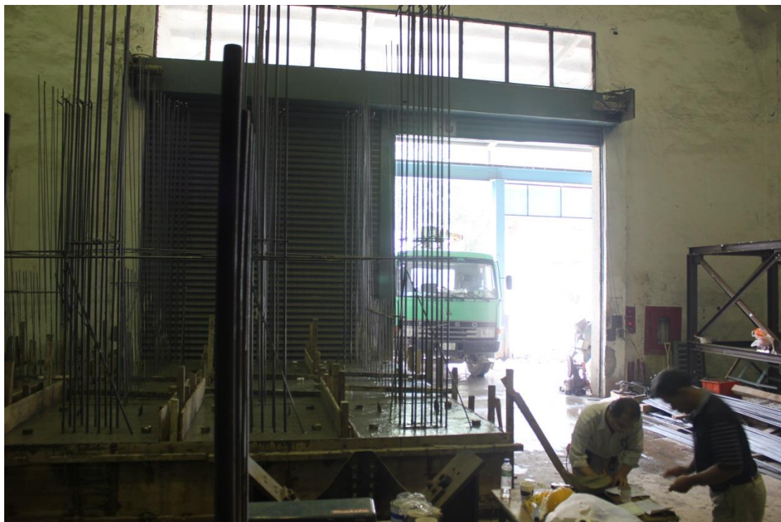
圖 B. 26 灌漿完成後基礎表面抹平
