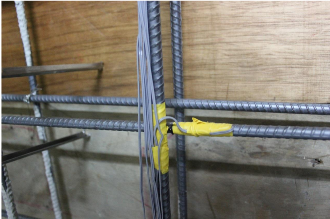
圖 B. 37 垂直牆筋及水平牆筋應變計施作
