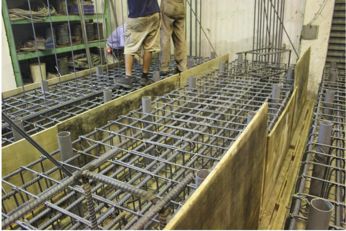
圖 B.7 基礎側模板組立
