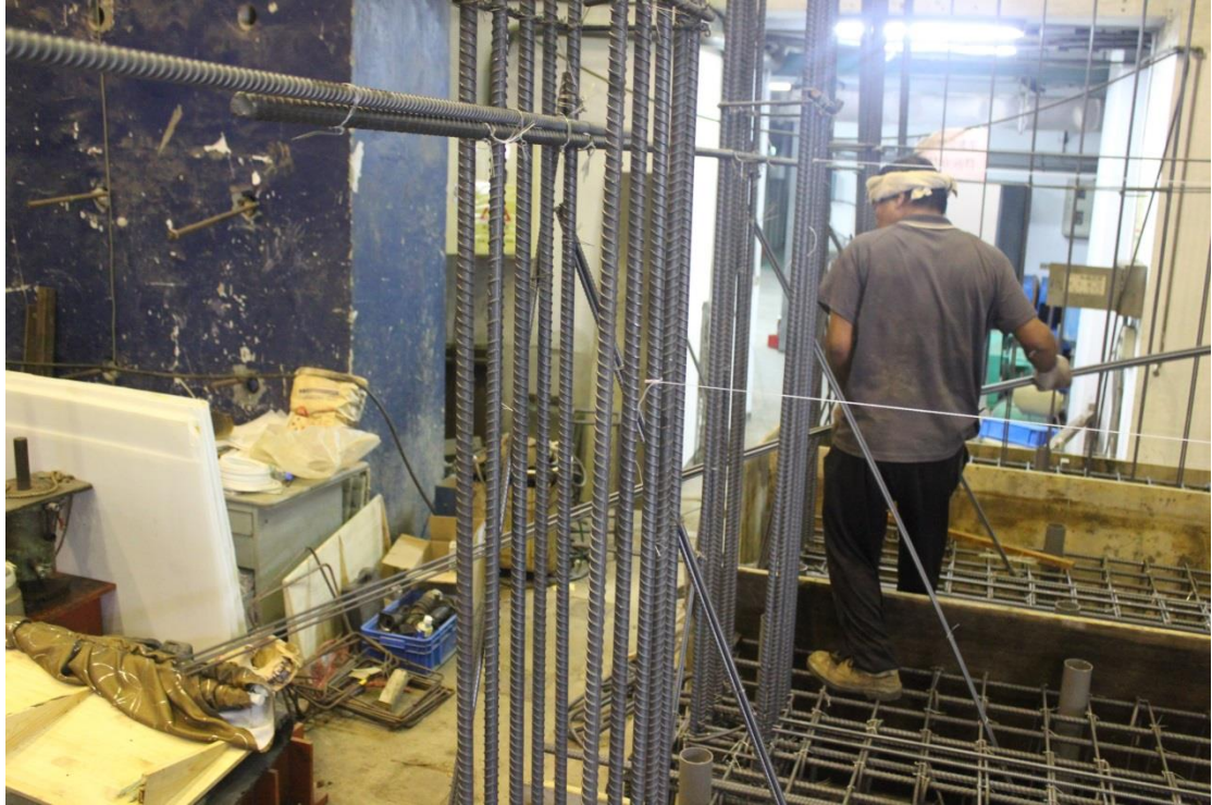
圖 B.11 開口邊垂直牆筋截斷高度水準線
