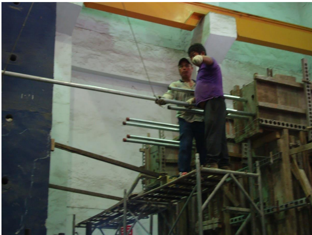
圖 B. 46 加載梁預力螺桿預留管穿鋼管加強防灌漿導致彎取過大
