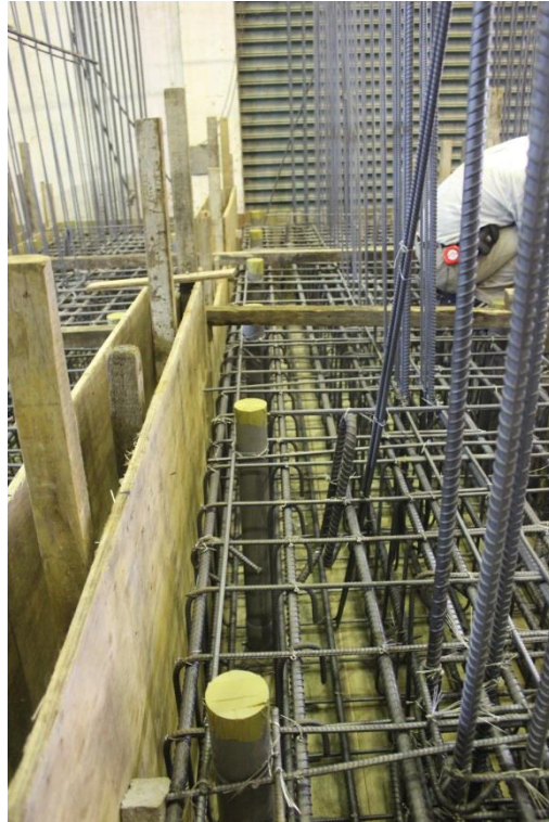
圖 B.15 基礎預埋管定位最後確認
