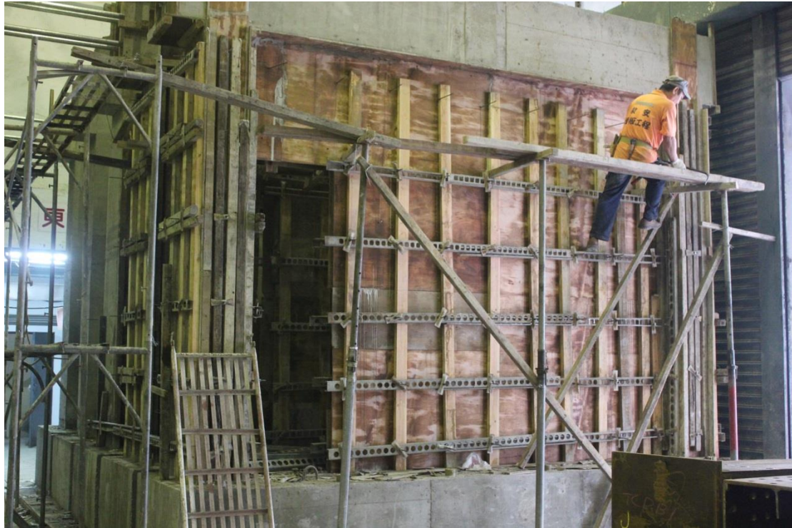
圖 B.51 灌漿完成後 3 天開始拆模
