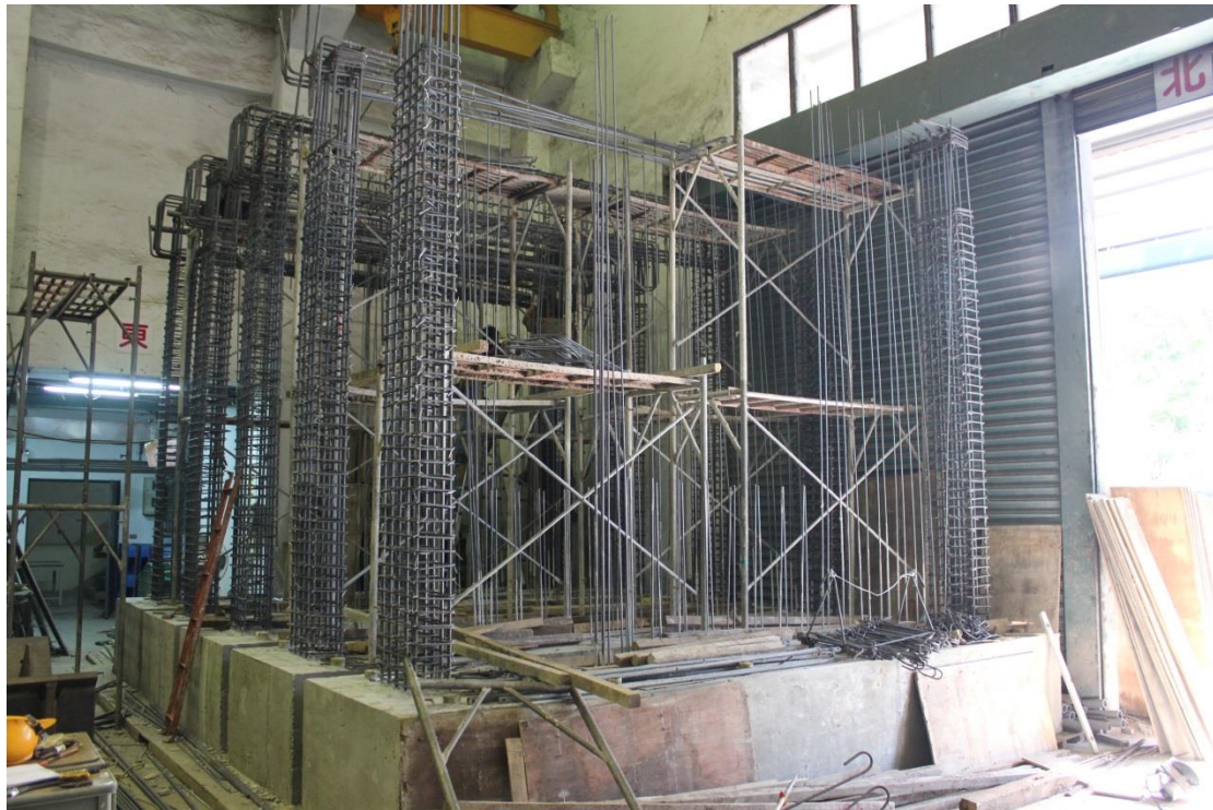
圖 B.33 柱箍筋綁紮完成及上部加載樑鋼筋組立
