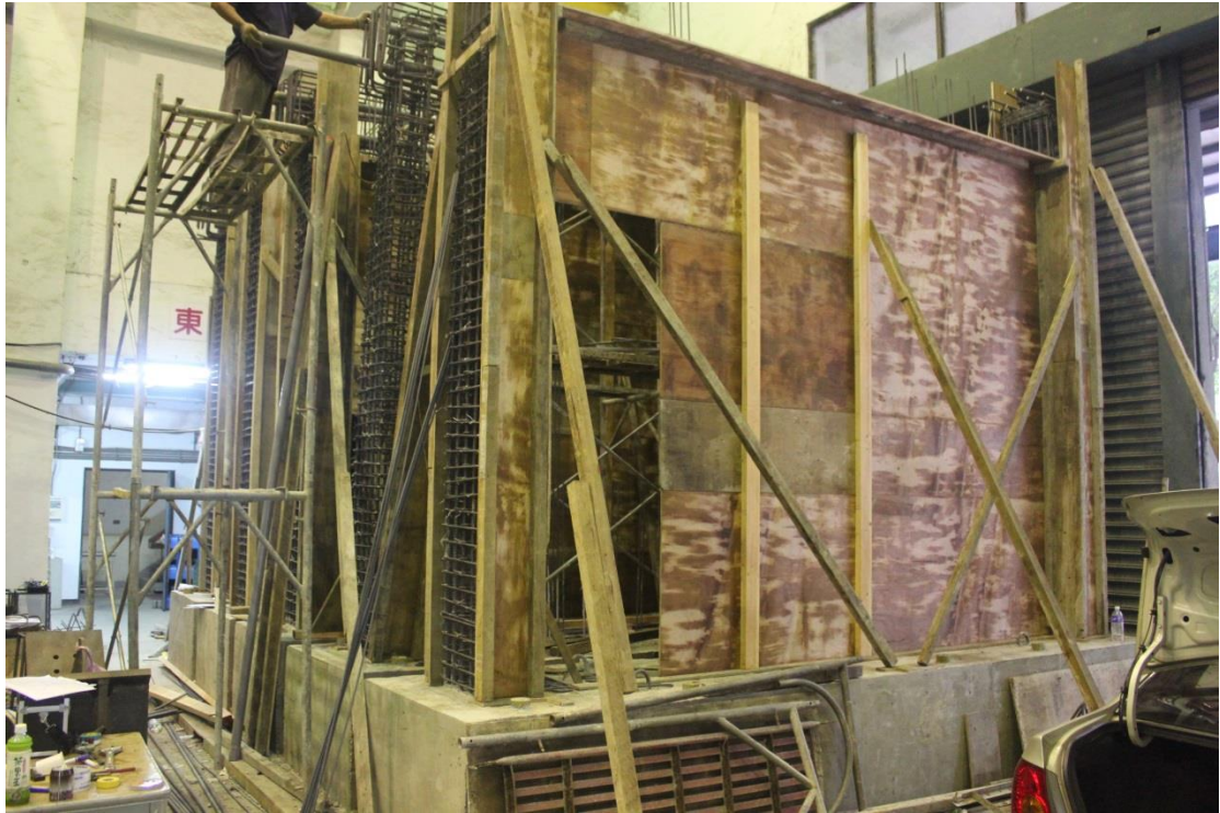
圖 B.35 牆筋綁紮及加載梁內預力螺桿預留管位定位
