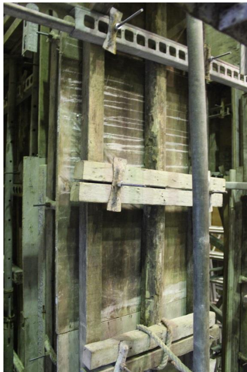
圖 B.44 模板側向加強固鎖(柱側)
