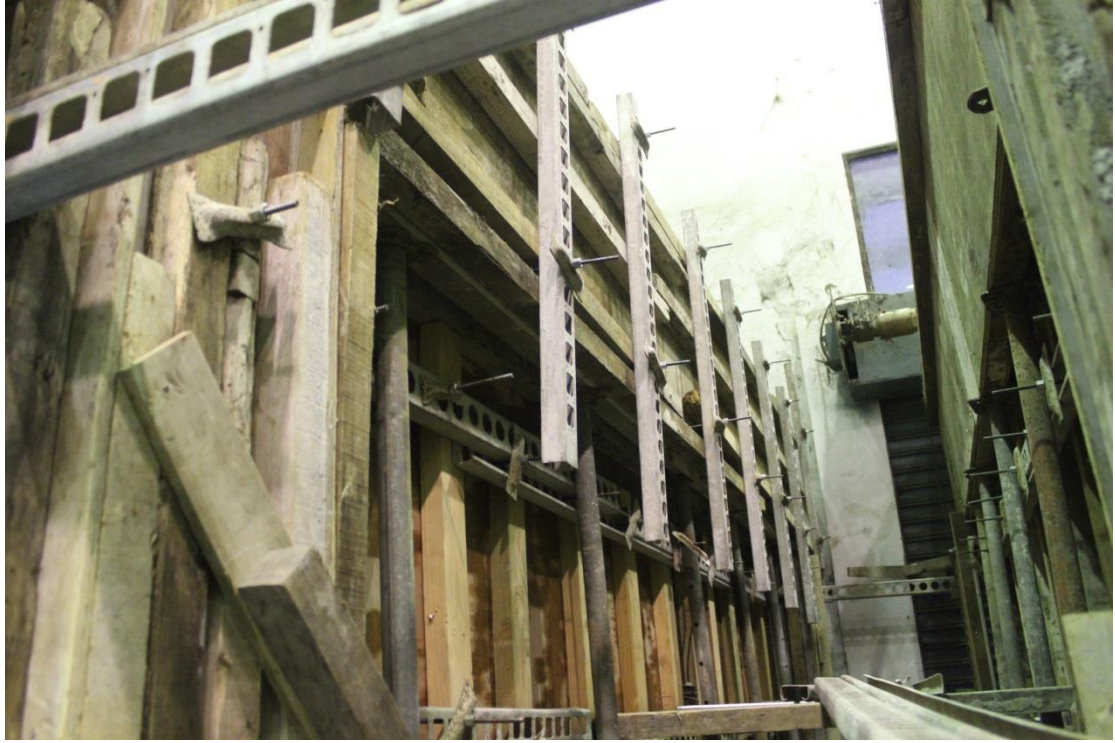
圖 B.43 模板側向加強固鎖(牆側)
