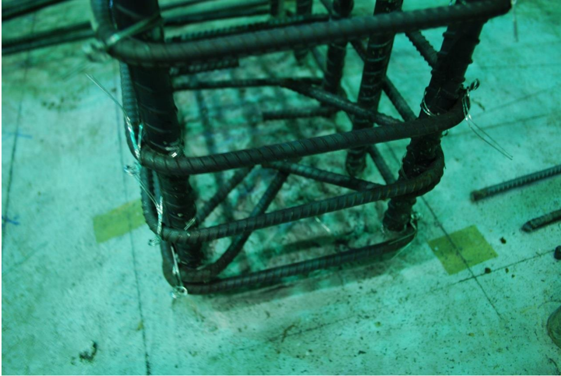
圖 B. 31 柱箍筋彎鈎位置輪換
