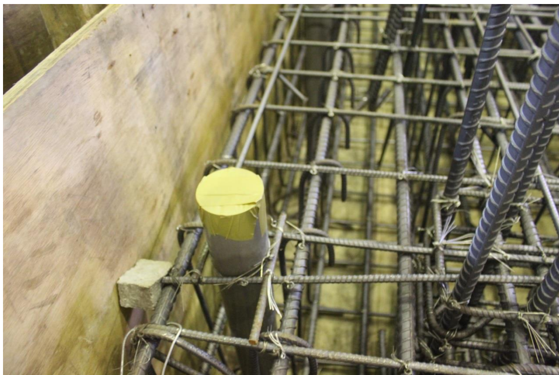
圖 B.14 灌漿前基礎 PVC 套管防護處理
