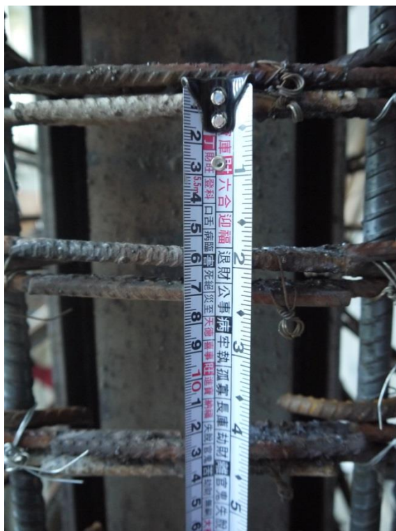
圖 C- 83 二樓柱箍筋鉚接與綁紮完成照(二)
