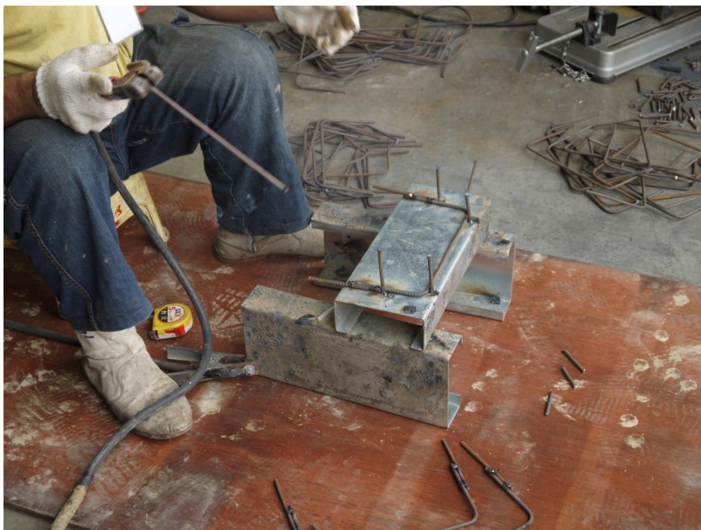
圖 C-58 柱箍筋現場銲接施工照
