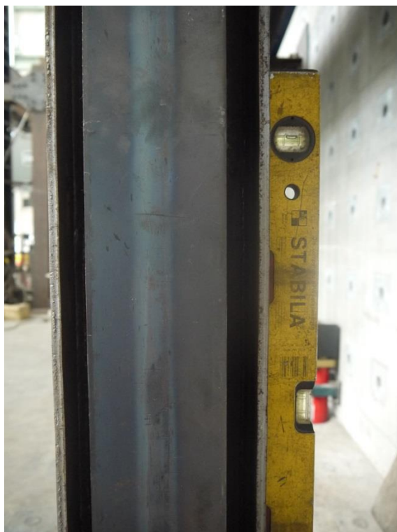
圖 C-46 鋼柱水平與垂直度檢核照
