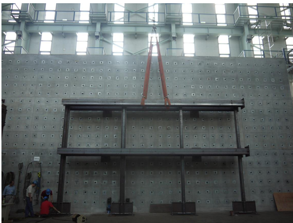
圖 C-47 試體鋼結構之定位完成照
