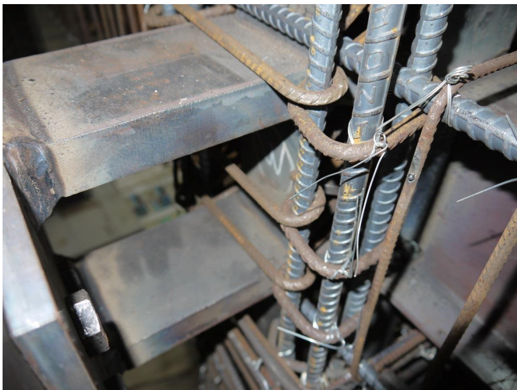
圖 C-72 Cd1 - 1Cd2梁柱交會區完成照(二)
