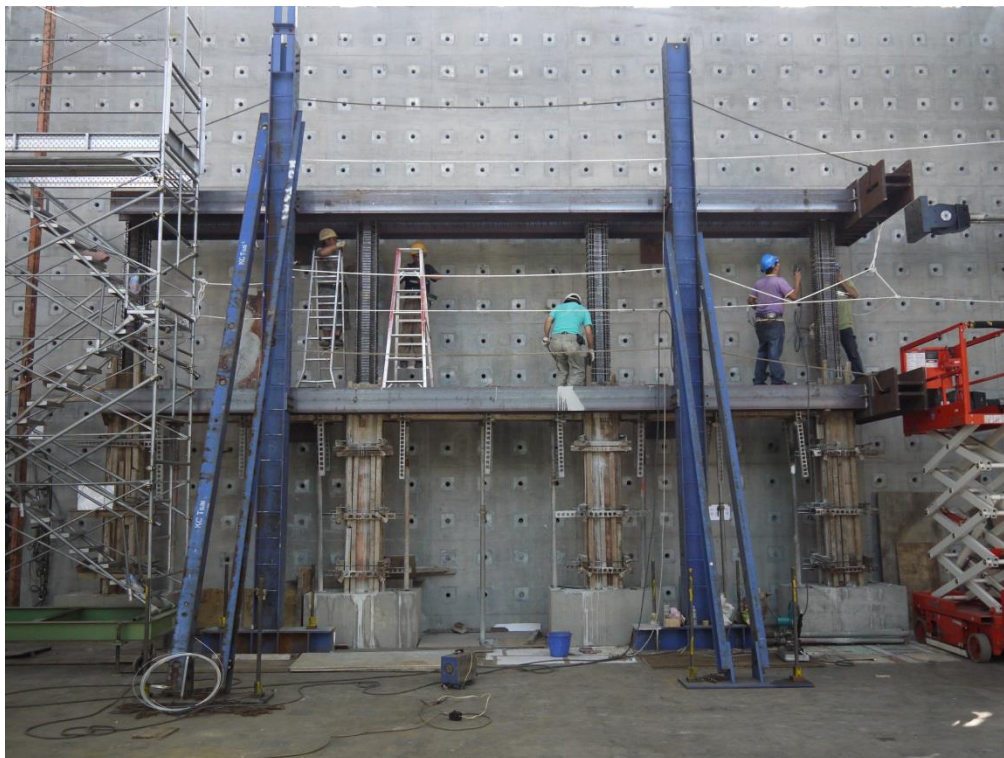
圖 C-80 一樓梁與柱灌漿完成照
