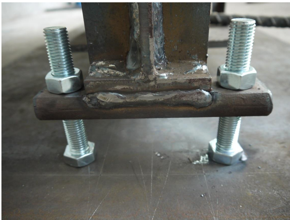
圖 C-42 鋼結構基礎預留保護層施工照
