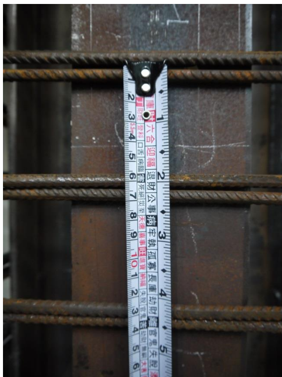
圖 C-60 柱箍筋銲接與綁紮完成照(完成面與 200 頓 Actuator 平行)
