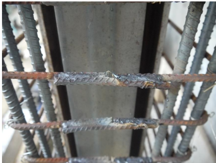
圖 3-14 柱閉合箍筋銲接完工圖
