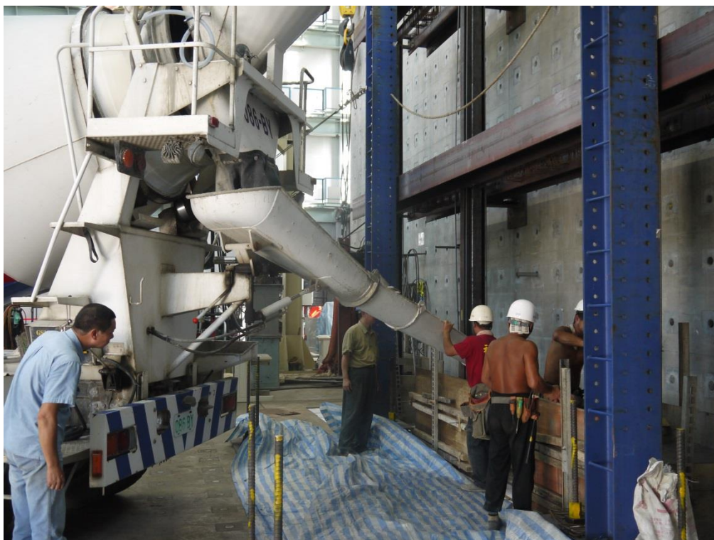
圖 C-54 基礎混凝土澆置施工照
