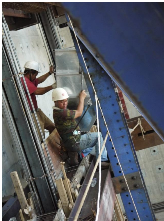
圖 C-79 一樓梁與柱灌漿施工照(二)
