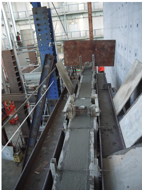
圖 C-94 二樓混凝土澆鑄完成照
