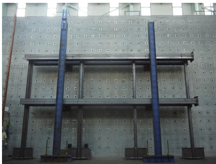
圖 3-10 現場鋼構組裝與吊裝完成圖
