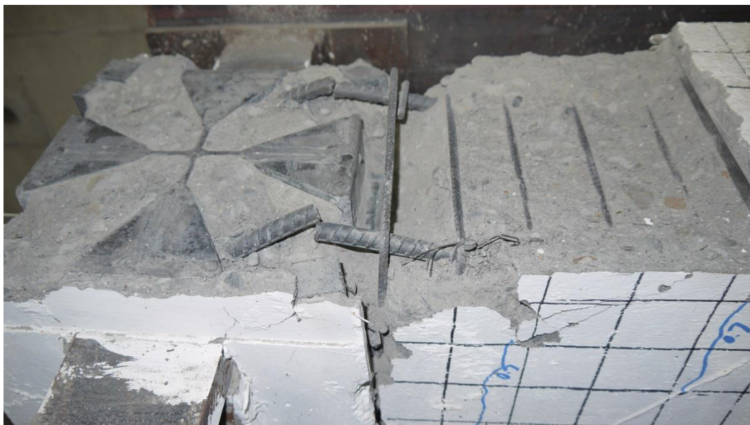
圖 4-37 梁 RB3 之梁頂主筋於實驗中止後之破壞情形
