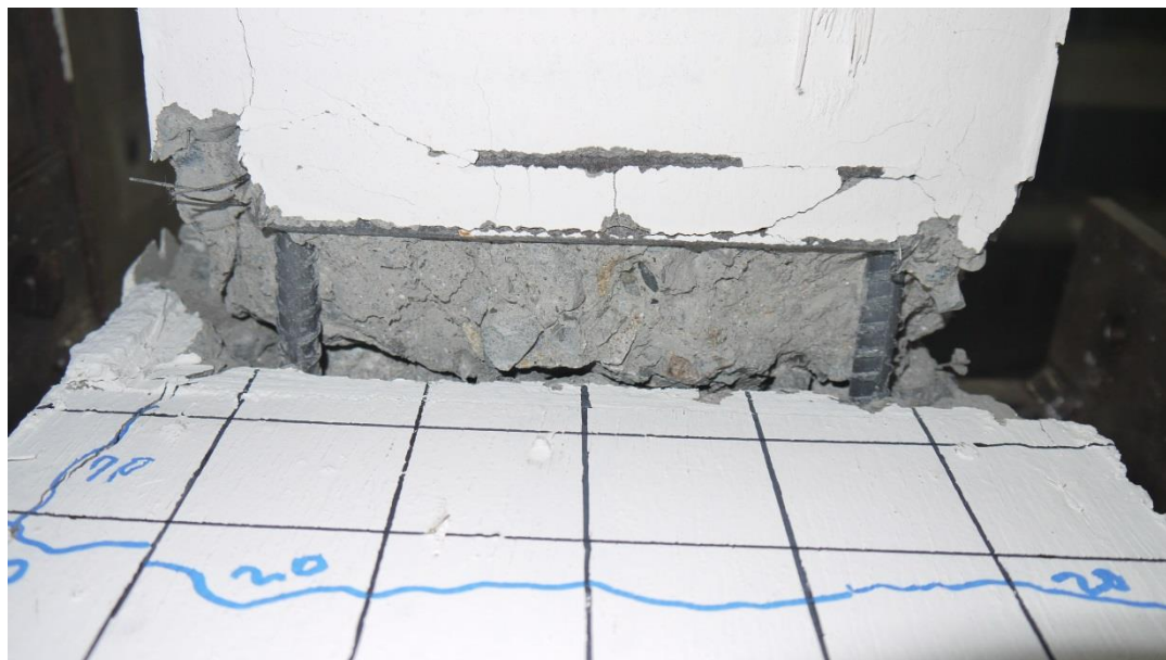
圖 4-39 梁 RB1 底部於實驗中止後之破壞情形
