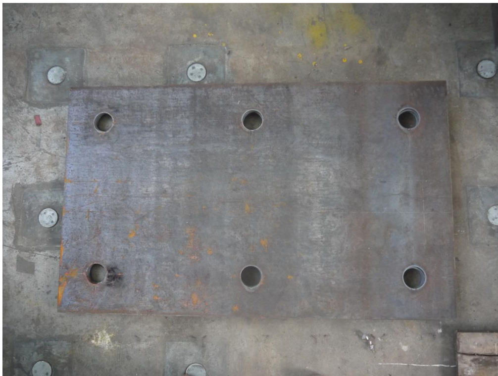
圖 C-40 鋼結構基礎底模
