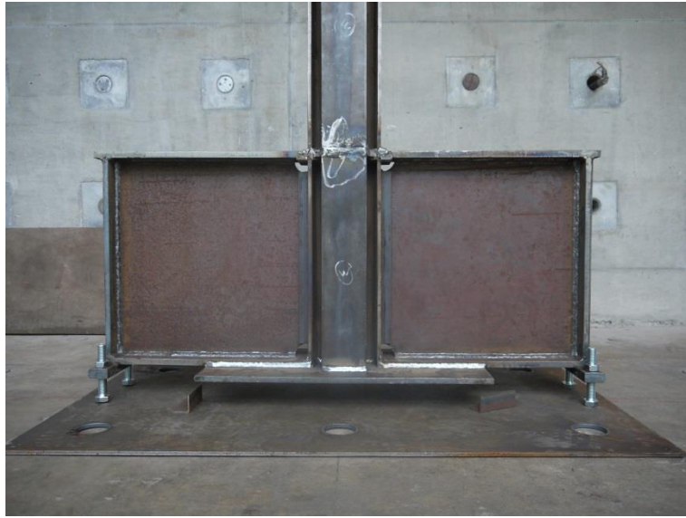
圖 3-11 鋼構基礎細部圖
