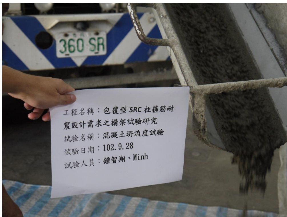
圖 C-90 自充填混凝土取樣照(二樓混凝土)
