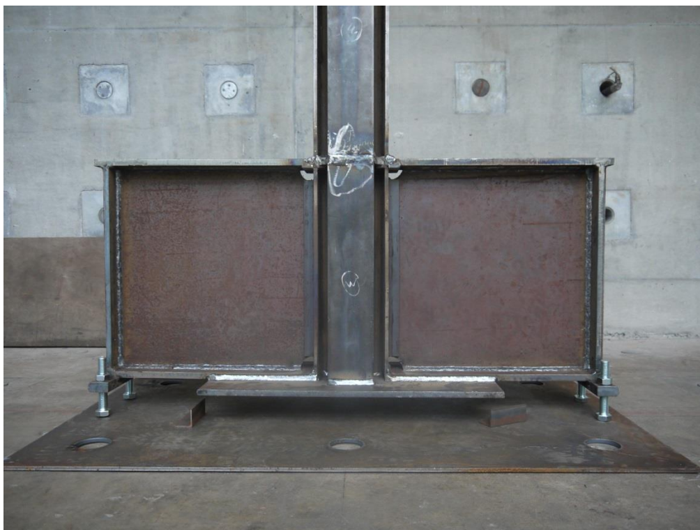
圖 C-44 鋼結構基礎定位完成照(正視)
