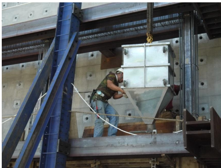
圖 3-17 現場灌漿施工照
