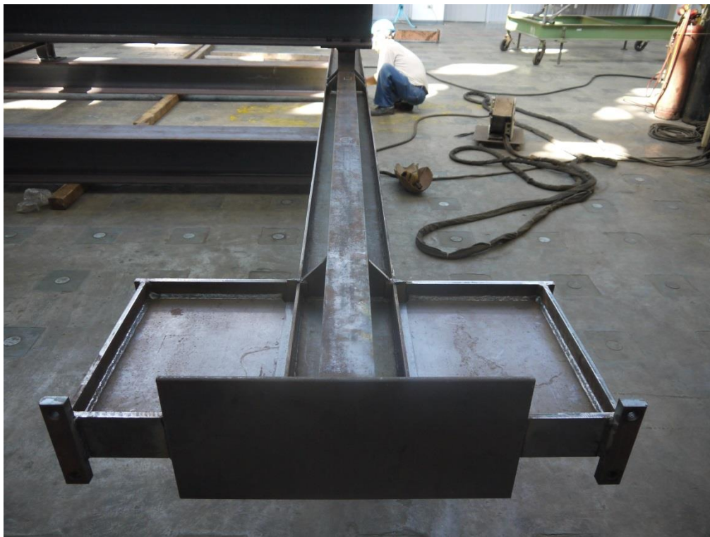
圖 C-32 1Cd1 – 1Cd2 柱鋼構基礎照
