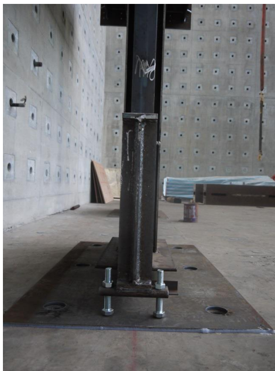
圖 C-43 鋼結構基礎定位完成照(側視)
