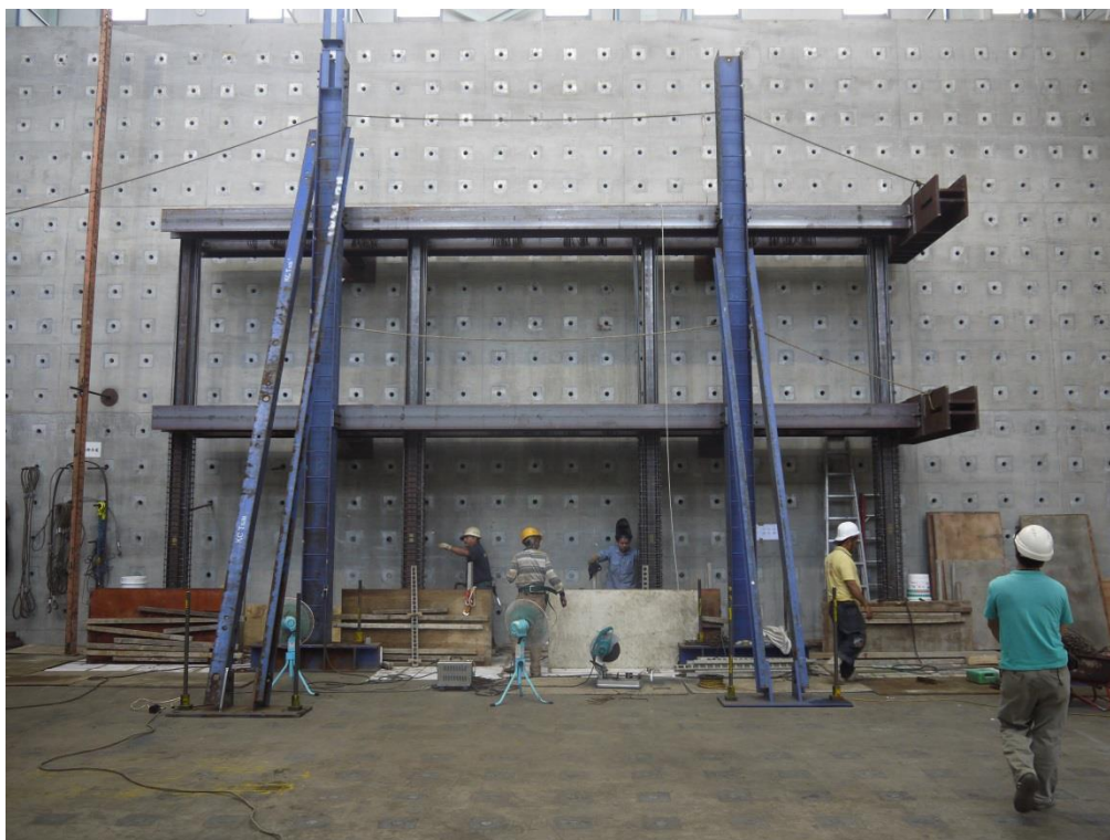
圖 C-62 柱箍筋銲接與綁紮完成照(正視)
