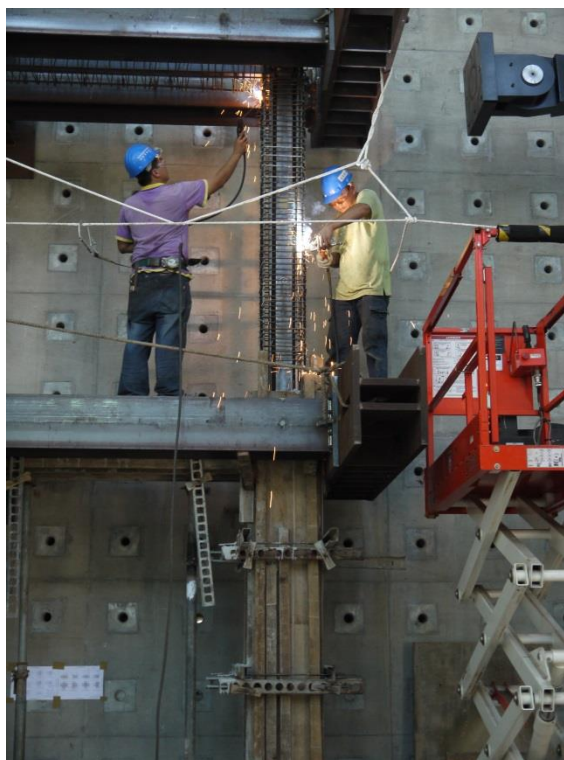
圖 C-81 二樓柱箍筋銲接與綁紮施工照
