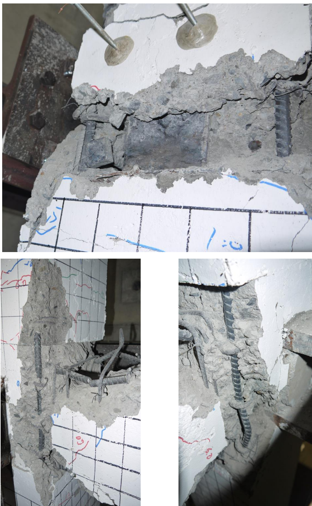
圖 F-19 構架試體第二層柱編號 2Cd_2 於實驗結束後之破壞情形 (資料來源：本研究拍攝)
