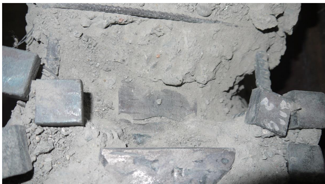
圖 4-40 梁 RB1 頂部於實驗中止後翼板斷裂情形
