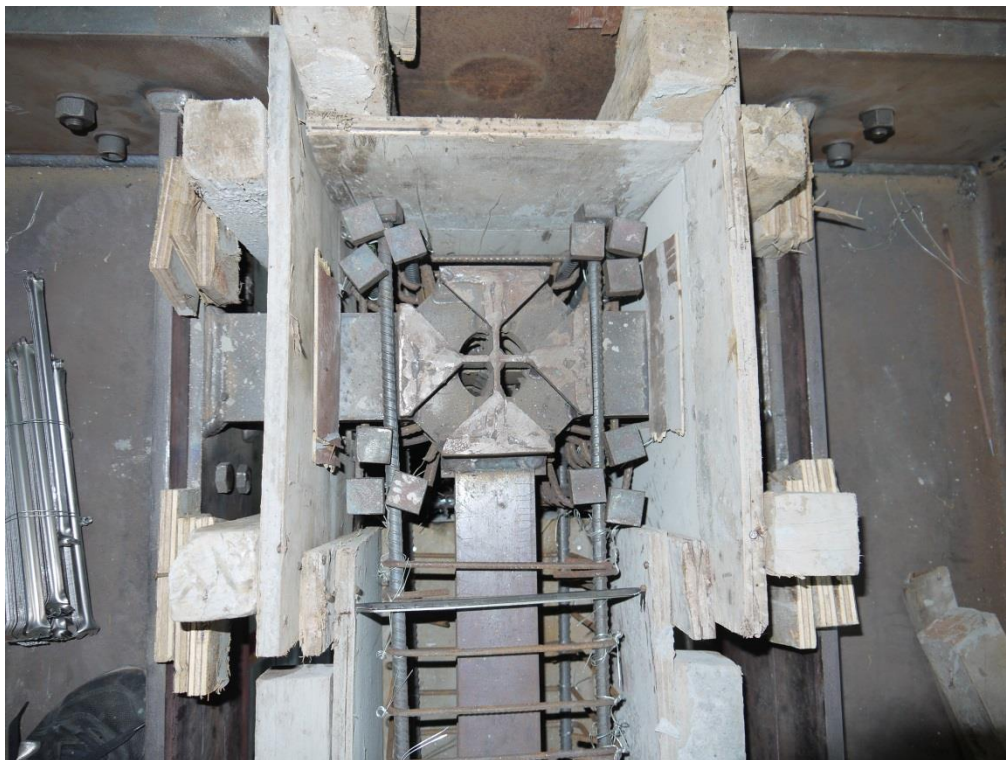
圖 C- 88 2Cs2柱頂梁柱交會區完成照
