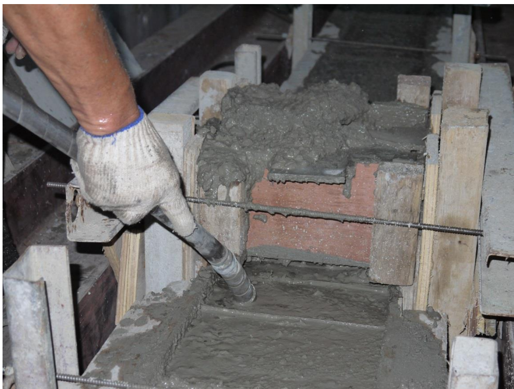
圖 C-93 二樓混凝土澆鑄施工照(二)
