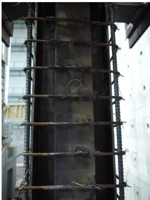
圖 C- 82 二樓柱箍筋鉚接與綁紮完成照(一)
