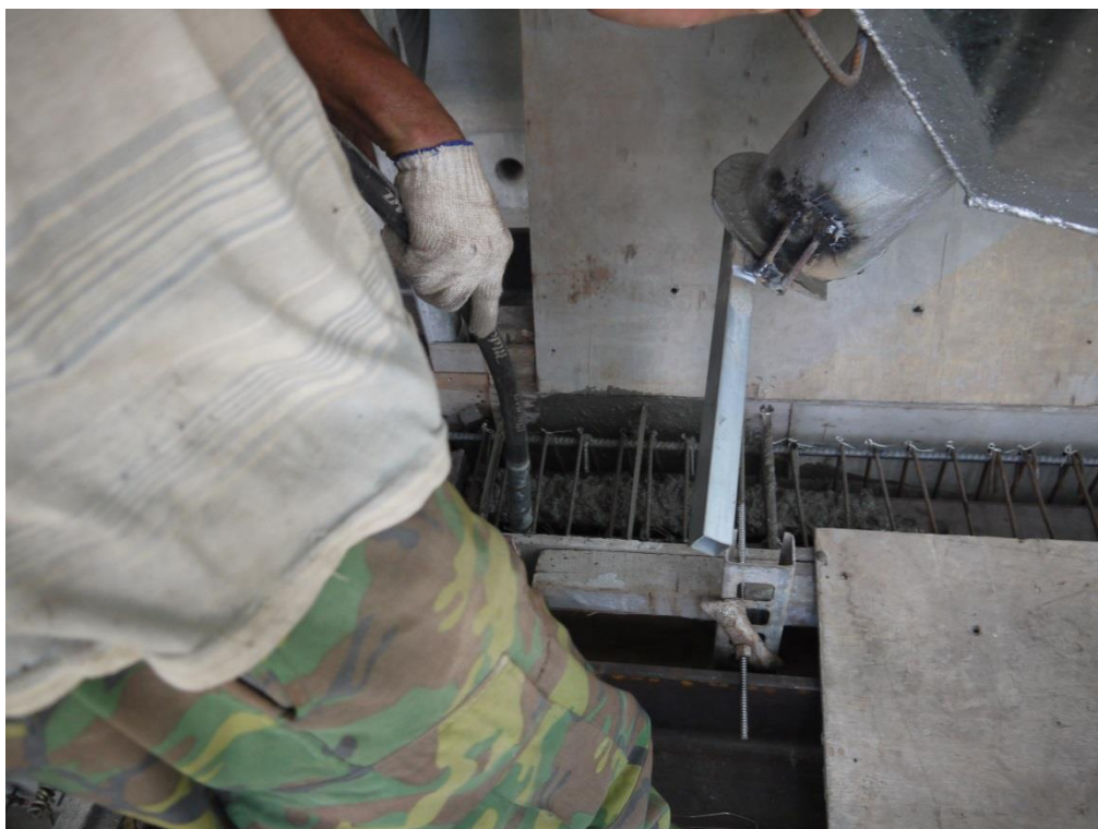
圖 C-92 二樓混凝土澆鑄施工照(一)
