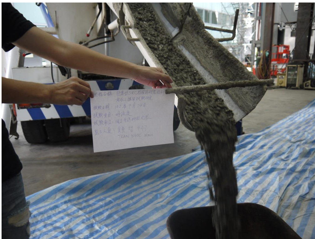
圖 C-50 自充填混凝土取樣照(基礎混凝土)
