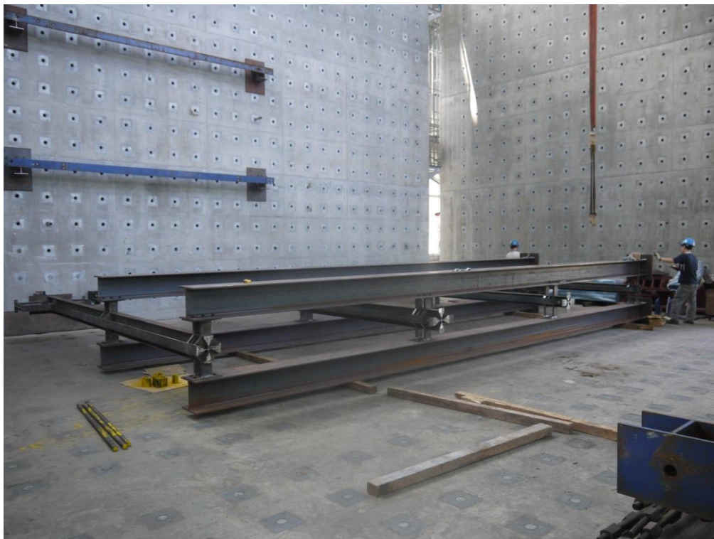
圖 C-36 鋼柱與夾具梁螺栓接合完成
