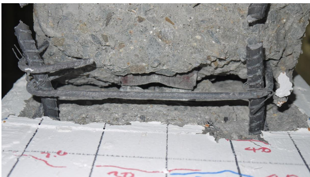
圖 4-36 梁 RB3 之梁底鋼骨翼板於位移比 8% 時之破壞情形
