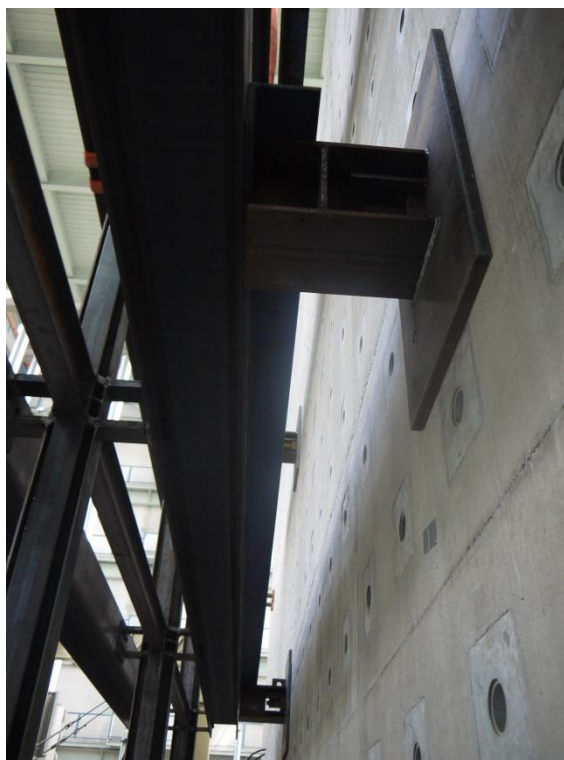
圖 C-45 整體鋼構架與反力牆栓接完成照
