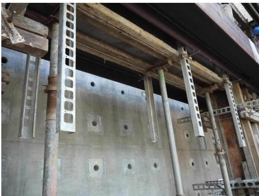
圖 C-75 一樓梁模板組立完成照
