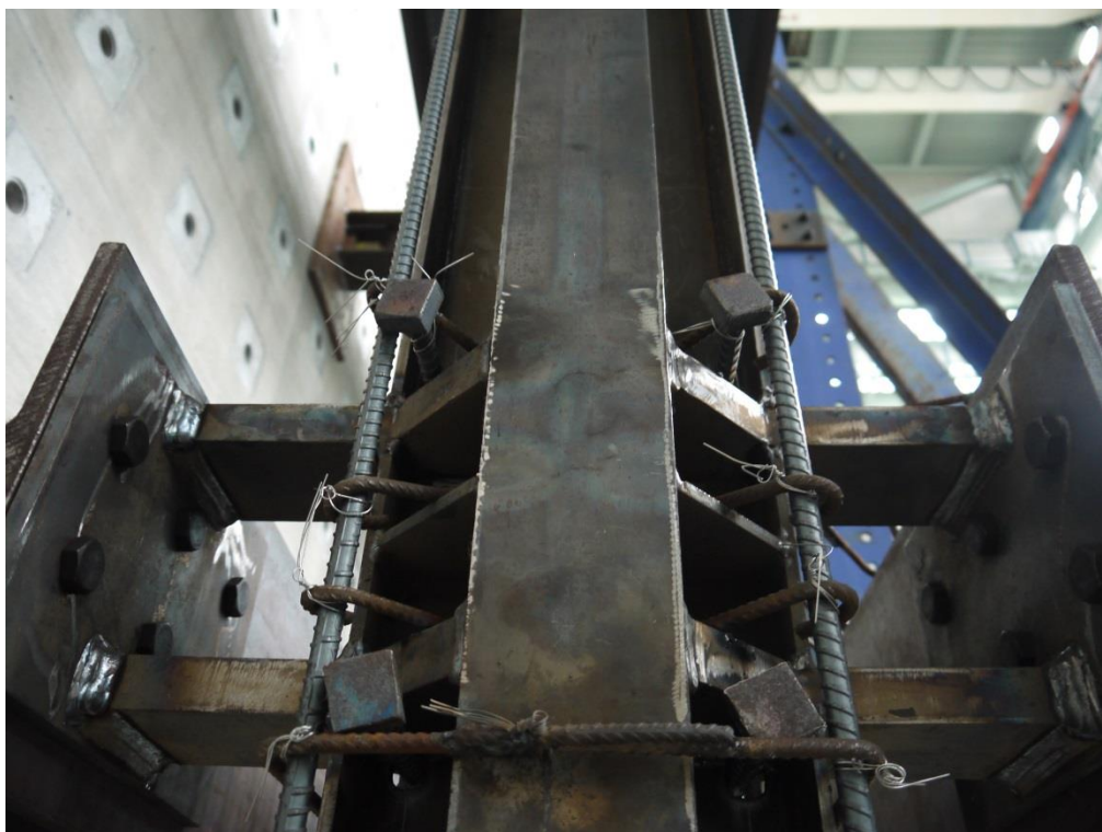
圖 C-70 1Cs1 - 1Cs2 梁柱交會區完成照(二)
