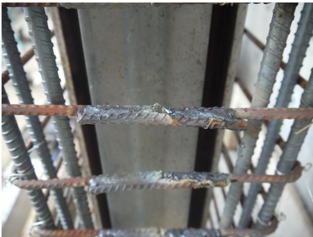
圖 C-59 柱銲接完成照(完成面與 200 頓 Actuator 垂直)
