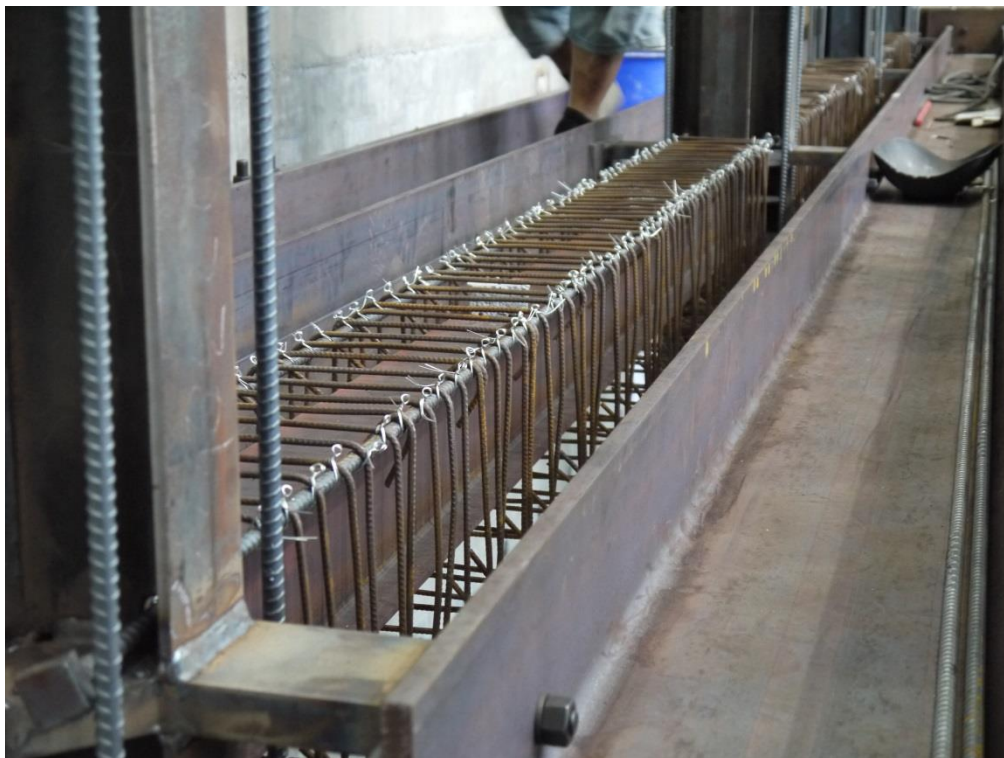
圖 C-64 梁箍筋綁紮施工照
