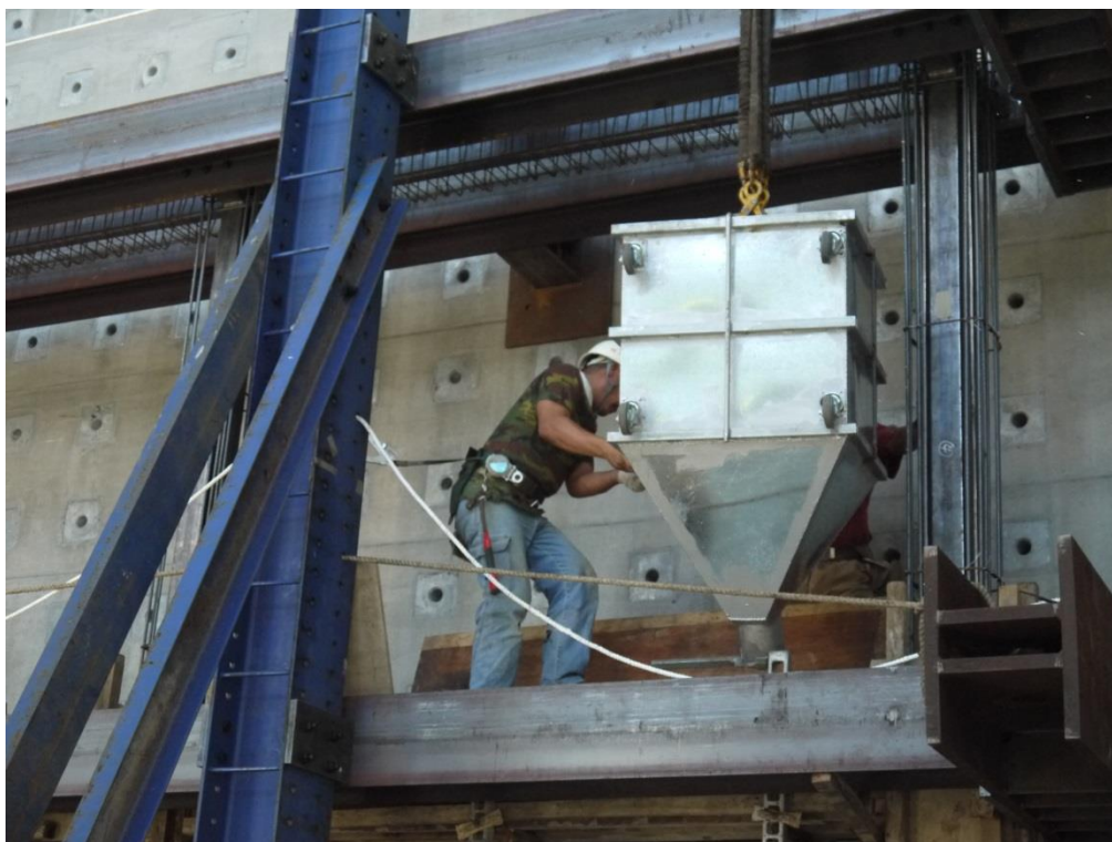
圖 C-78 一樓混凝土澆鑄施工照(一)
