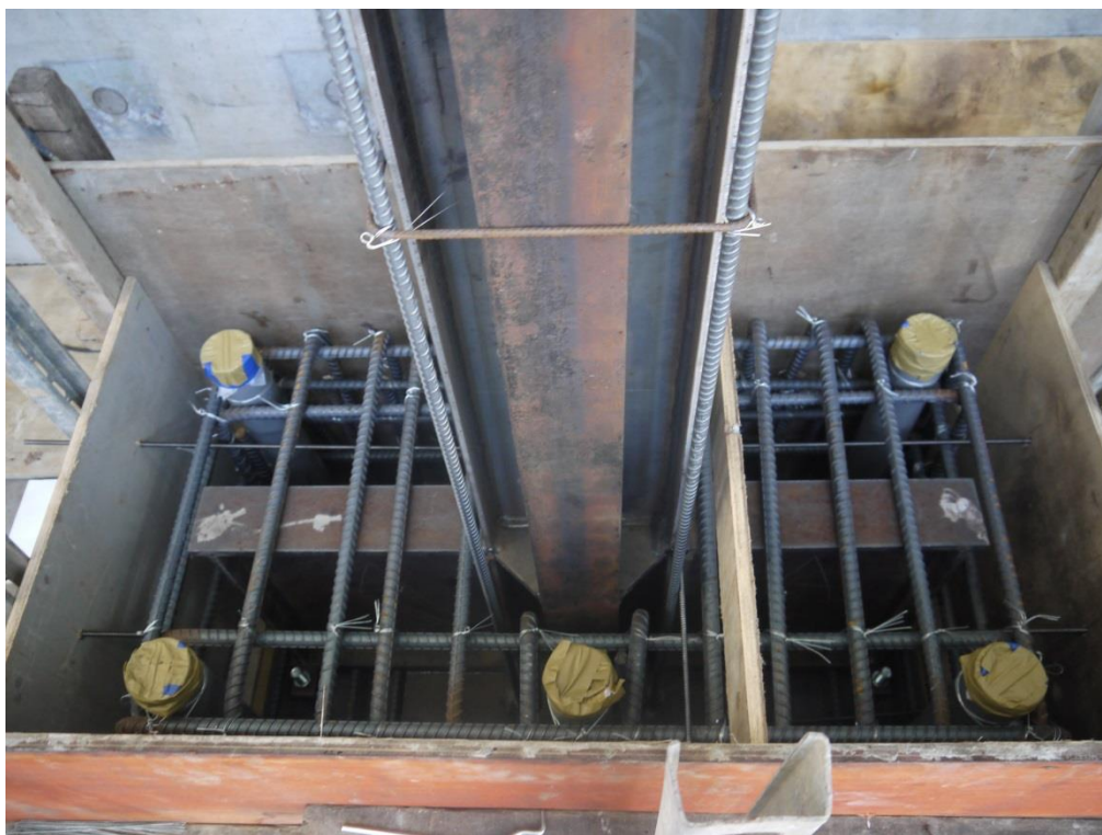
圖 C-49 構架試體基礎模板組立與鋼筋綁紮完成照
