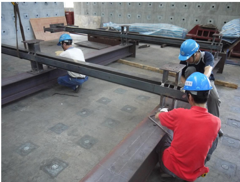
圖 C-34 鋼柱與夾具梁螺栓接合施工照
