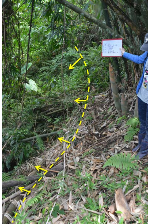
圖 6.42 點位 SP4 潛在崩塌現況
