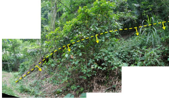
圖 6.38 點位 SP2 崩塌現況
