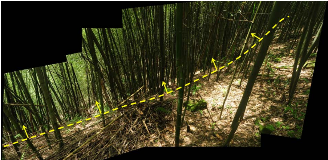
圖 6.49 點位 SP9 潛在崩塌現況
