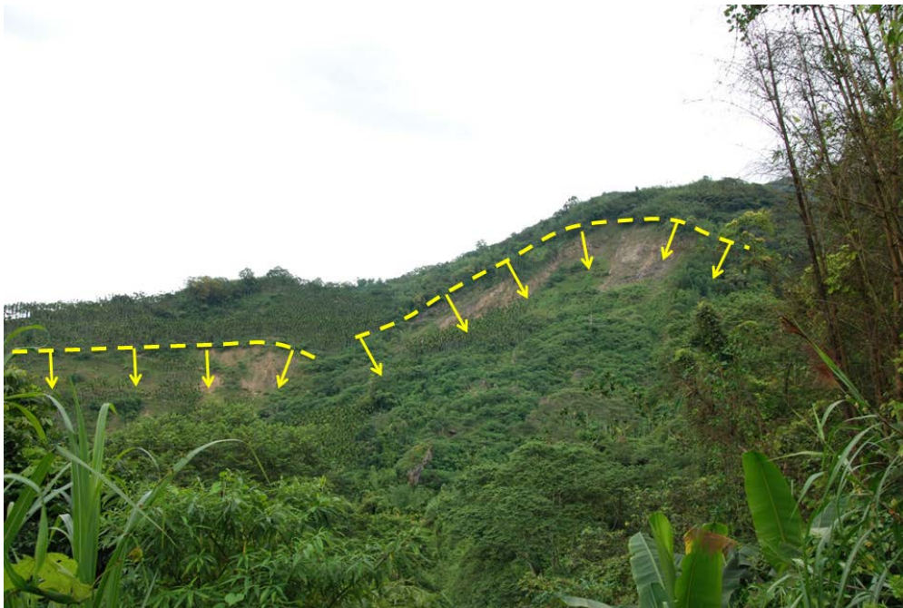
圖 6.51 點位 SP10 潛在崩塌現況
