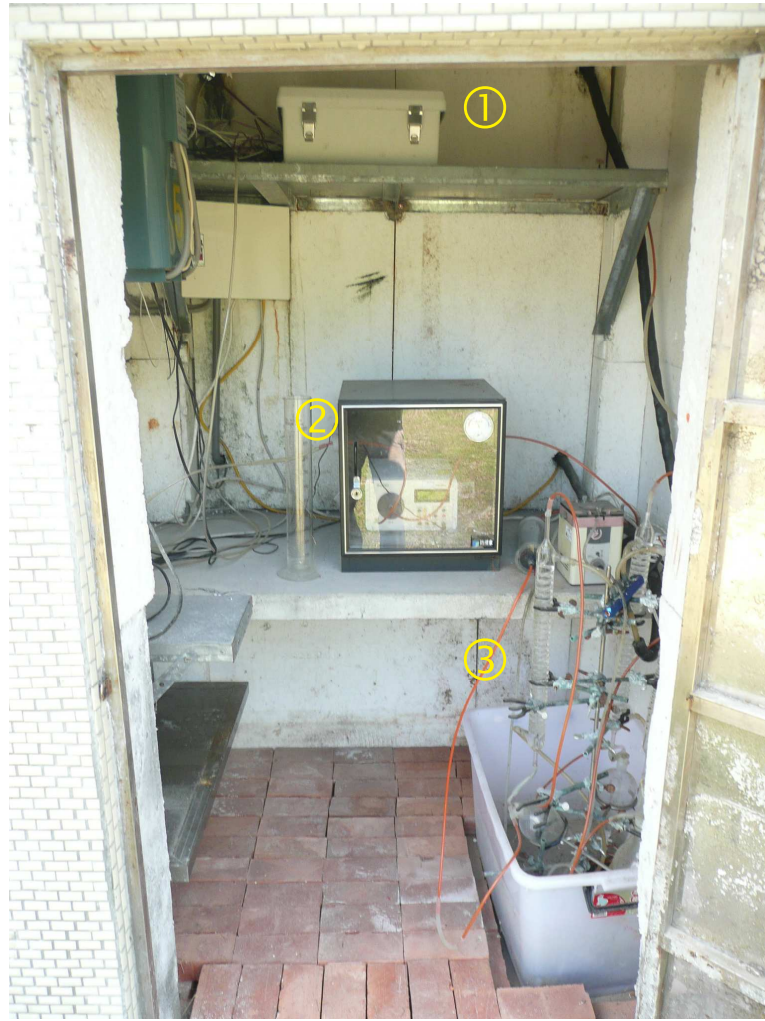
圖 7-18：安通站內部配置（①：井水溫度記錄器，CR-800；②：氬氣分析儀，SARAD；③：氣體冷凝裝置）。
