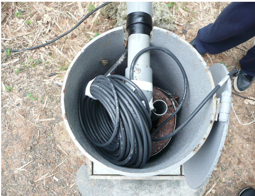
圖 7-27：墾丁公園社頂站放置自動水位紀錄儀之水井內部圖。
