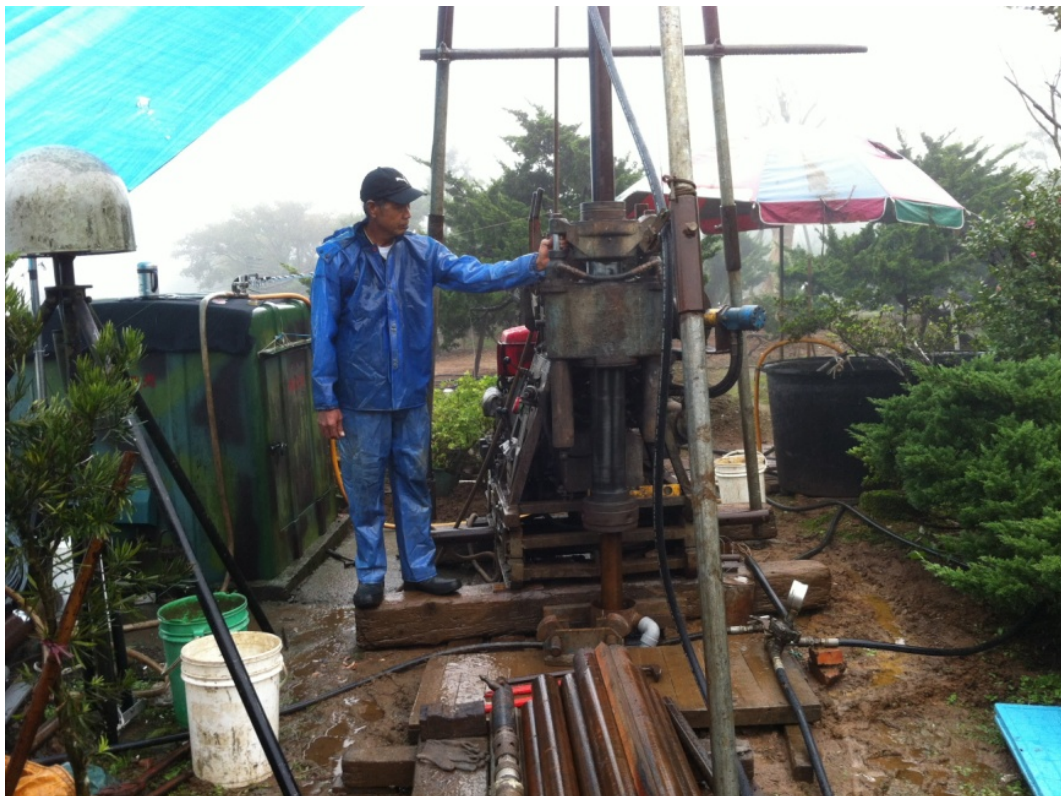
圖 49 淺井地震站現場施工情況。
