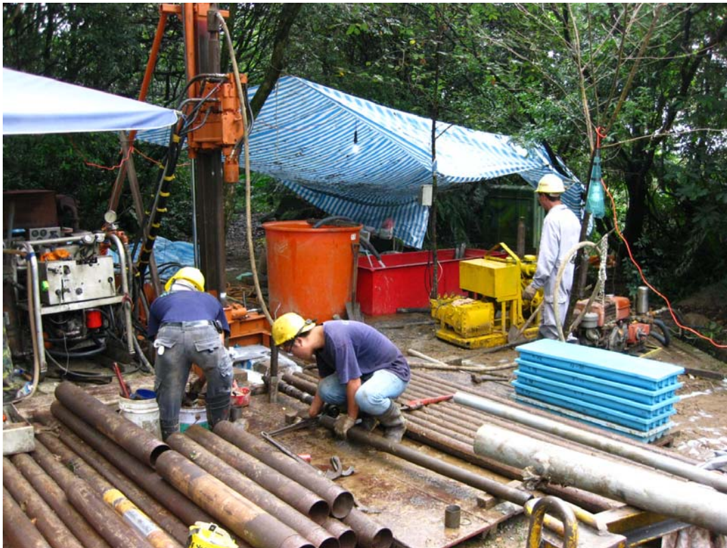
圖 47 深井地震站現場施工情況。
