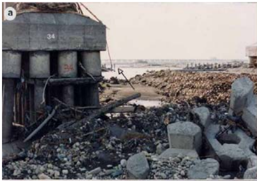
(a) P34及其右側之蛇籠工已流失 (b)由側面所見P34~P35之災情
