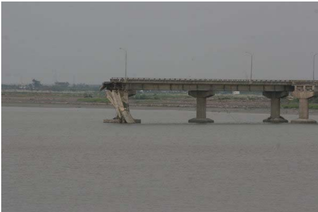
圖 2.18 雙園大橋斷橋(新園端) [13]
