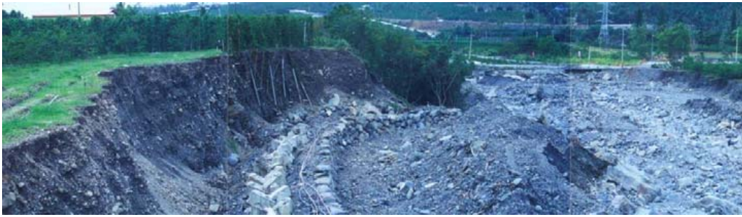
(a)引道伸入河道中導致上游壅水、高灘地崩塌
