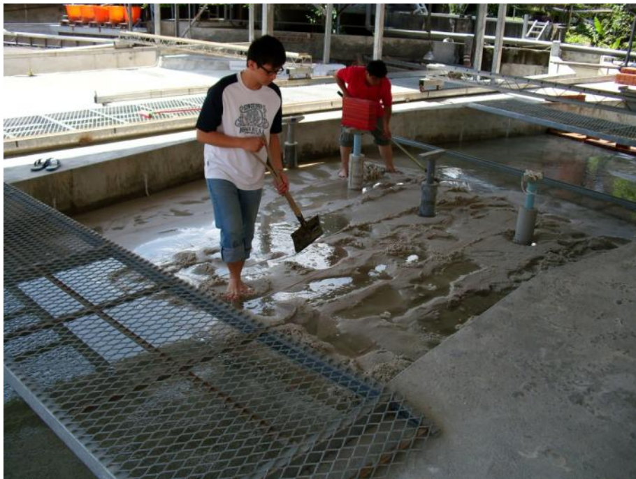
圖 5.6 砂土回填及整平
