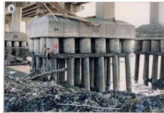
(a) P34及其右側之蛇籠工已流失 (b)由側面所見P34~P35之災情
