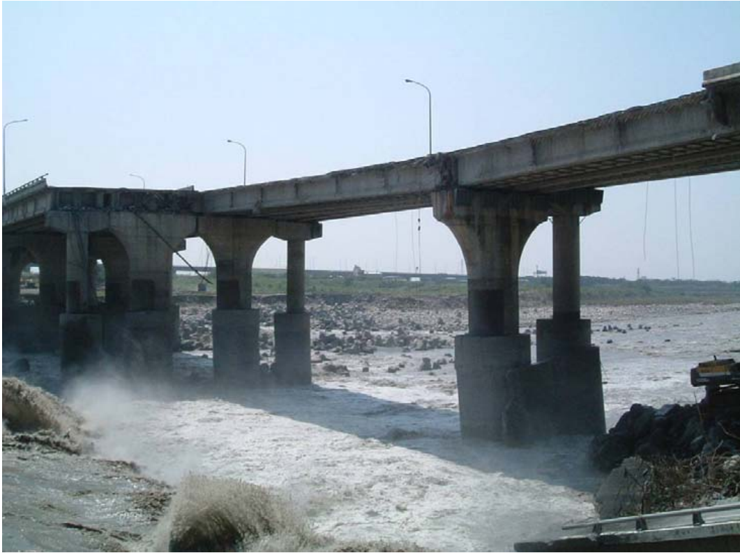
圖 2.15 台 13 線后豐大橋斷落事件 [6]
