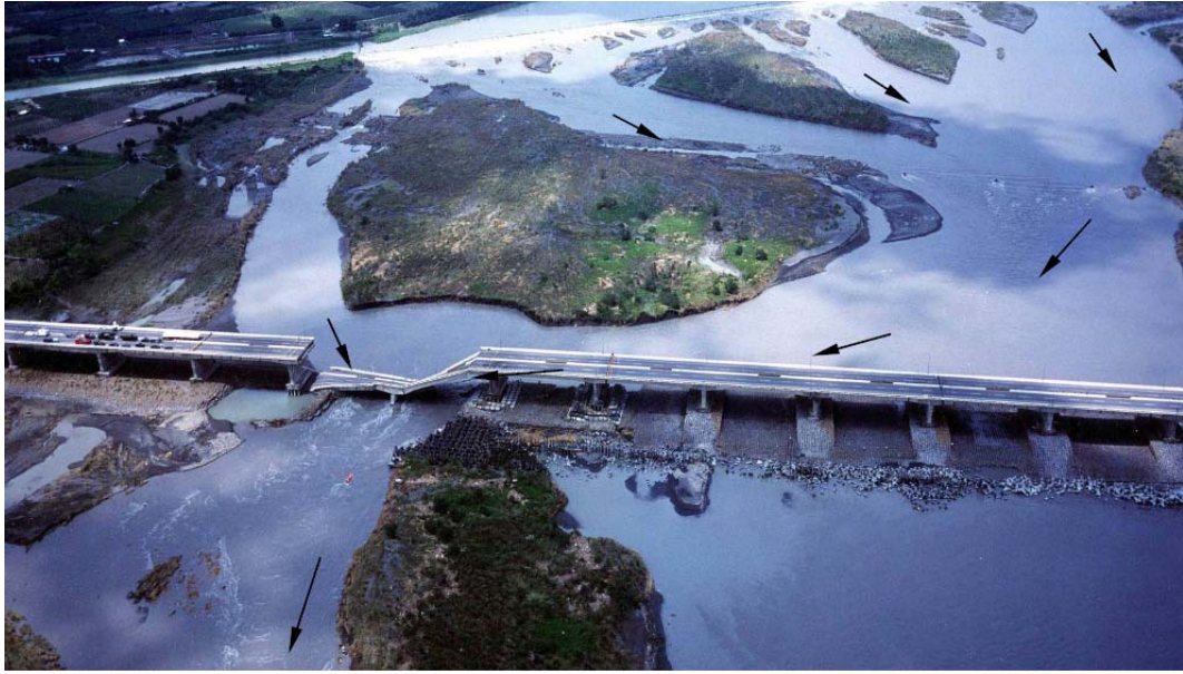
圖 2.8 高屏大橋斷裂落橋事件 [6] (林呈教授空拍, 2000/8/28)
