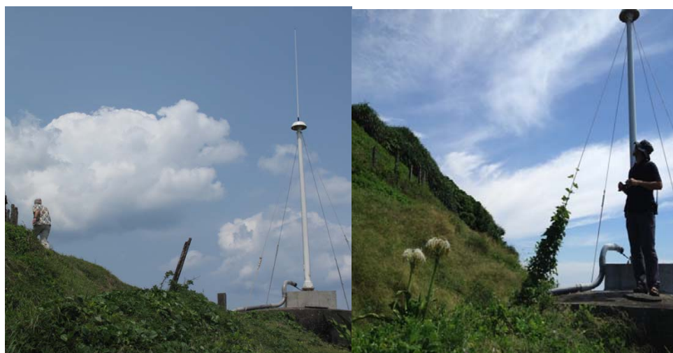
圖 1-1.2 屏東旭海站金屬物拆除
