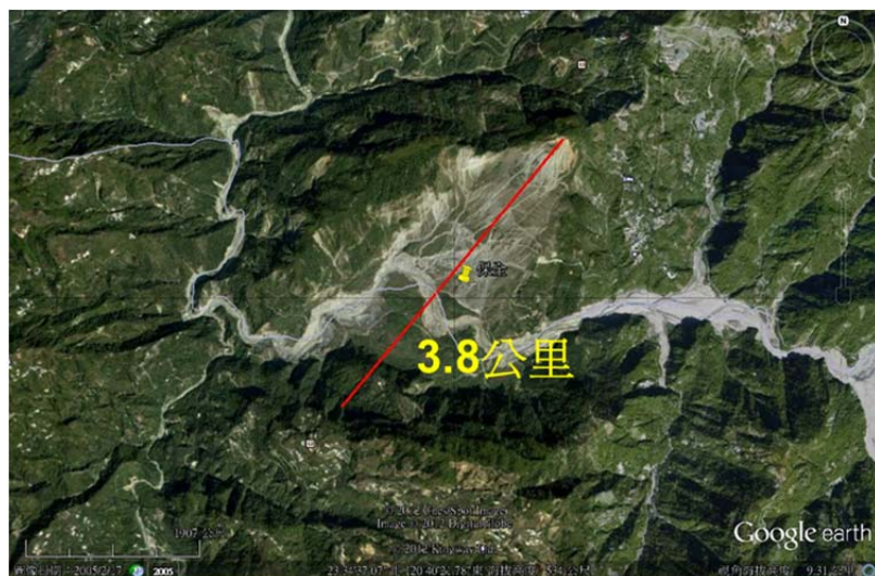
圖 3-2 草嶺崩塌影響範圍由坡頂至清水溪對岸坡面可達 3.8 公里
