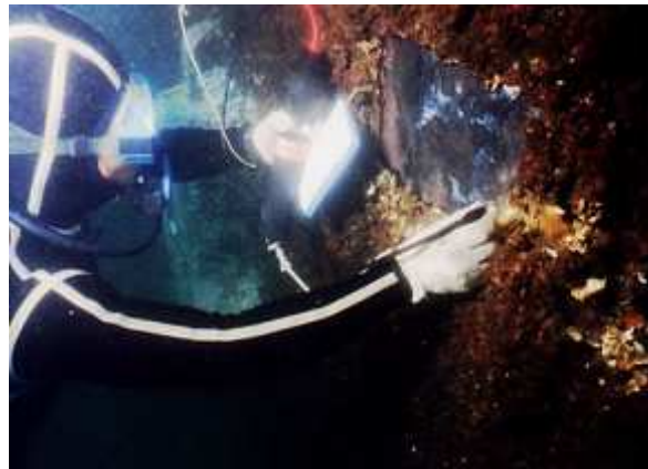
圖 4.13 水面下量測鋼板樁厚度之情形
