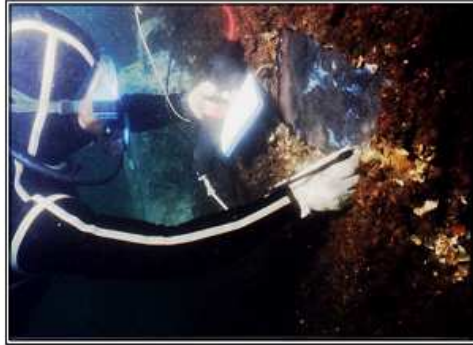
圖 2.26 水面下量測鋼板樁厚度之情形
