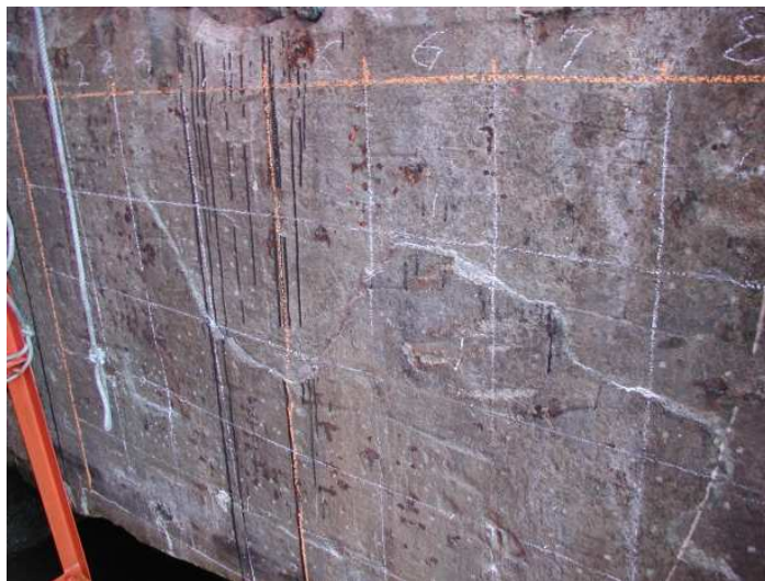
圖 4.1 碼頭岸壁面繪製方格
