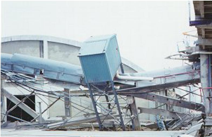
圖 1.5 集集地震臺中港倉儲輸送設備因土壤液化產生嚴重下陷傾斜
