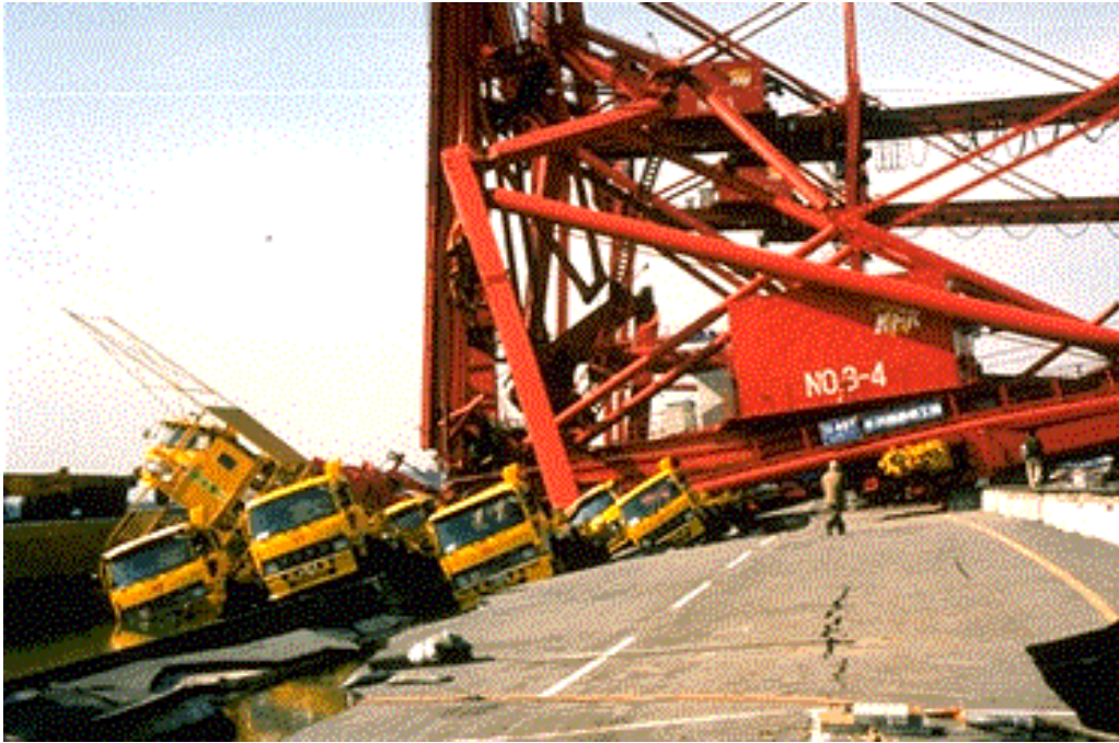
圖 1.1 神戶地震重力式沉箱碼頭側移滑動破壞
