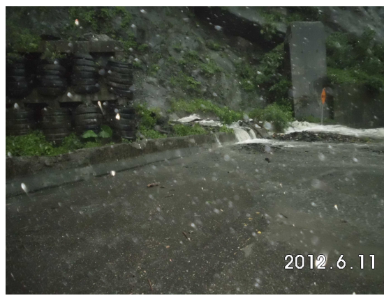
圖 4.40 台 24 線 30K+100 於 0609 豪雨事件道路阻斷情形
