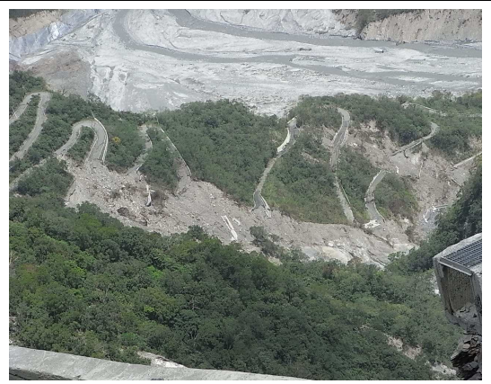
圖 4.64 台 24 線 46K+000 於莫拉 克颱風期間道路阻斷情形
