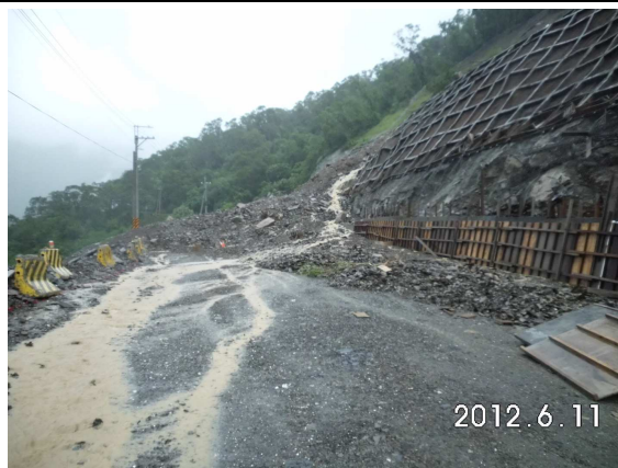
圖 4.41 台 24 線 31K+400 於 0609 豪雨事件道路阻斷情形
