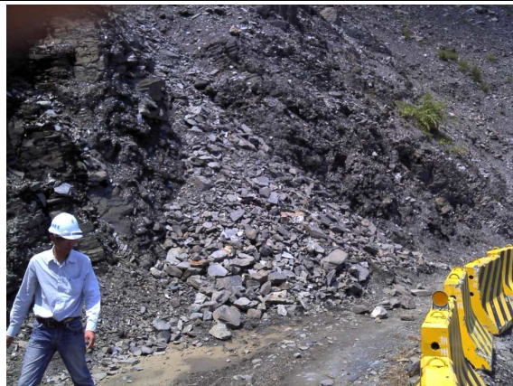
圖 4.63 台 24 線 45K+600 於 0420 豪雨事件道路阻斷情形
