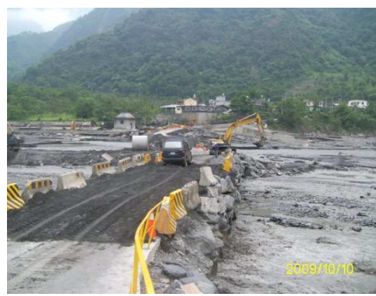
圖 4.44 台 24 線 32K+890 於芭瑪 颱風期間道路阻斷情形
