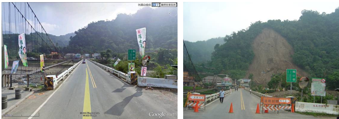
(b) 嘉義縣番路鄉觸口橋附近風災前與風災後道路封閉之路況(攝於 2012 年 8 月)。
