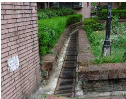
c. 社區綠覆空間-排水側溝
