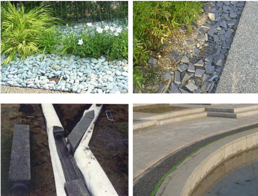
圖 4-9 雨水滲透溝、渠實例 (資料來源： http://www.neg.com.tw )
